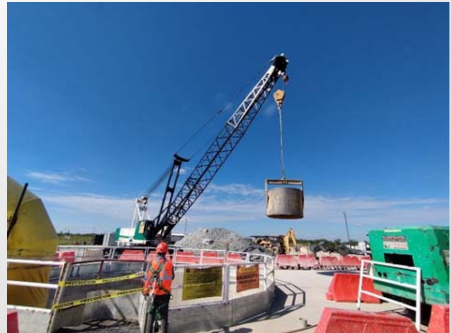
Figura 9: Rezaga de material en la lumbreira PCT-2.
