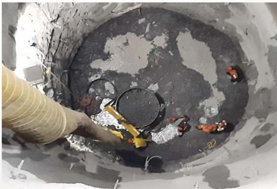
Figura 2: Retiro de material producto de la excavación mediante sistema de rezagado en la lumbreira PCT-1
