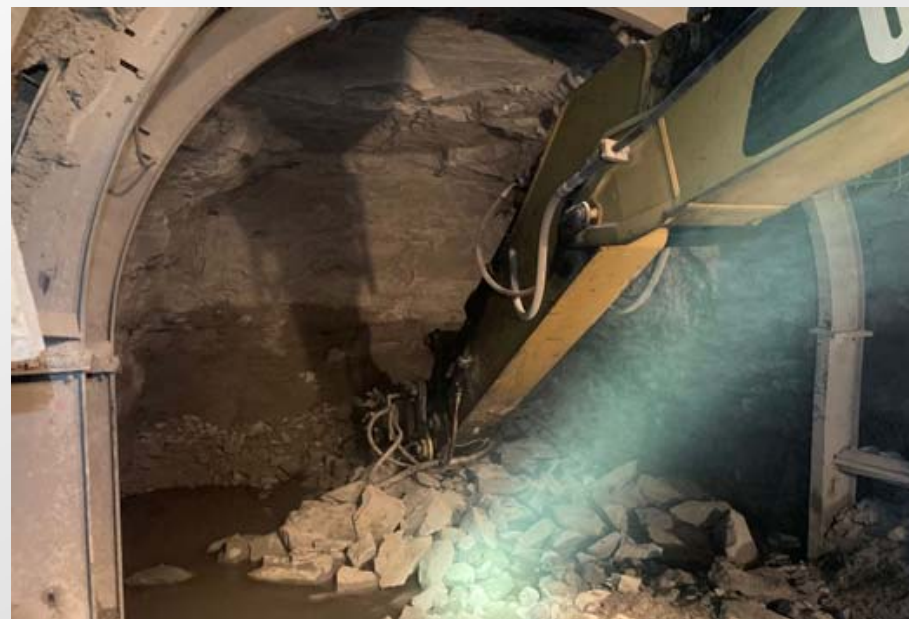
Figura 4: Excavación por medios mecánicos en túnel de ventilación.
