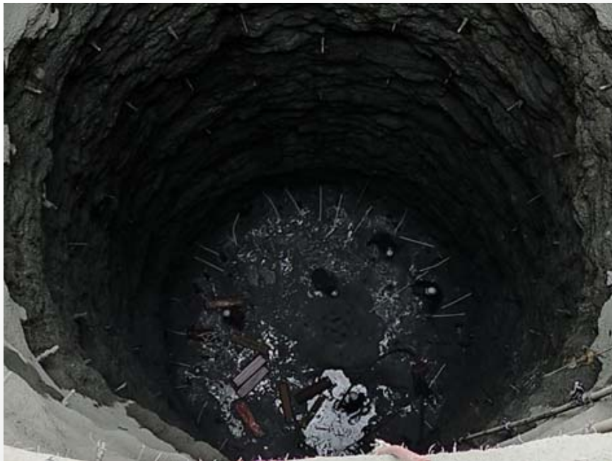
Figura 8: Carga de barrenos de plantilla para voladura en la lumbreira PCT-2.
