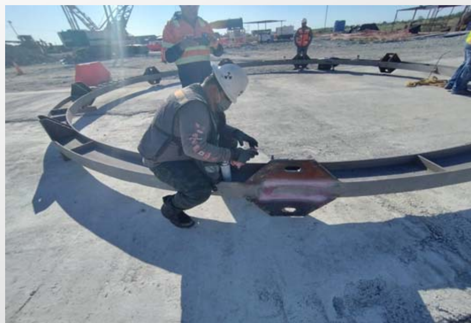
Figura 5: Armado de anillo metálico para la lumbreira PCT-1.
