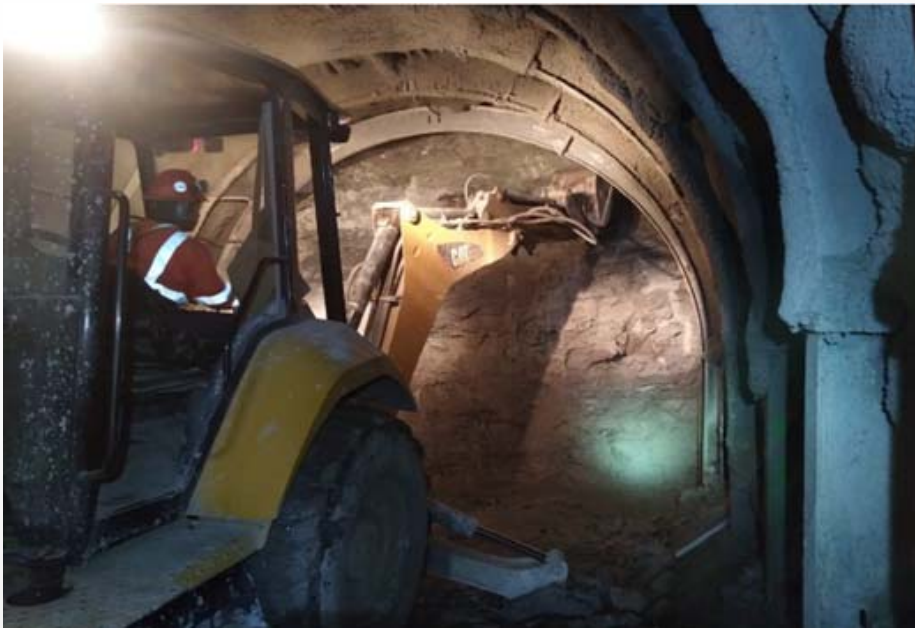
Figura 1: Perfilado de paredes por medios mecánicos en el túnel de acceso
