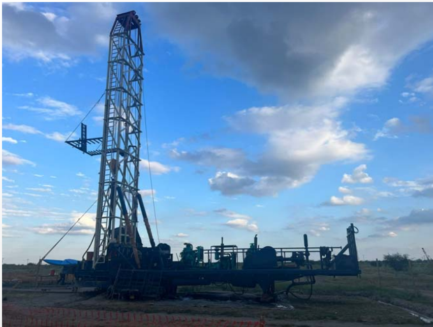
Figura 1: Trabajos de perforación del pozo PCE-04 . Se tienen 138 m de perforación con diámetro 12 ¼" y se comienza la ampliación con diámetro de 19" llegando a la profundidad de 7,00 m.
