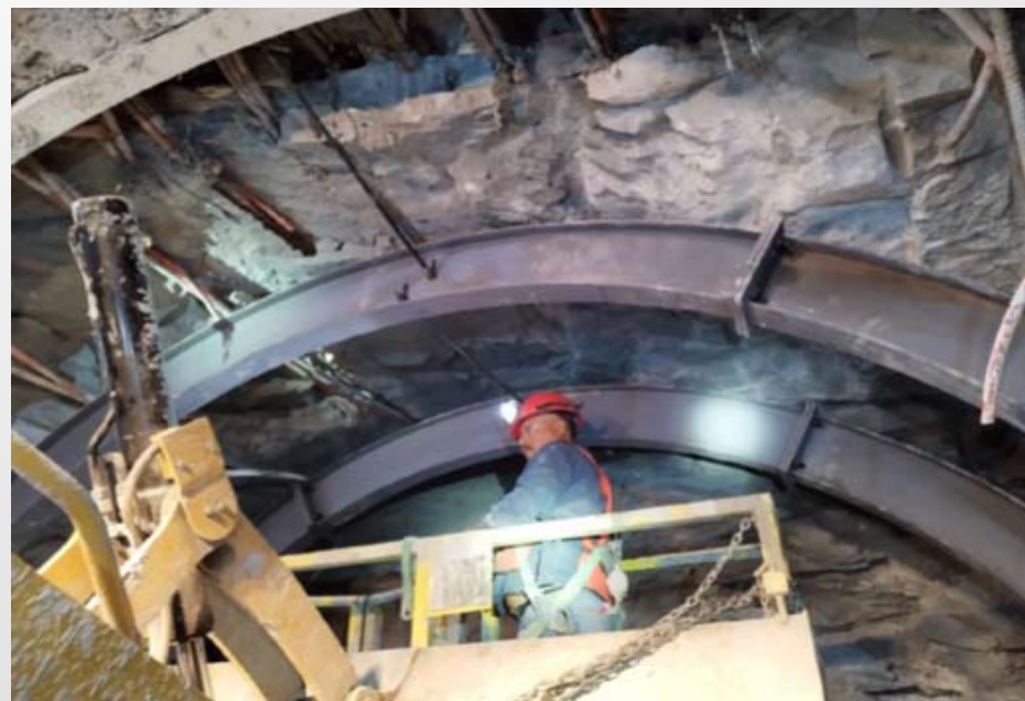
Figura 6: Colocación de marcos metálicos en túnel de ventilación
