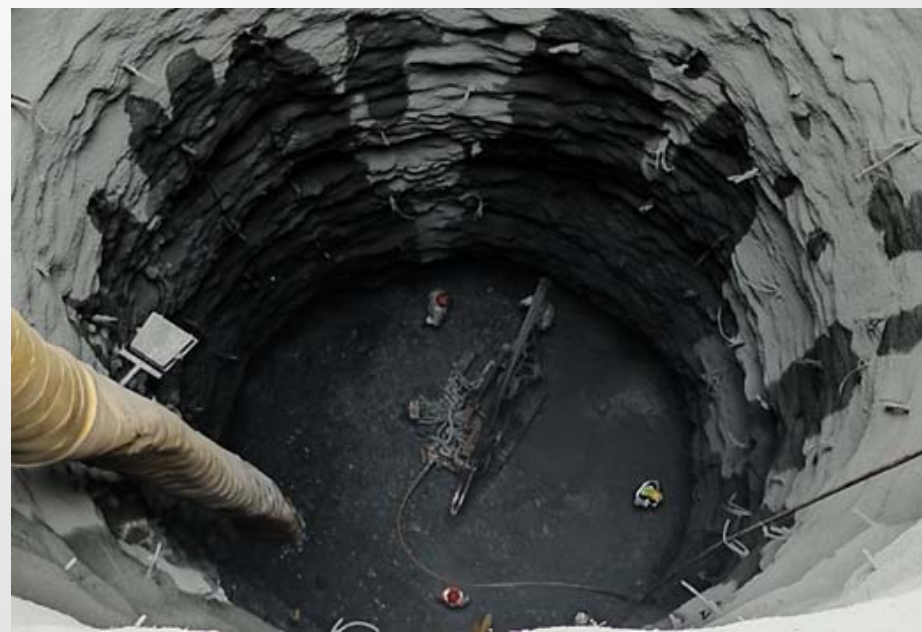
Figura 3: Perforación de barrenos para anclas en la lumbreira PCT-1.
