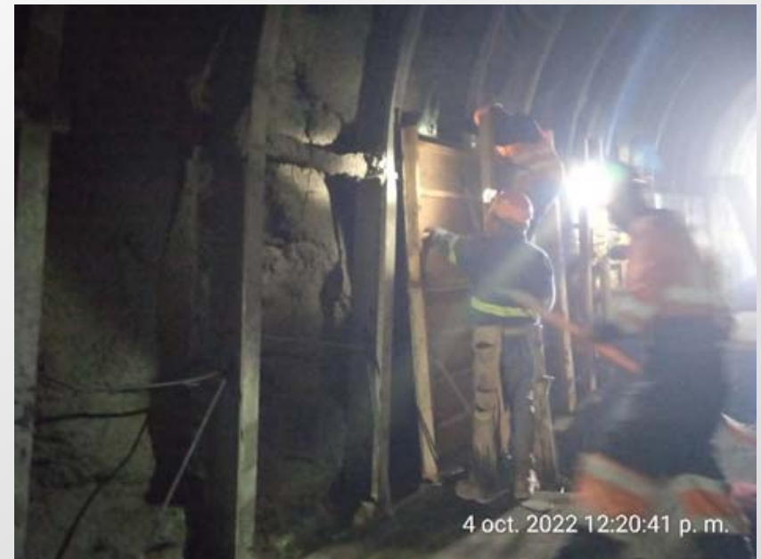
Figura 2: Colocación de madera para hastiales en el túnel de acceso.
