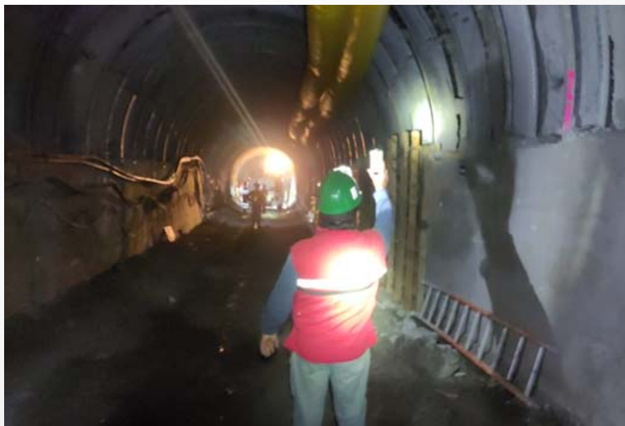
Figura 3: Toma de lectura de gases en el túnel de acceso.
