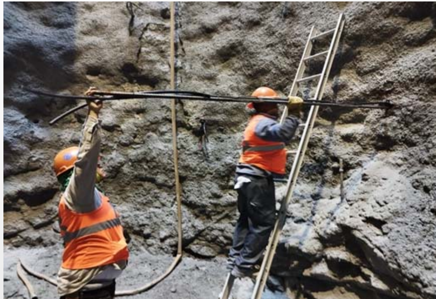
Figura 10: Colocación de anclas en la lumbreira PCT-2.
