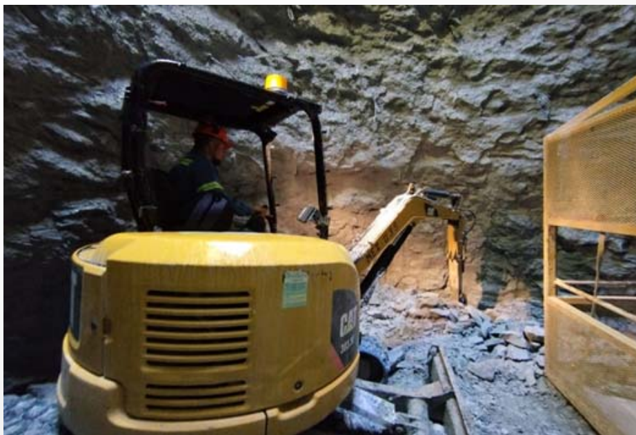
Figura 4: Perfilado de paredes en la lumbreira PCT-1.
