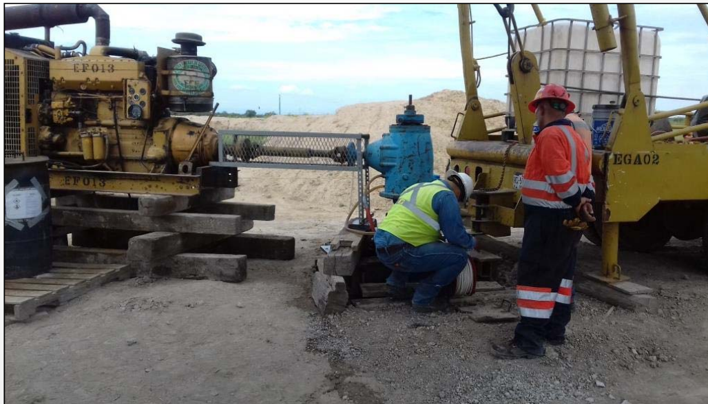
Figura 3: Extracción de agua en el pozo PCV-02, con descarga en el cárcamo aireador.
