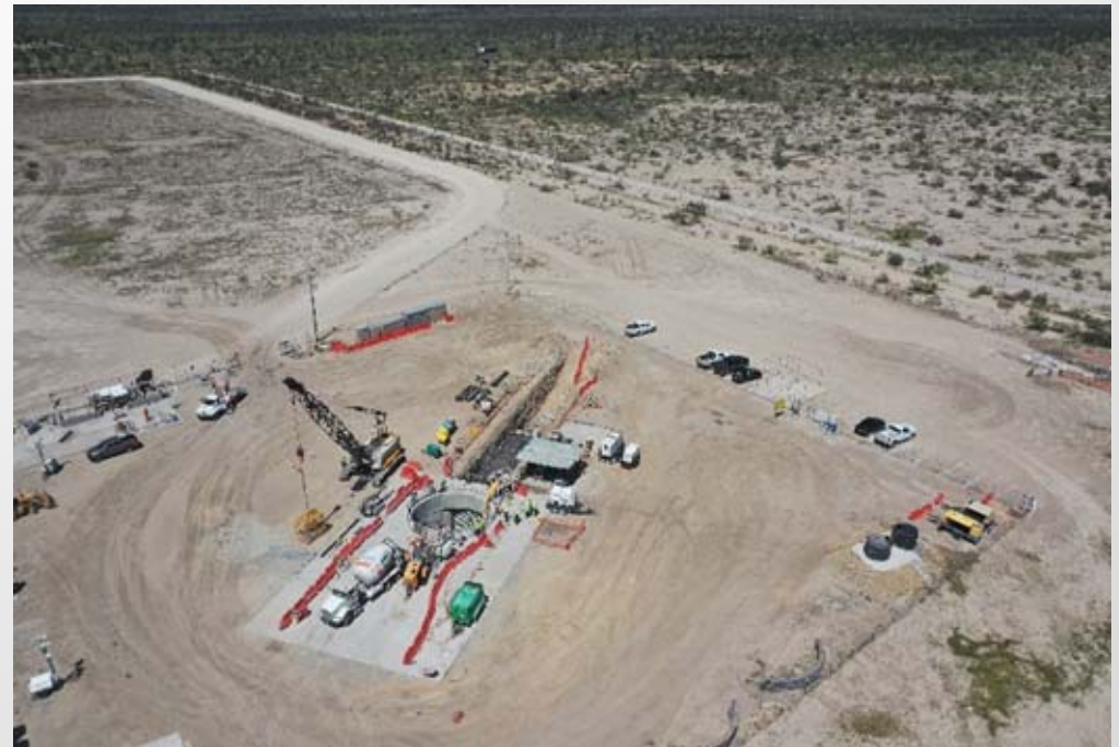
Figura 7: Vista aérea de la lumbrera PCT-2.
