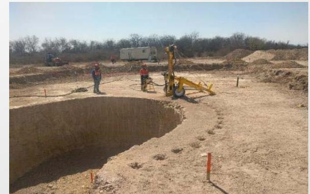
Figura 1: Perforación en el área exterior del brocal del Tiro Vertical PCT-2.
