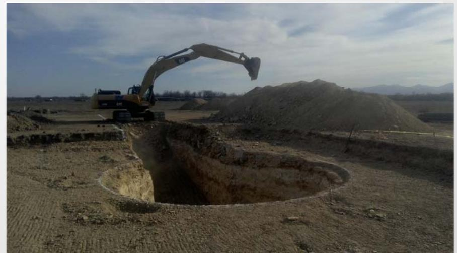
Figura 4: Excavación en galería del Tiro Vertical PCT-1.
