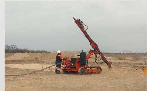
Figura 2: Habilitado del equipo; Track drill del Tiro Vertical PCT-2.
