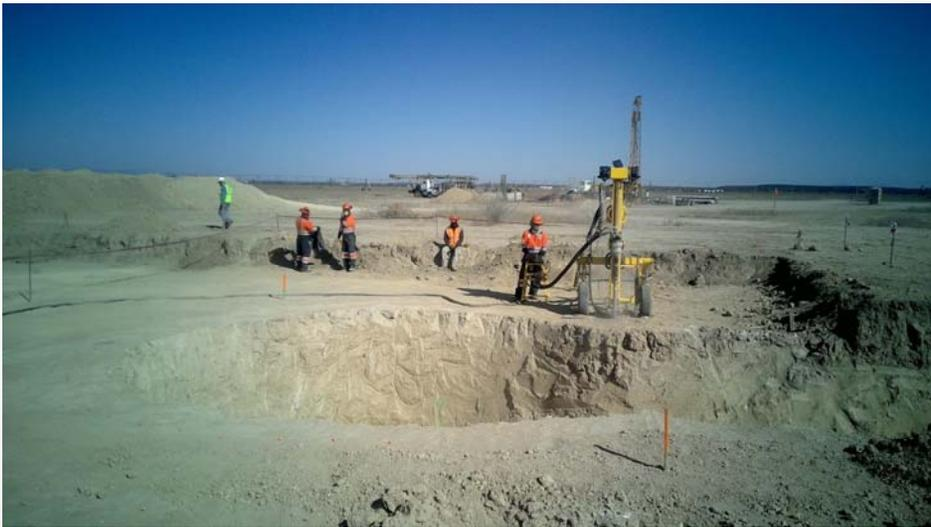
Figura 3: Perforación en el área exterior del brocal del Tiro Vertical PCT-2.
