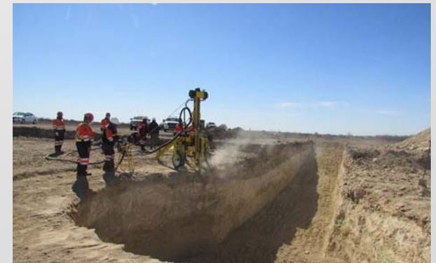
Figura 2: Perforación perimetral para anclaje de brocal
