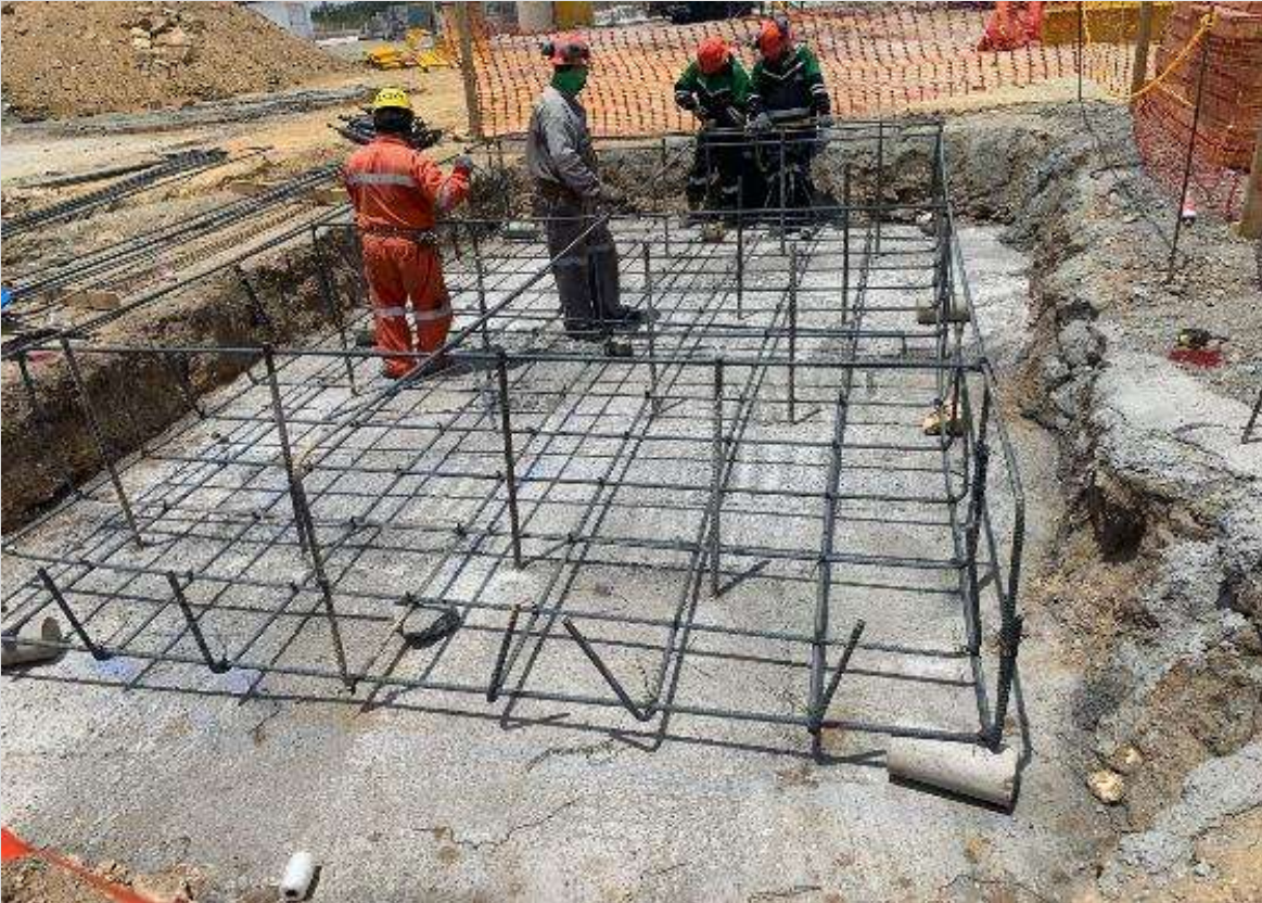
Imagen 3. Acero de refuerzo en cimentación de malacate en PCT-1.
