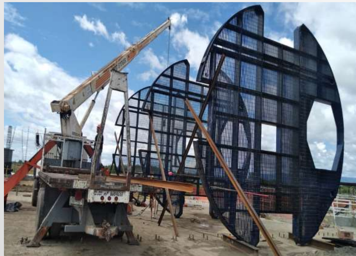
Imagen 6. Colocación de postes metálicos del Galloway PCT-1.
