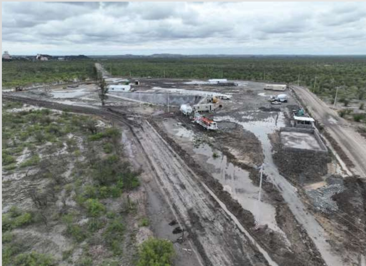
Imagen 7. Panorámica de Rampas (16.05.2023).
