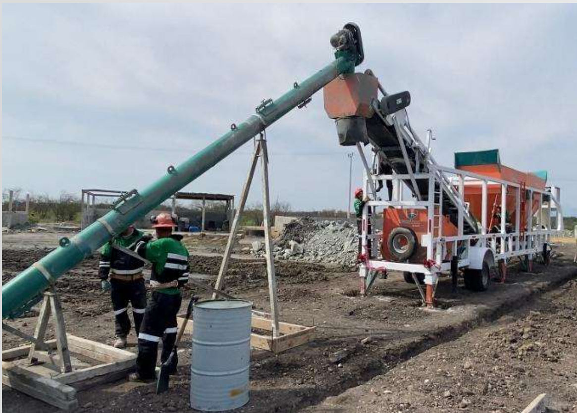
Imagen 9. Instalación de la Planta de Concreto.
