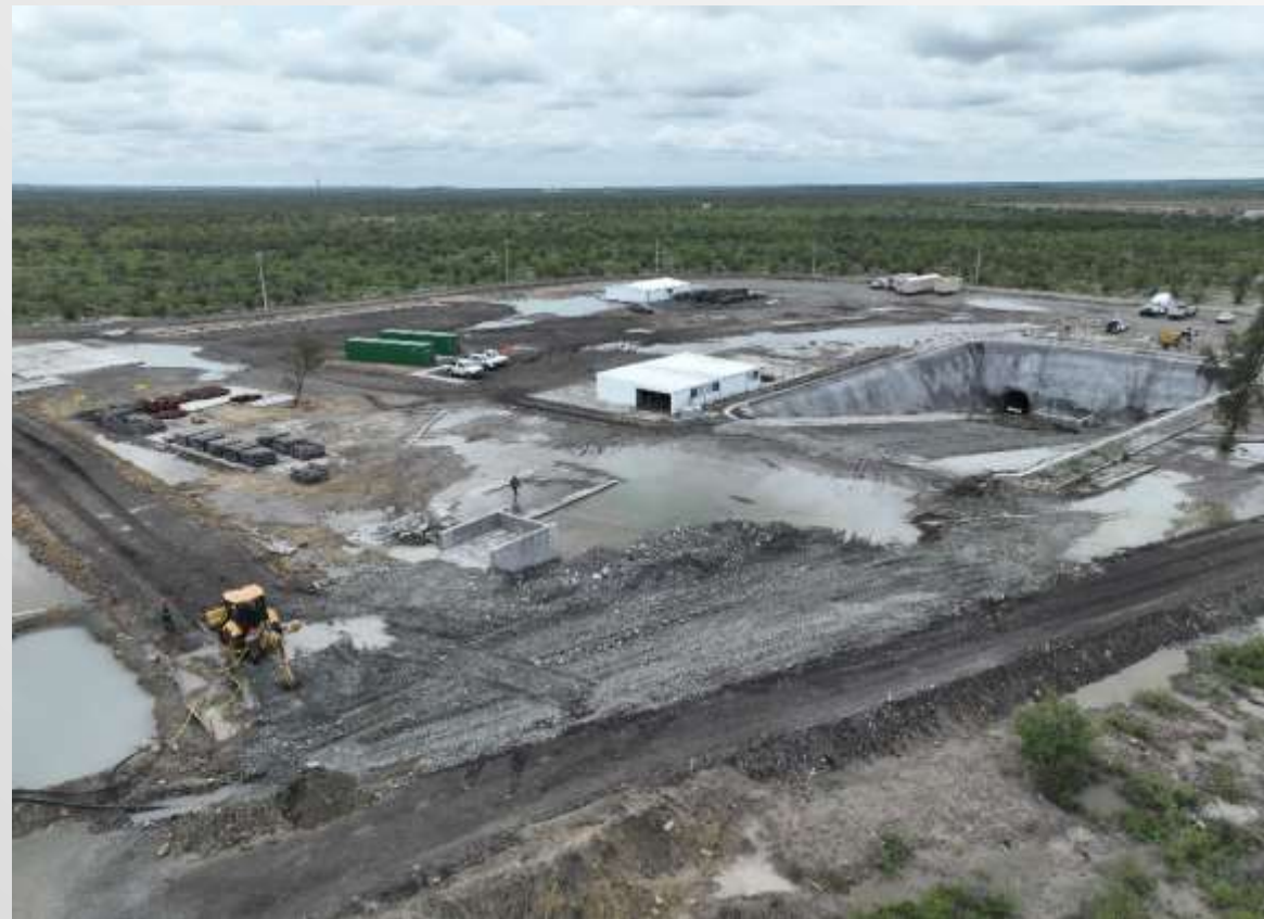
Imagen 8. Panorámica de Rampas (16.05.2023).
