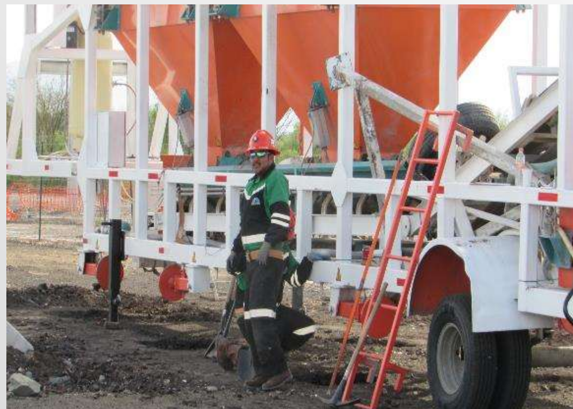
Imagen 10. Excavación para la cimentación de la Planta de Concreto.
