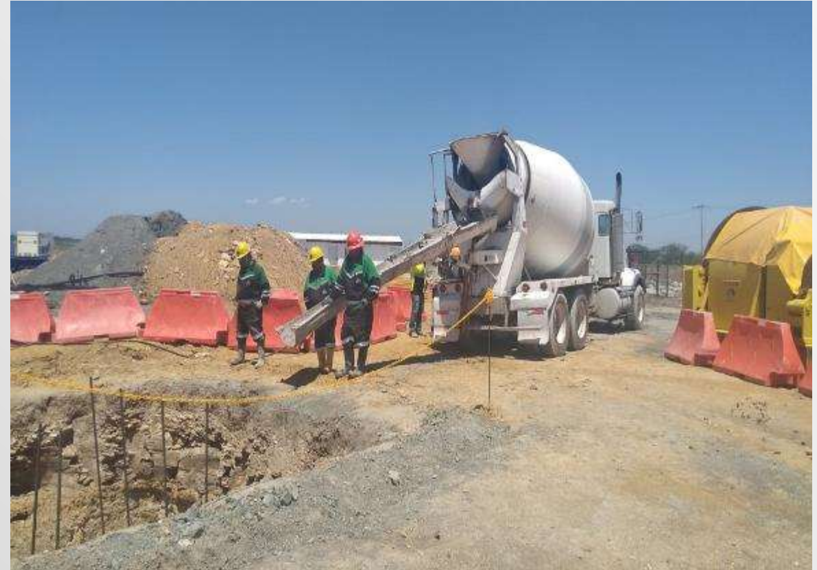
Imagen 4. Colocación de concreto en zapata de cimentación de malacate
