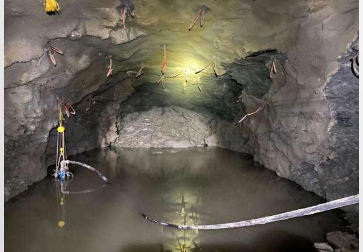
Imagen 12. Extracción de agua en Túnel de Ventilación
