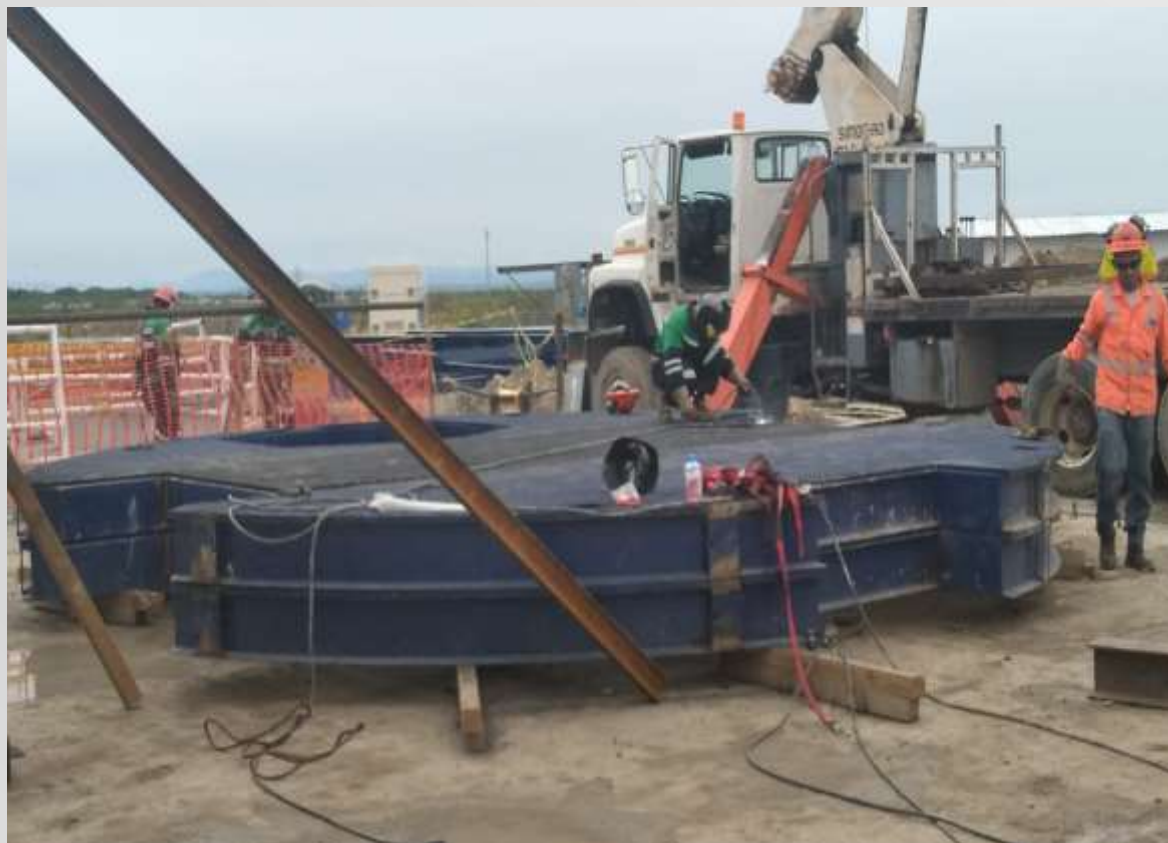
Imagen 5. Soldadura en elementos de base de Galloway en PCT-1.
