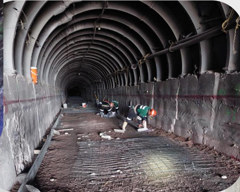
Imagen 13. Colocación de cimbra en Túnel de Ventilación.
