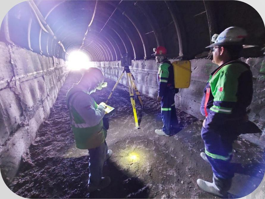
Imagen 12. Levantamientos topográficos en Túnel de Ventilación.
