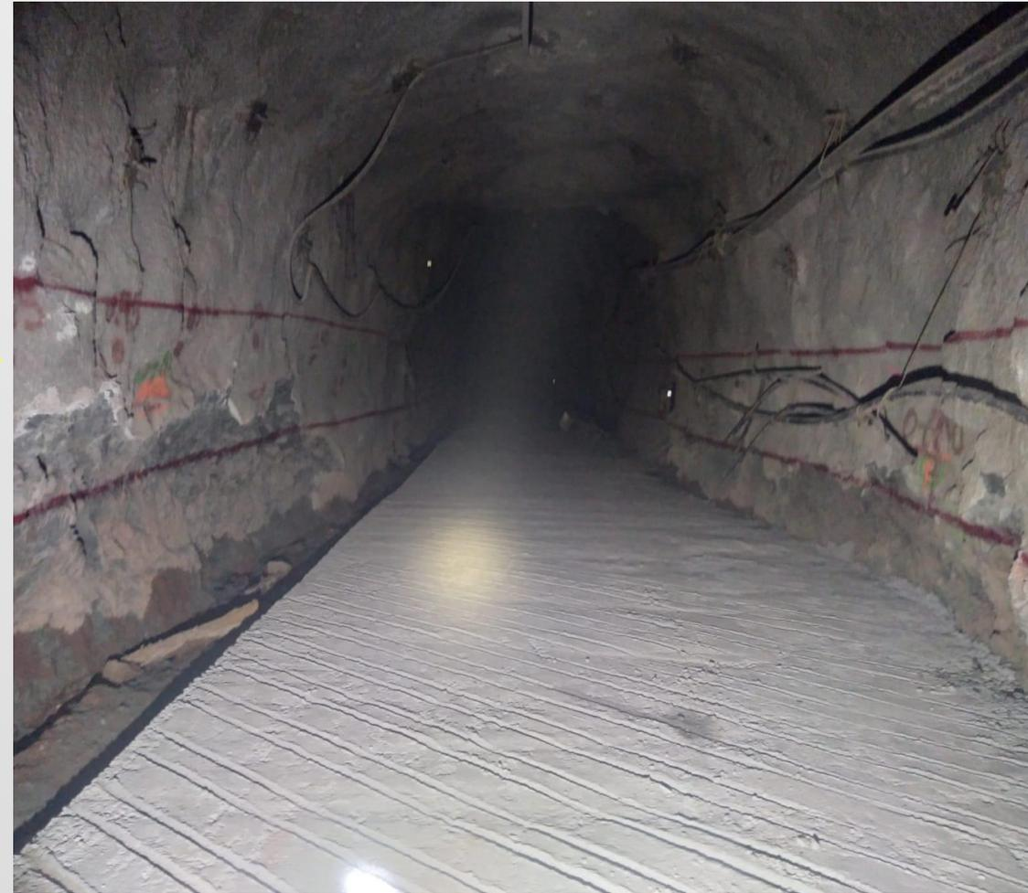
Imagen 9. A la fecha se realiza el colado de losa en ambos túneles.
