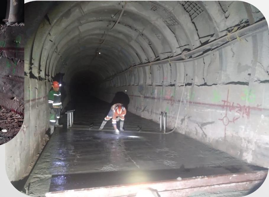
Imagen 14. Colado de concreto en Túnel de Ventilación.
