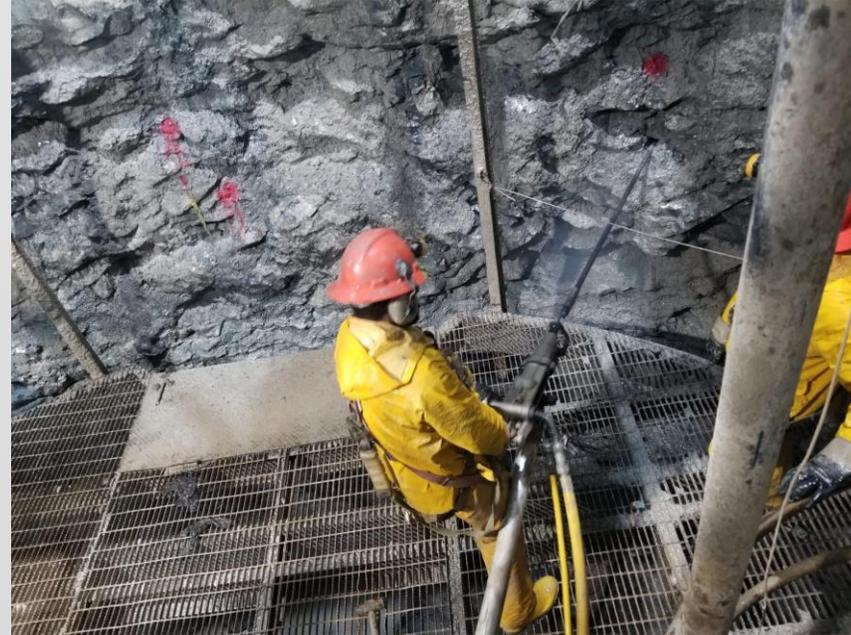
Foto 3. Instalación de anclas.
