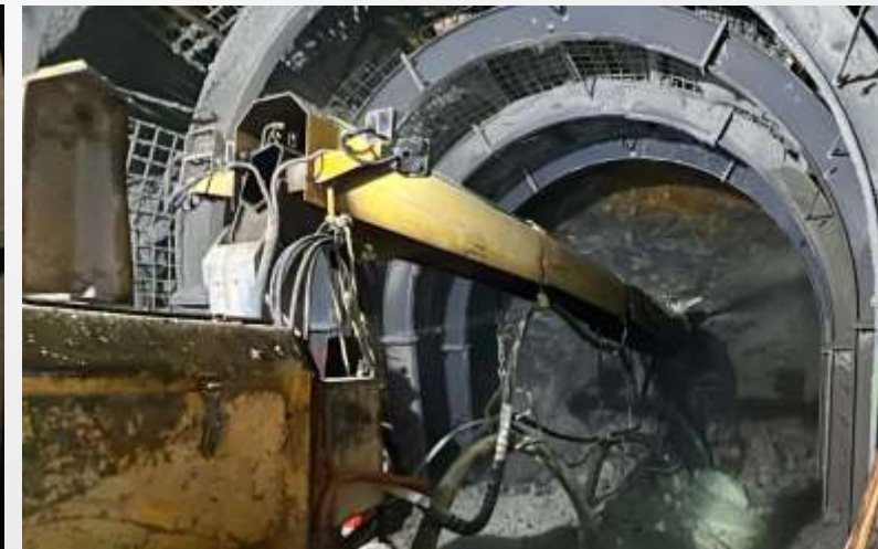
Imagen 9 – Aplicación de concreto lanzado
