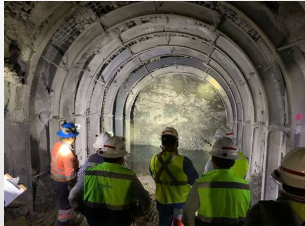
Figura 2: Inspección geológica geotécnica del frente de excavación del túnel de ventilación en el Portal de entrada.
