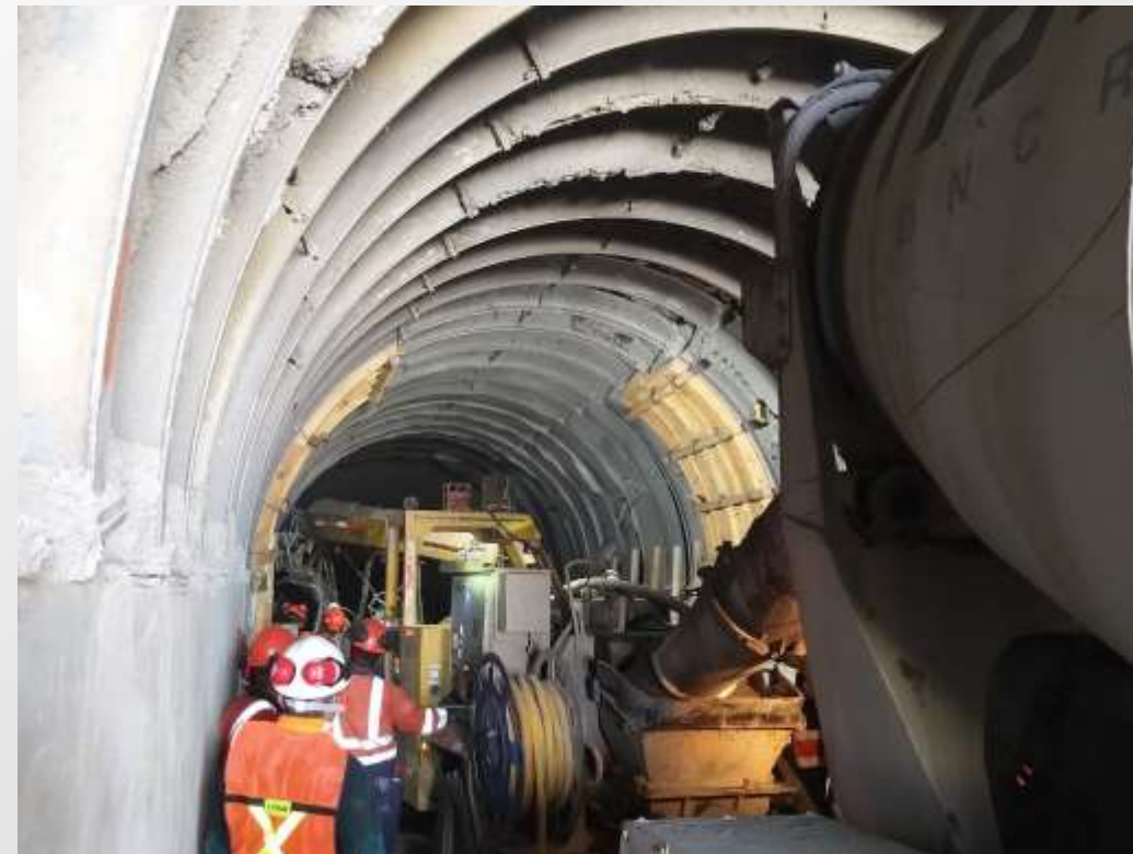
Figura 4: Colado de hombros en el interior del túnel de acceso.
