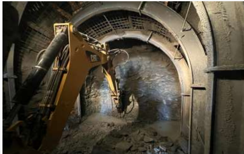
Imagen 8 – Excavación de túnel
