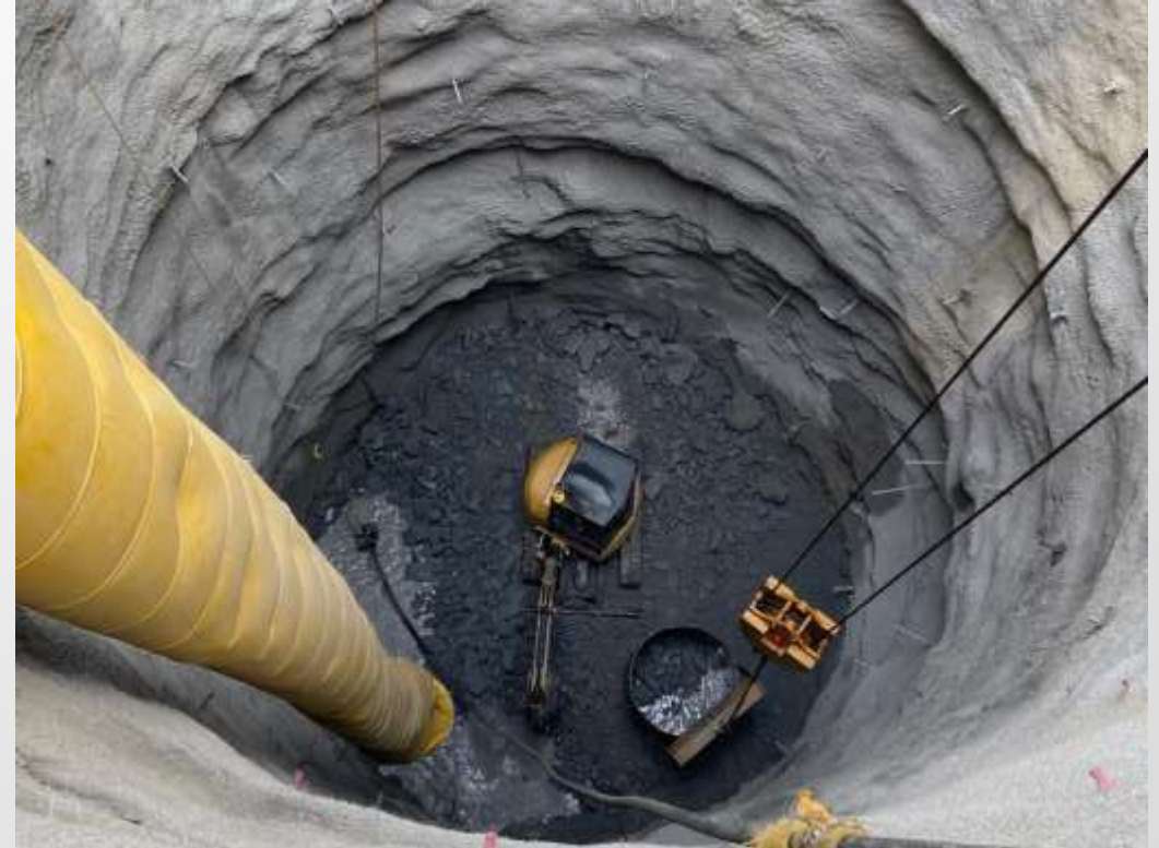
Figura 3: Retiro del material resultado de la voladura en el tiro vertical PCT-1.
