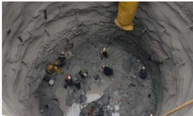
Imagen 2 – Trabajos de perforación de barrenos para plantillas de voladura
