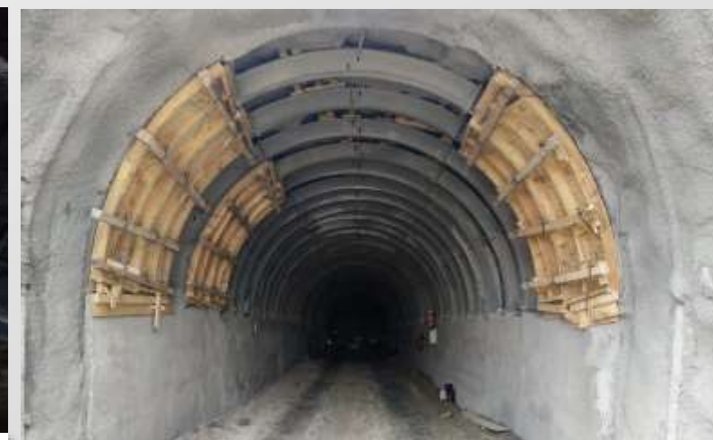
Imagen 12 – Colado de paredes de los túneles.
