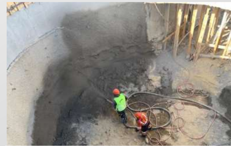
Imagen 6 – Trabajos de concreto lanzado.
