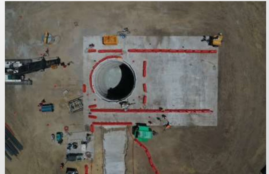
Figura 1: Vista aérea de la lumbrera PCT-1.
