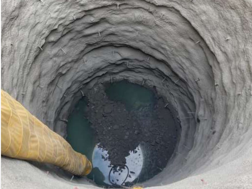
Figura 2: Trabajos de bombeo de agua en lumbrera PCT-1.
