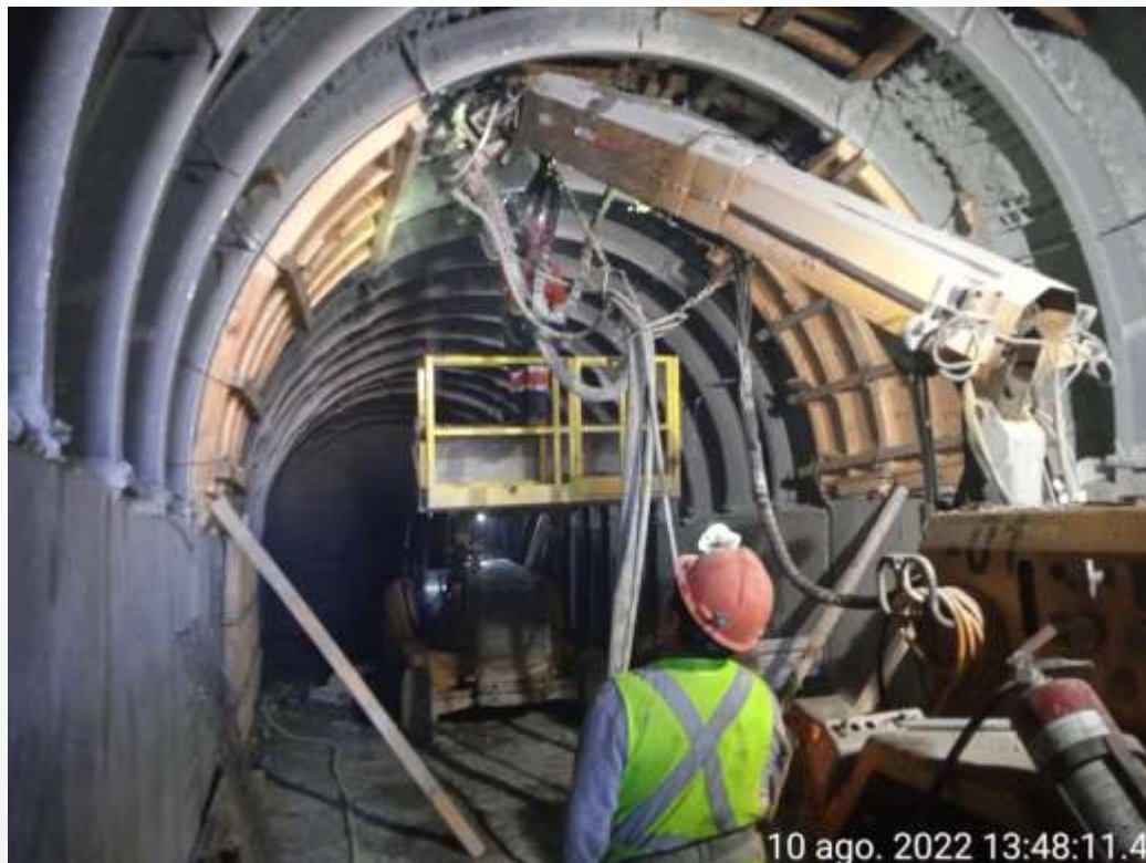
Figura 3: Habilitado de cimbra para empaque de hombros en túnel de acceso.
