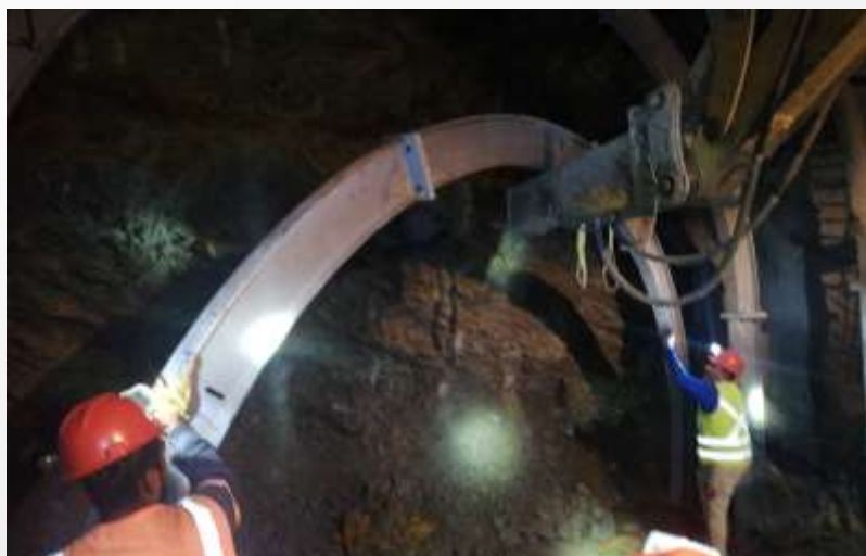
Imagen 10 – Colocación de marco metálico.
