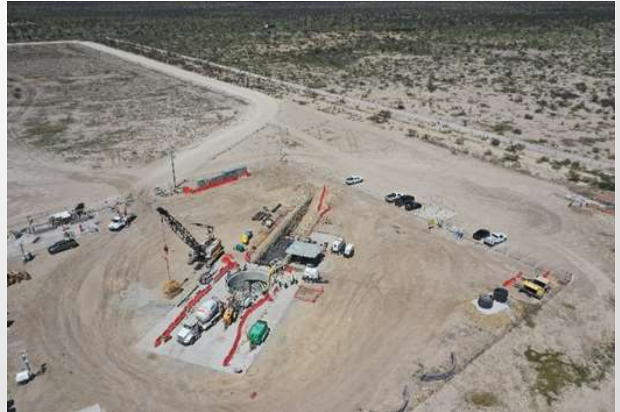
Figura 4: Vista aérea de la lumbrera PCT-1.
