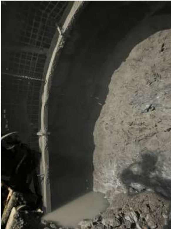
Figura 1: Colocación de concreto lanzado en frente de excavación de túnel de ventilación del Portal de Entrada.
