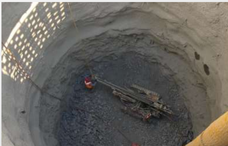
Imagen 5 – Perforación e inyección de anclas.
