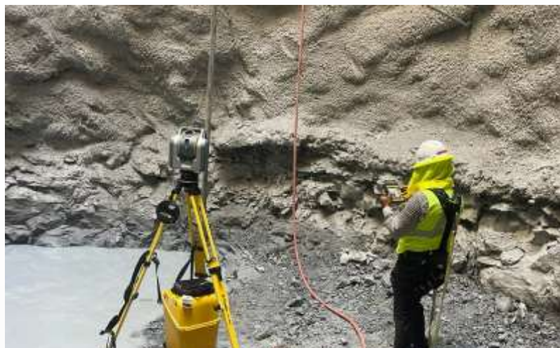
Imagen 1 – Levantamiento topográfico en lumbrera.
