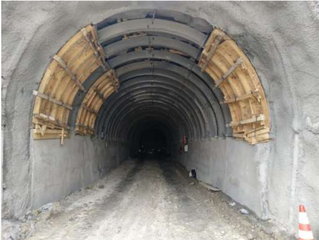
Figura 5: Habilitado de cimbra en túnel de acceso
