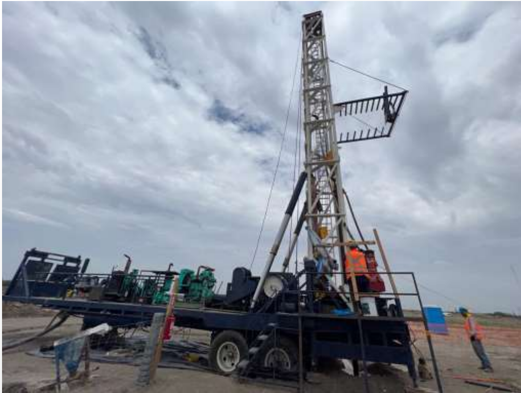
Figura 1: Trabajos de perforación del pozo PCE-04. Se tienen 42 m de perforación
