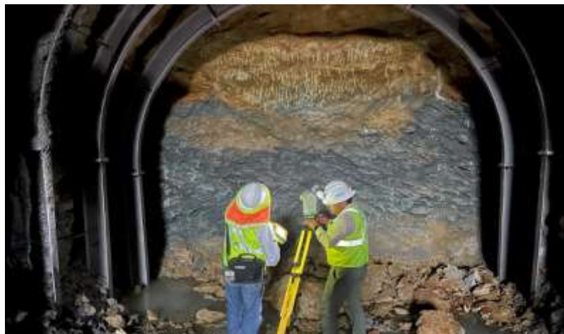
Imagen 7 – Levantamiento topográfico en túneles de acceso y ventilación.
