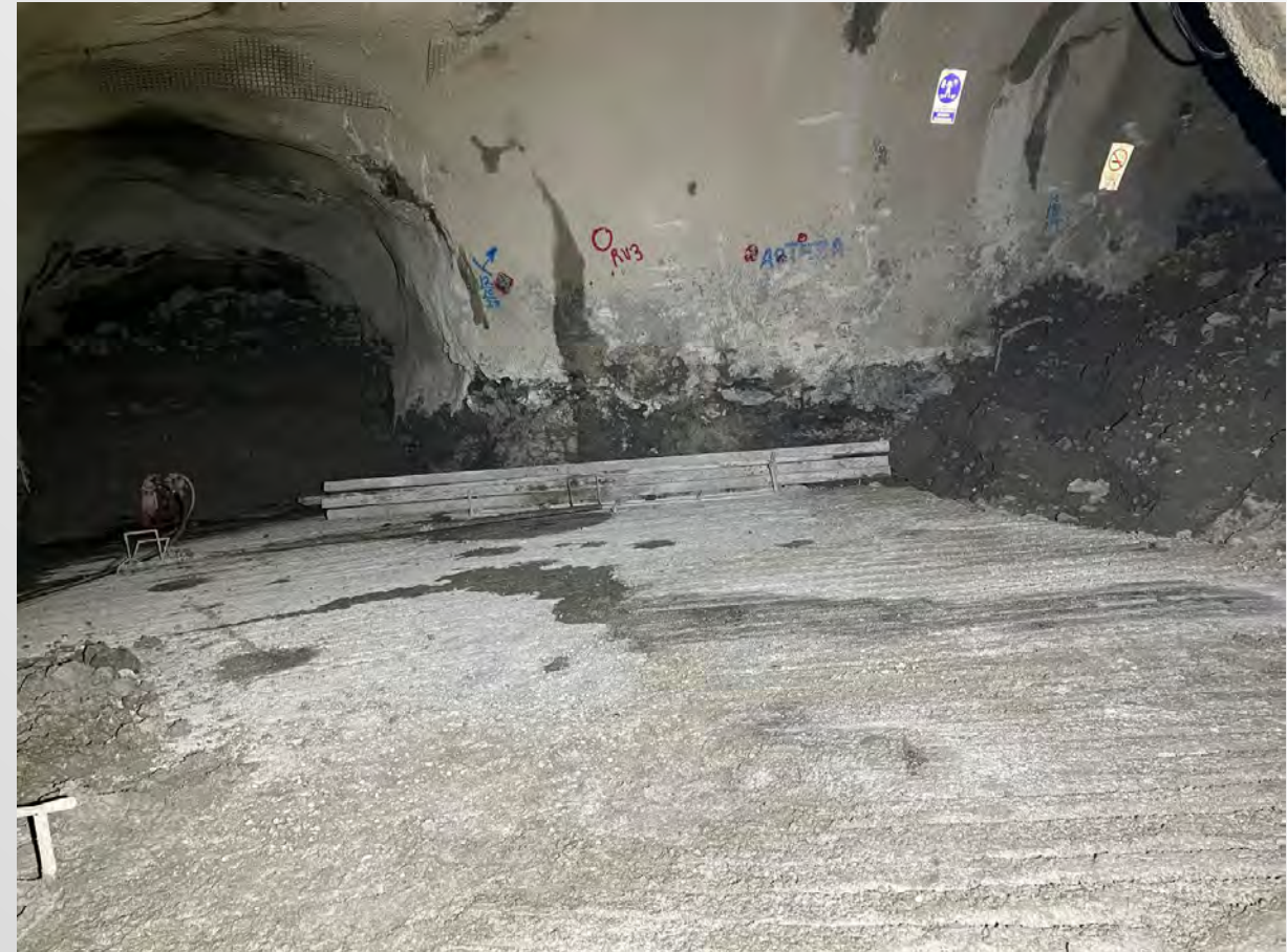
Foto 9. Colocación de losa de concreto.
