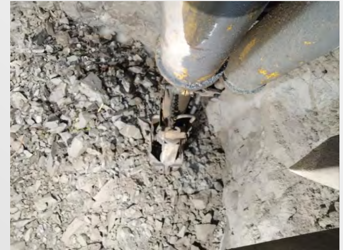
Foto 2. Material producto de la voladura.
