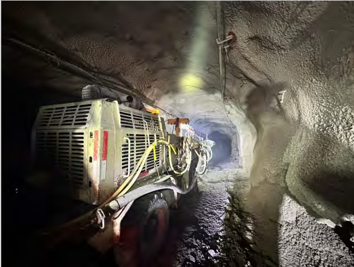
Foto 8. Trabajos de lanzado de concreto.
