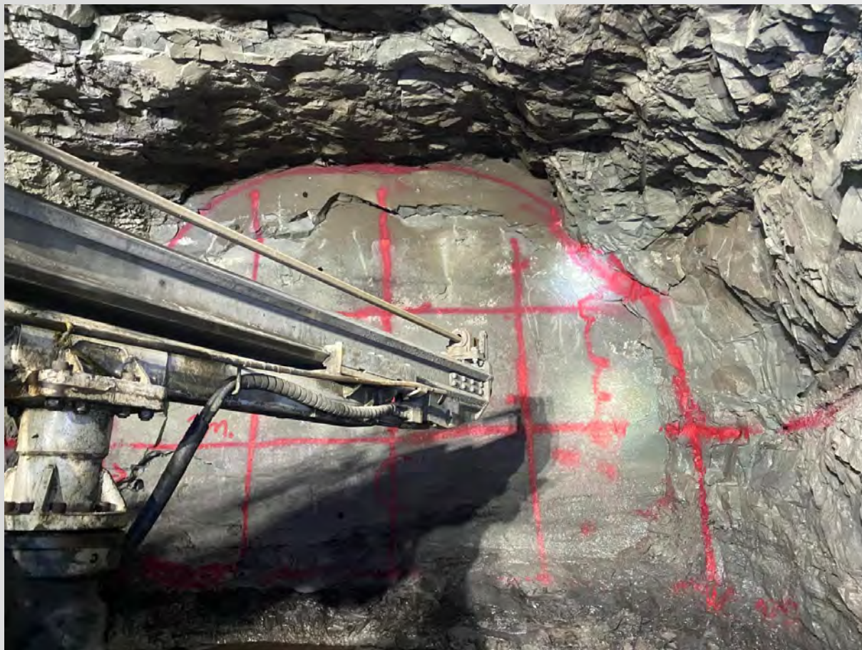
Foto 7. Actividades para marcar la plantilla de voladura.
