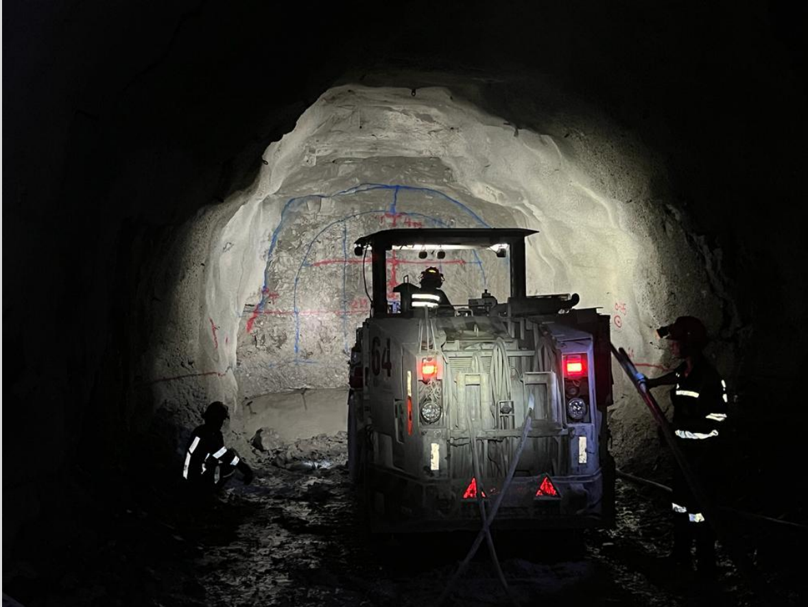
Foto 6. Barrenación de plantilla de voladura en Túnel de Acceso.
