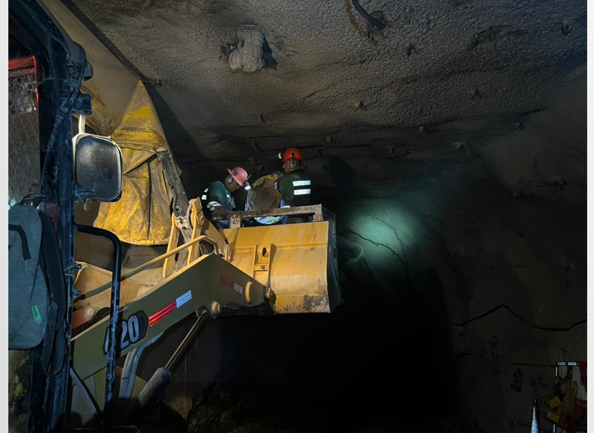
Foto 7. Colocación de servicios en Túnel de Acceso.
