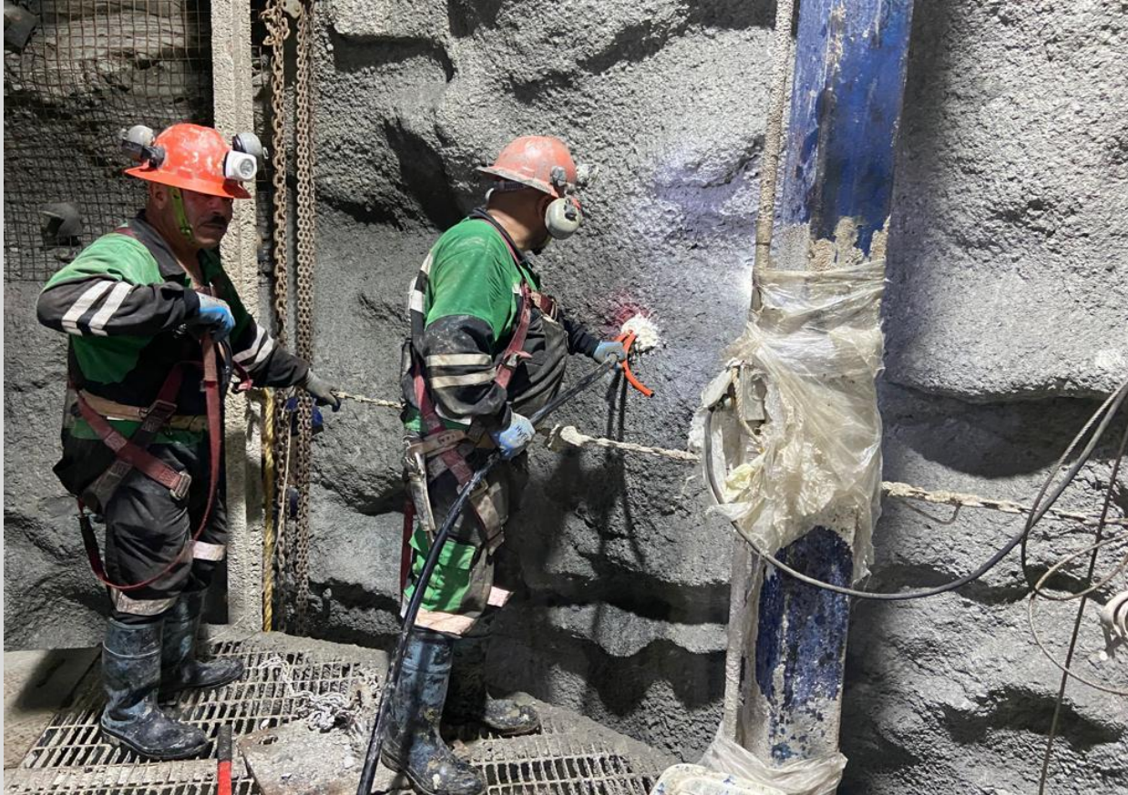
Foto 1. Colocación de anclas al interior de Lumbrera PCT-1.
