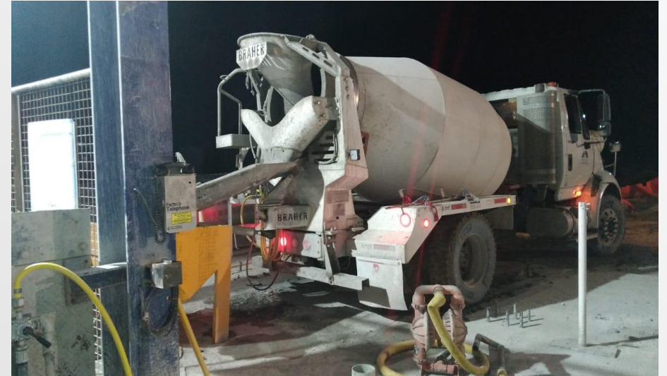
Foto 2. Suministro de concreto para Lumbrera PCT-1.
