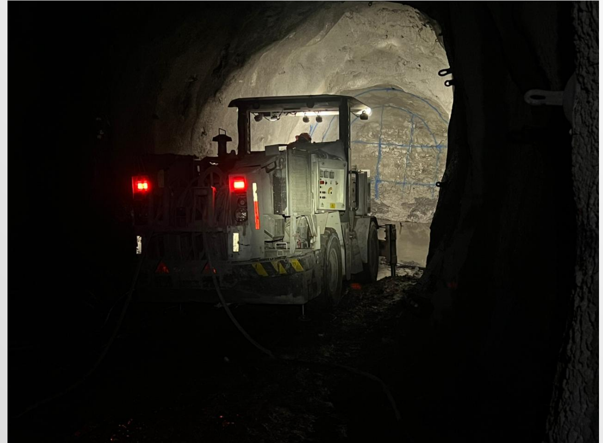
Foto 9. Barrenación de plantilla de voladura en Túnel de Ventilación.
