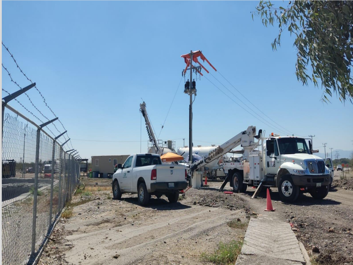
Foto 8. Trabajos de conexión de la subestación a la red general por parte de CFE-Distribución.
