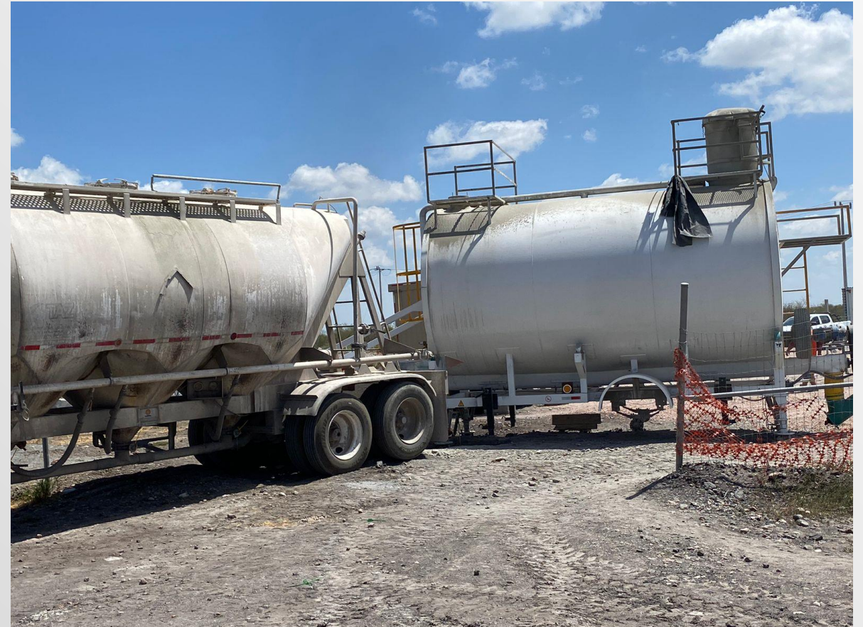
Foto 8. Suministro de concreto para la colocación de lanzado de concreto.
