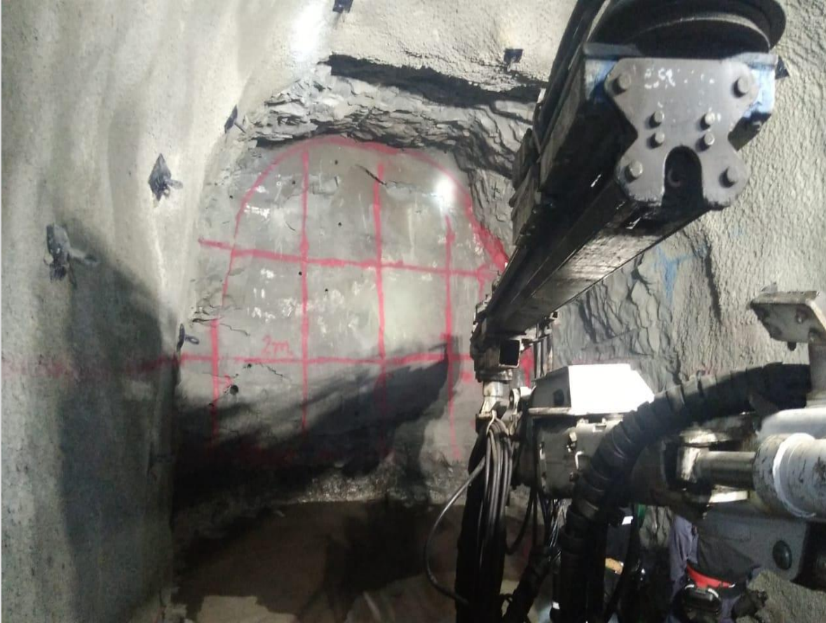
Foto 9. Actividades de barrenación en Túnel de Ventilación.
