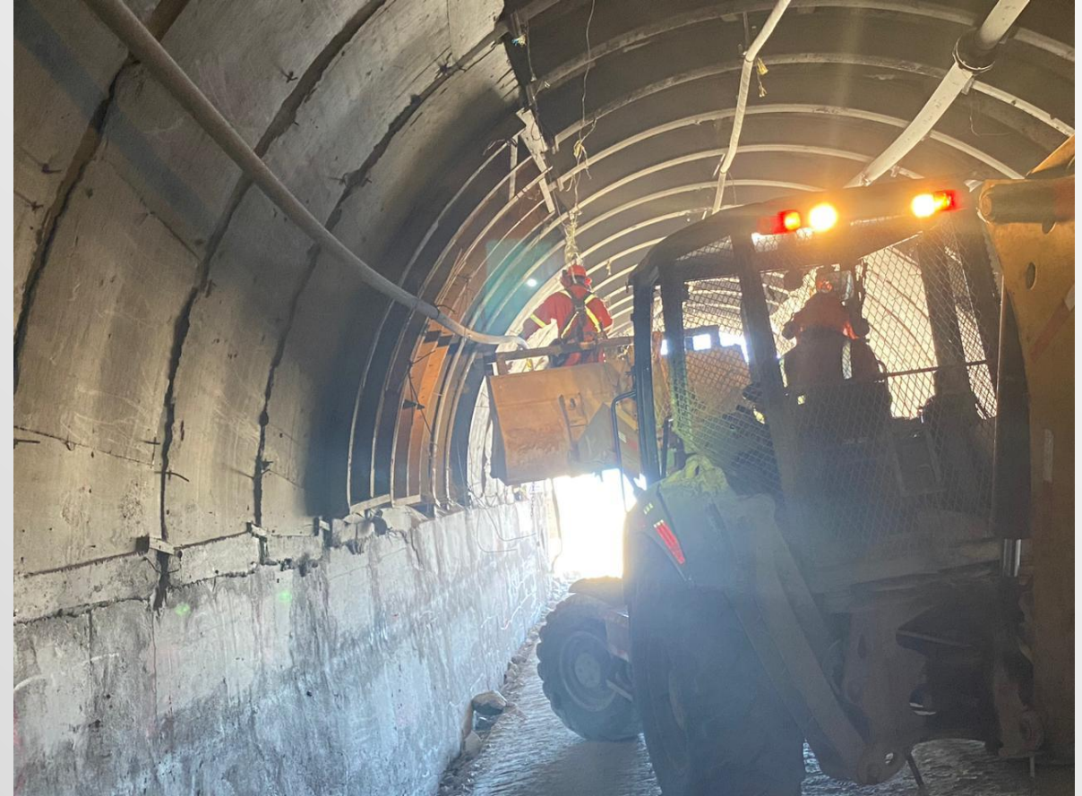
Foto 10. Colocación y actualización de servicios conforme los avances.
