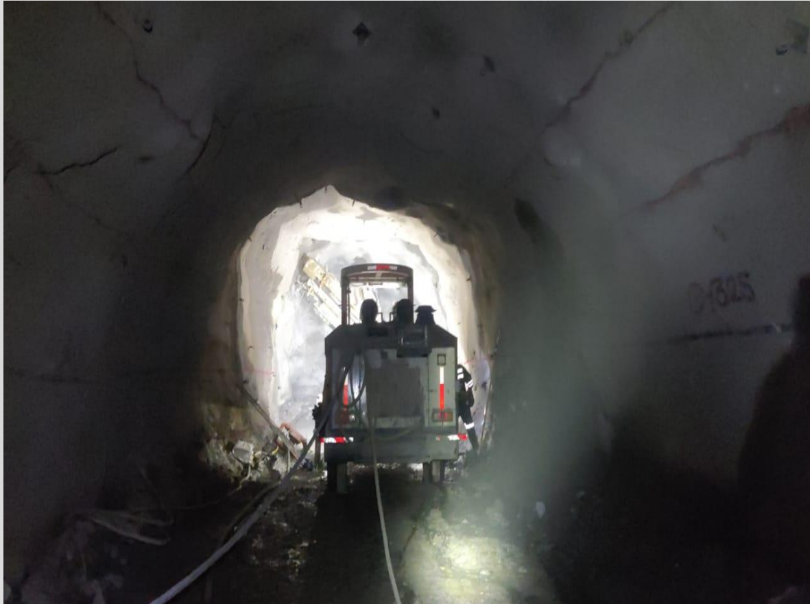
Foto 7. Colocación de anclas en Túnel de Acceso
