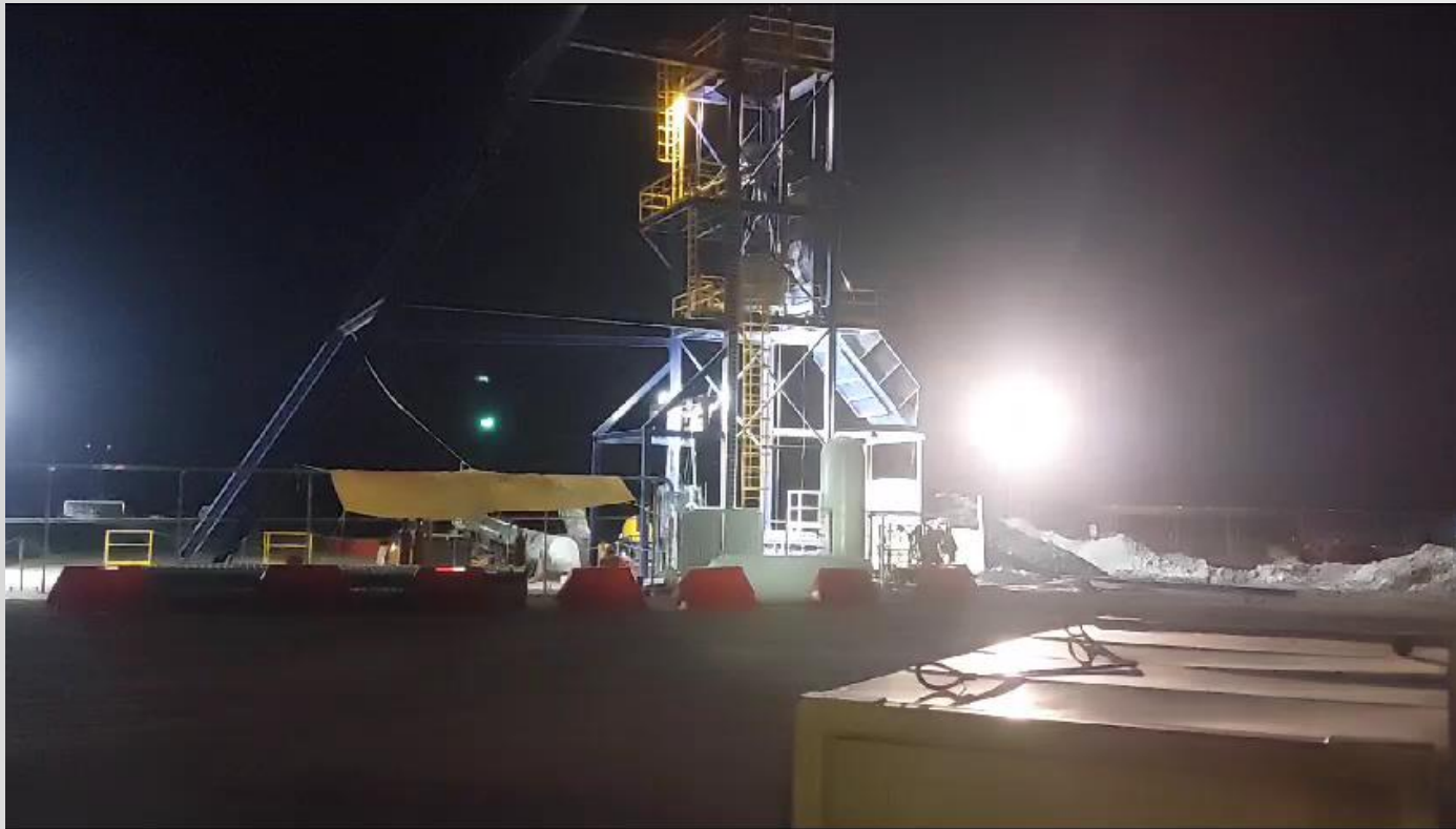
Video 1. Se efectúa voladura en Lumbrera PCT-1.
