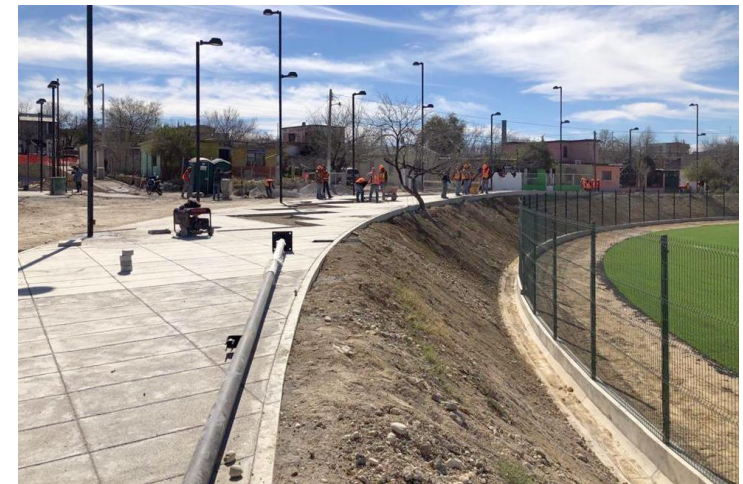
Colocación de luminarias
