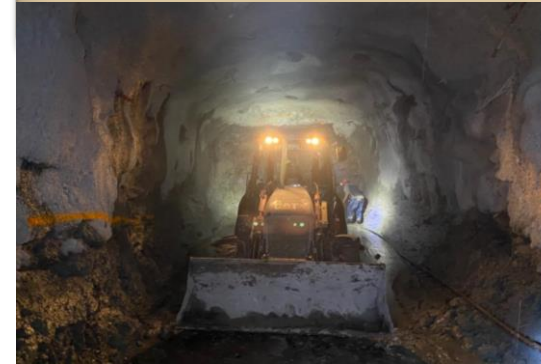
Túnel de Ventilación
