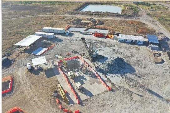
Construcción de Lumbrera 1
