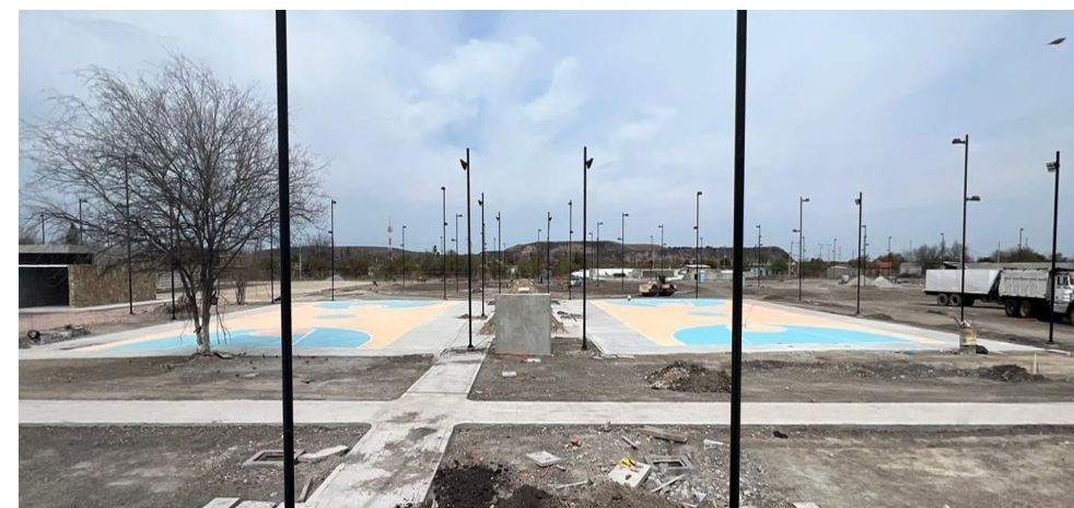
Avance en canchas de usos múltiples
