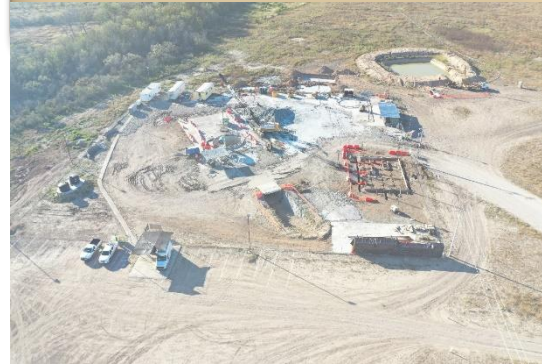
Construcción de Lumbrera 2
