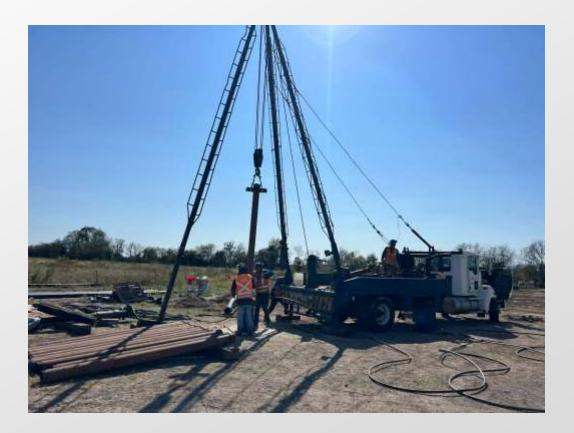
Figura 2: En el **PCV-3A** se termina instalación y se hace prueba de aforo. La siguiente actividad será su equipamiento.
