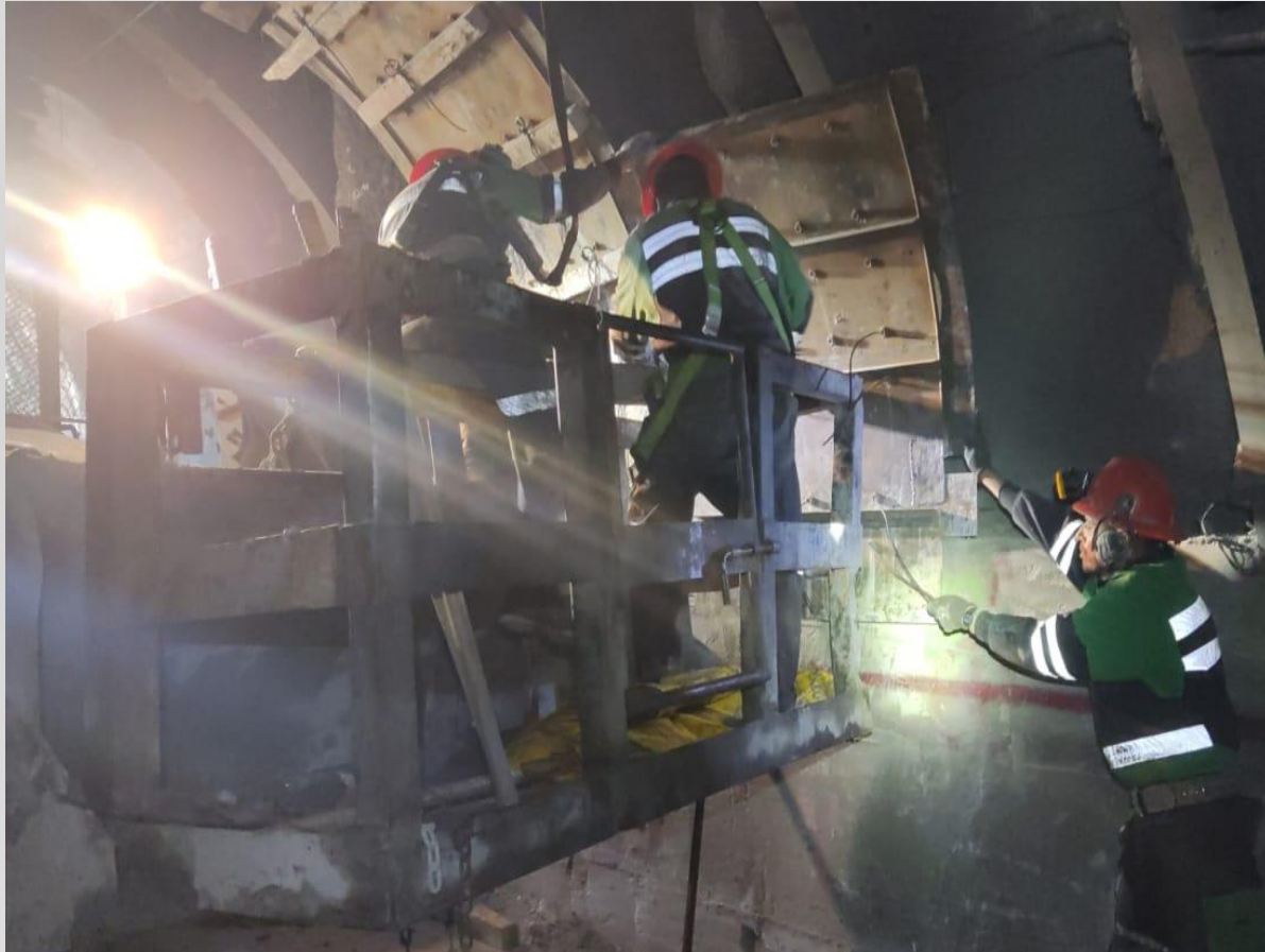
Foto 8. Actividades para el colado de marcos.
