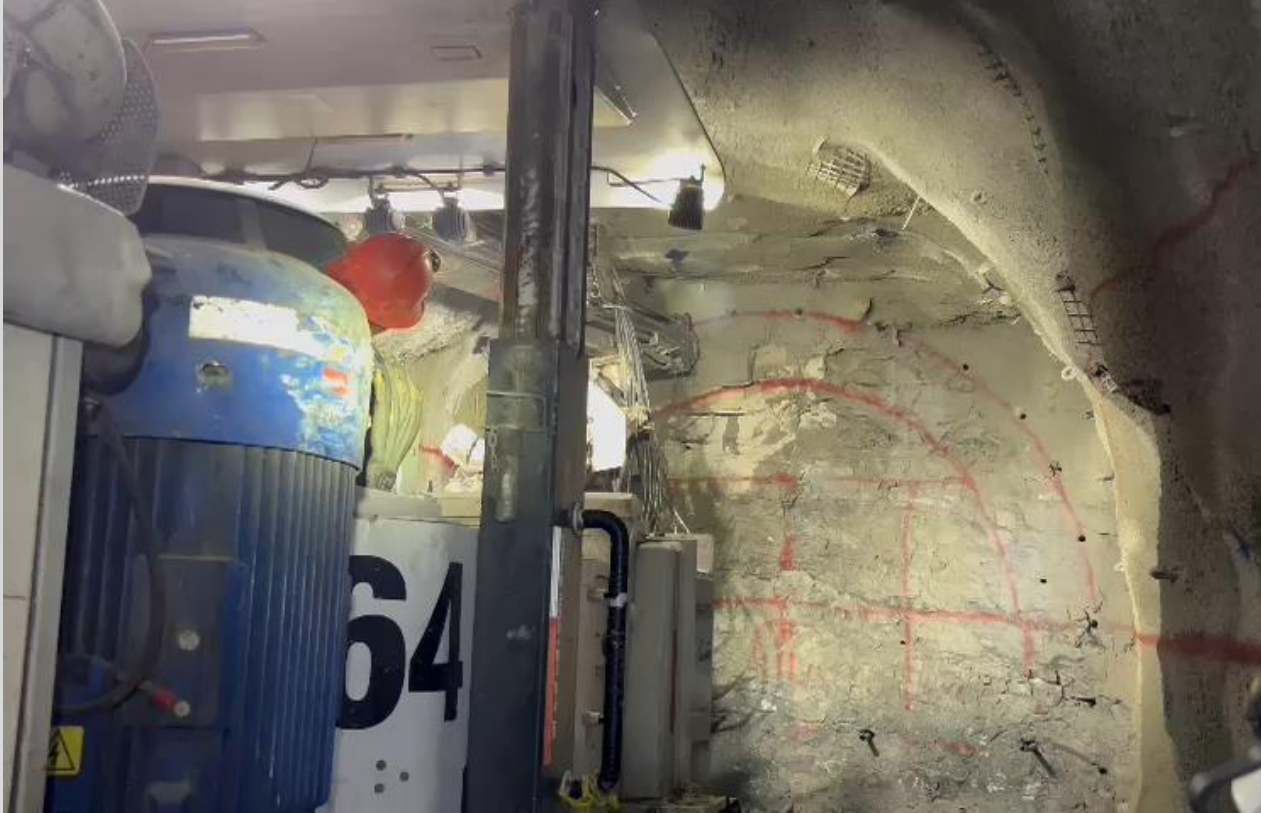
Video 1. Trabajos de barrenación de la plantilla para voladura.
