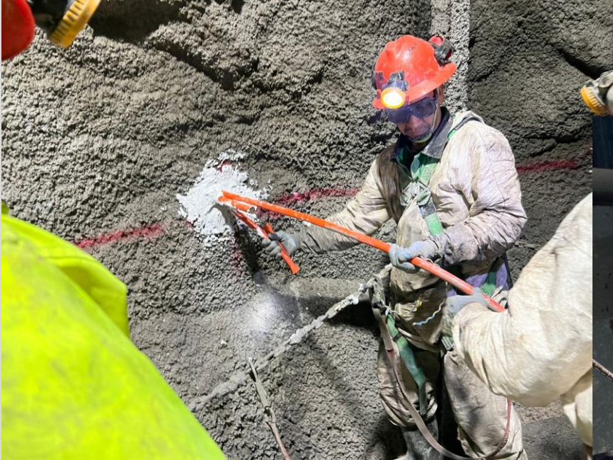
Figura 1. Colocación de anclas.
