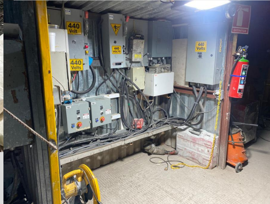
Foto 2. Inspección de gabinetes eléctricos.
