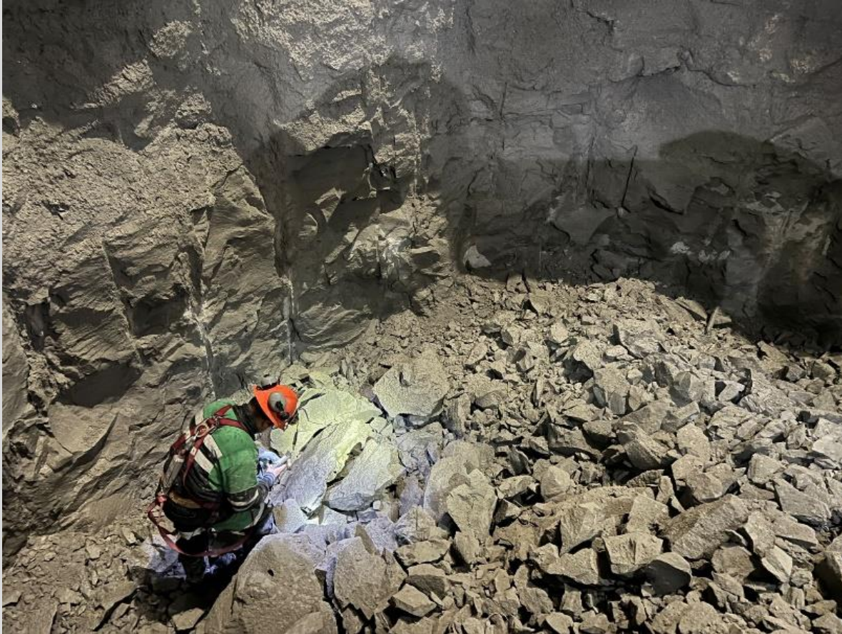
Foto 4. Material producto de la voladura.
