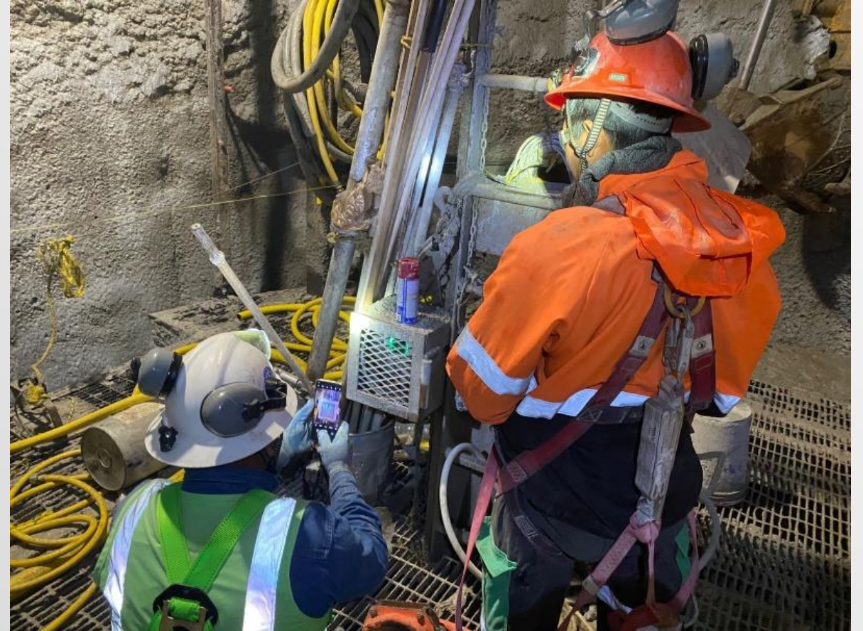
Foto 5. Monitoreo de gases durante los trabajos en interior de la lumbrera.
