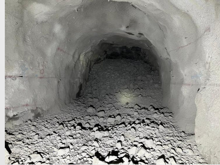
Foto 6. Material producto de la voladura.
