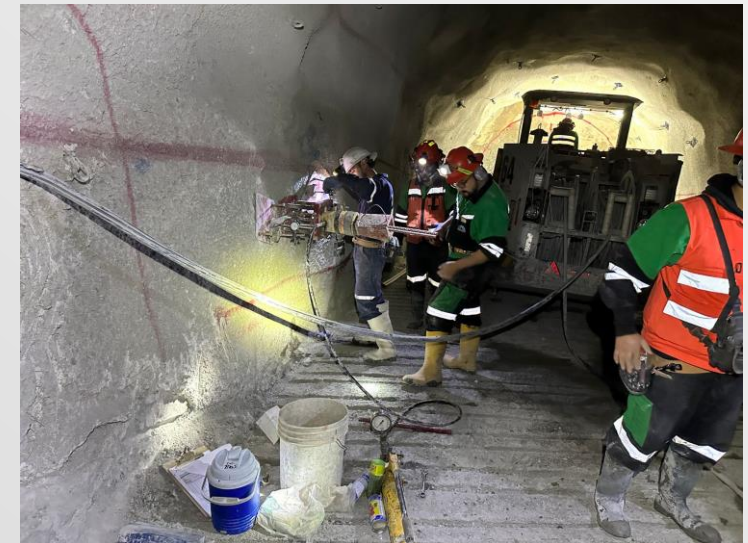
Foto 7. Pruebas de resistencia de anclas.
