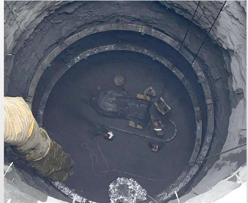
Figura 5: Trabajos de concreto lanzado en la lumbrera PCT-1.
