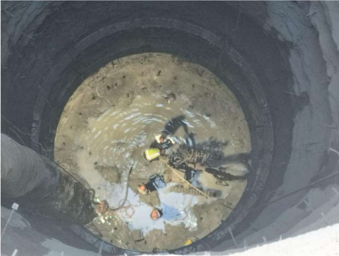
Figura 6: Actividad de barrenación de plantilla para voladura en la lumbrera PCT-1.
