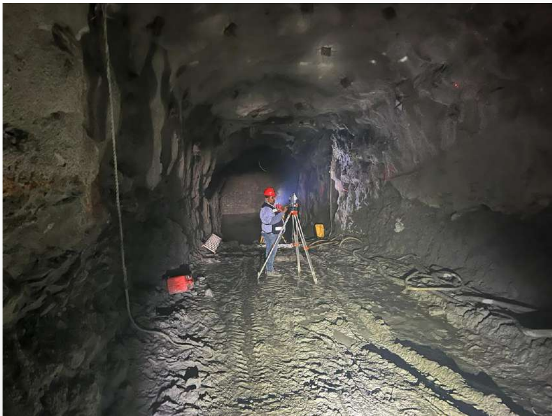
Figura 9: Levantamiento topográfico en el túnel de ventilación.
