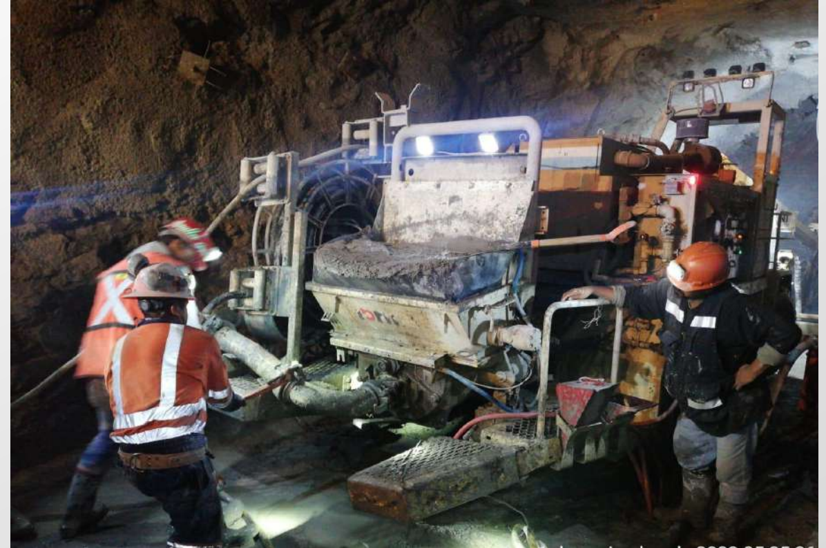
Figura 8: Trabajos de concreto lanzado en el túnel de ventilación.
