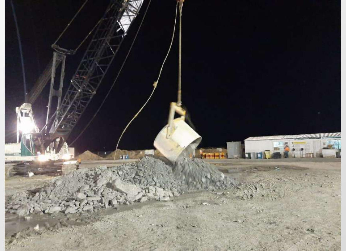
Figura 3: Rezagado del material producto de voladura en la lumbrera PCT-1
