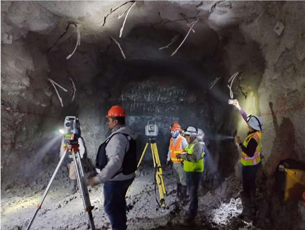
Figura 1: Levantamiento topográfico en túnel de acceso.
