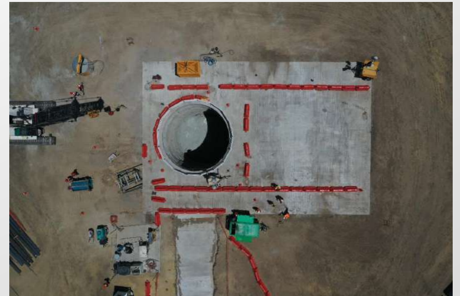
Figura 1: Vista aérea de la lumbrera PCT-1.
