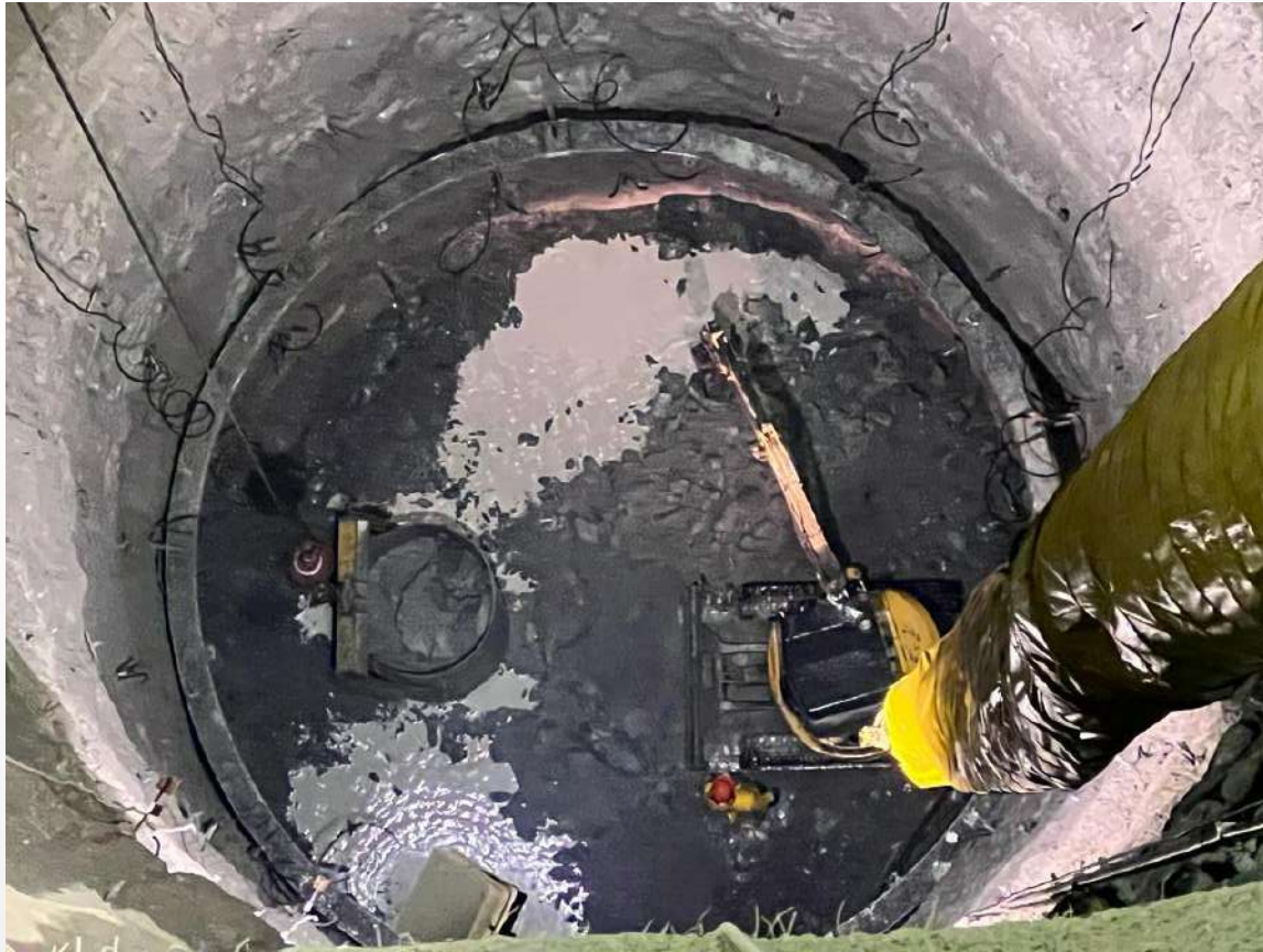
Figura 11: Rezaga de material producto de la voladura en la lumbrera PCT-2.
