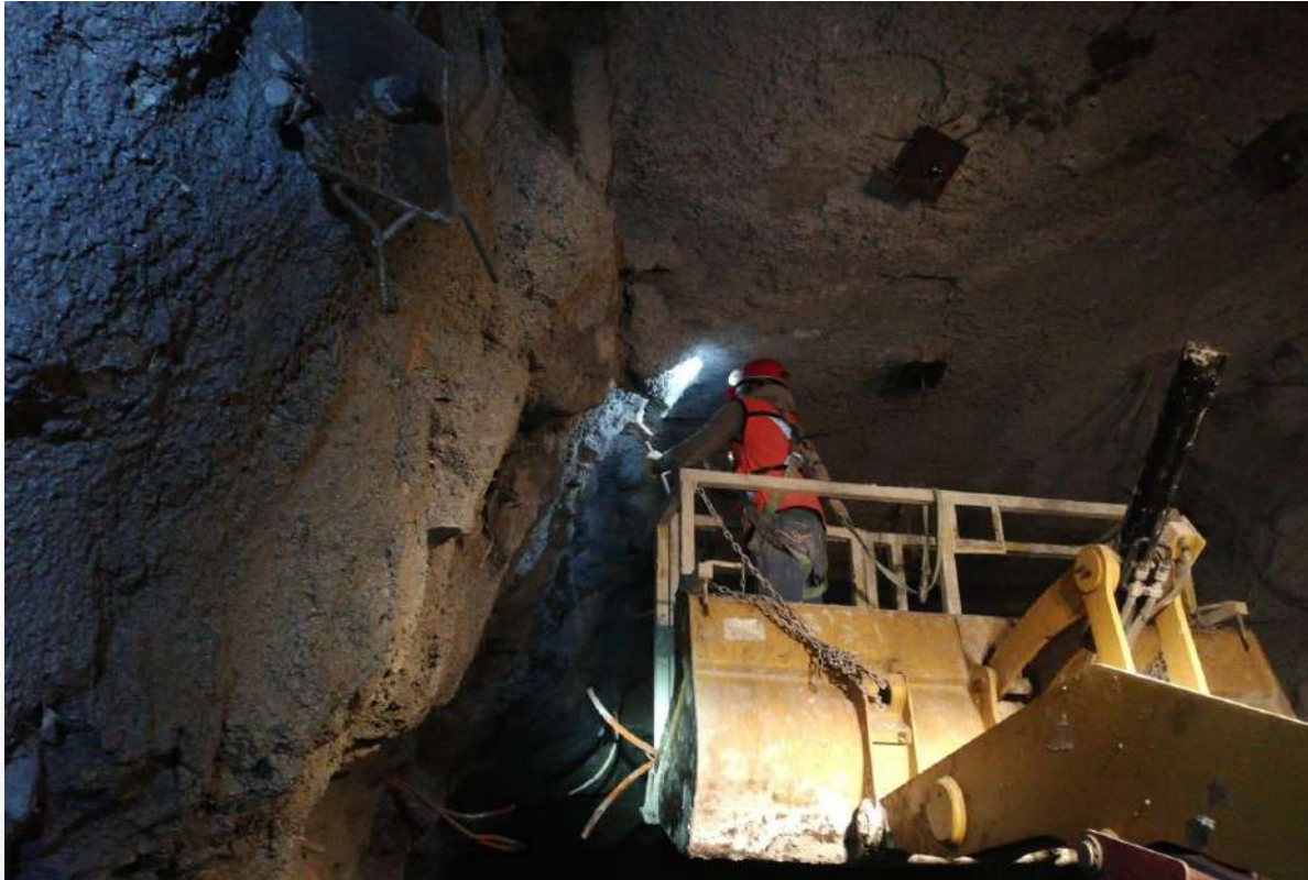
Figura 7: Colocación de placas a las anclas en el túnel de ventilación.
