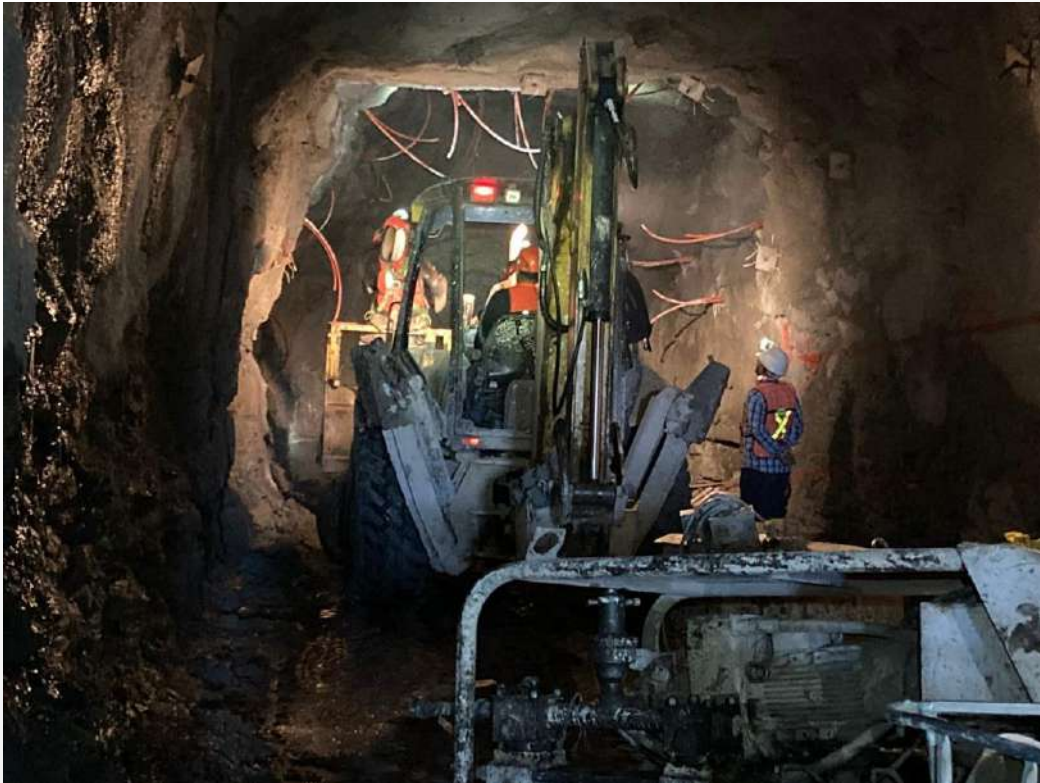
Figura 5: Inyección de anclas en el túnel de ventilación.
