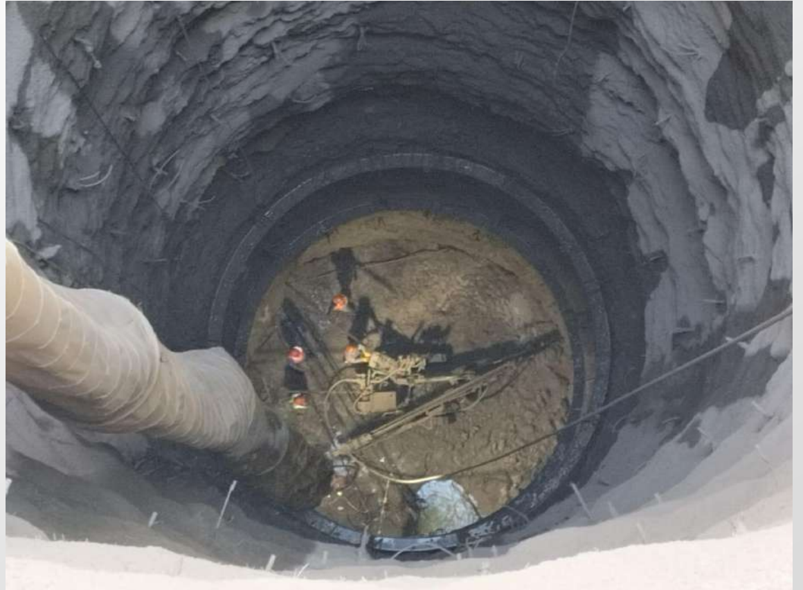
Figura 7: Colocación de anclas para anillo en la lumbrera PCT-1.
