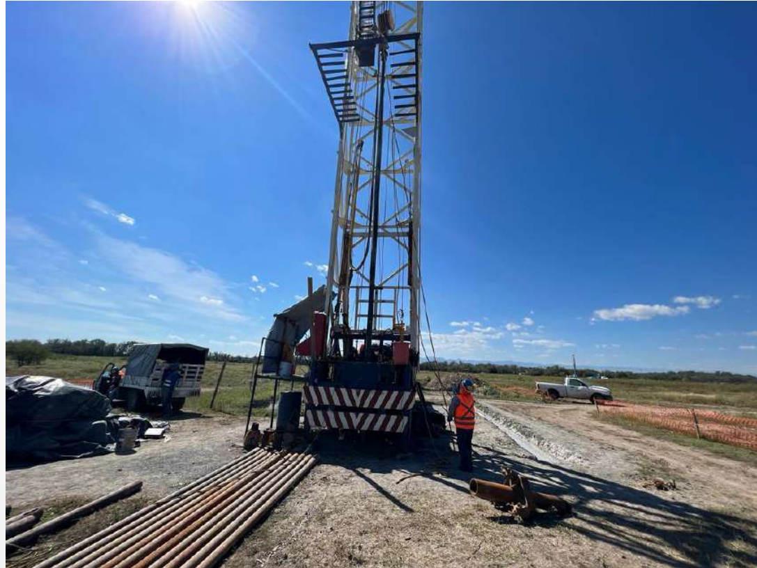
Figura 1: Trabajos de perforación del pozo PCE-04 . Se tienen 138 m de perforación con diámetro 12 ¼" y se comienza la ampliación con diámetro de 19" llegando a la profundidad de 75,50 m.
