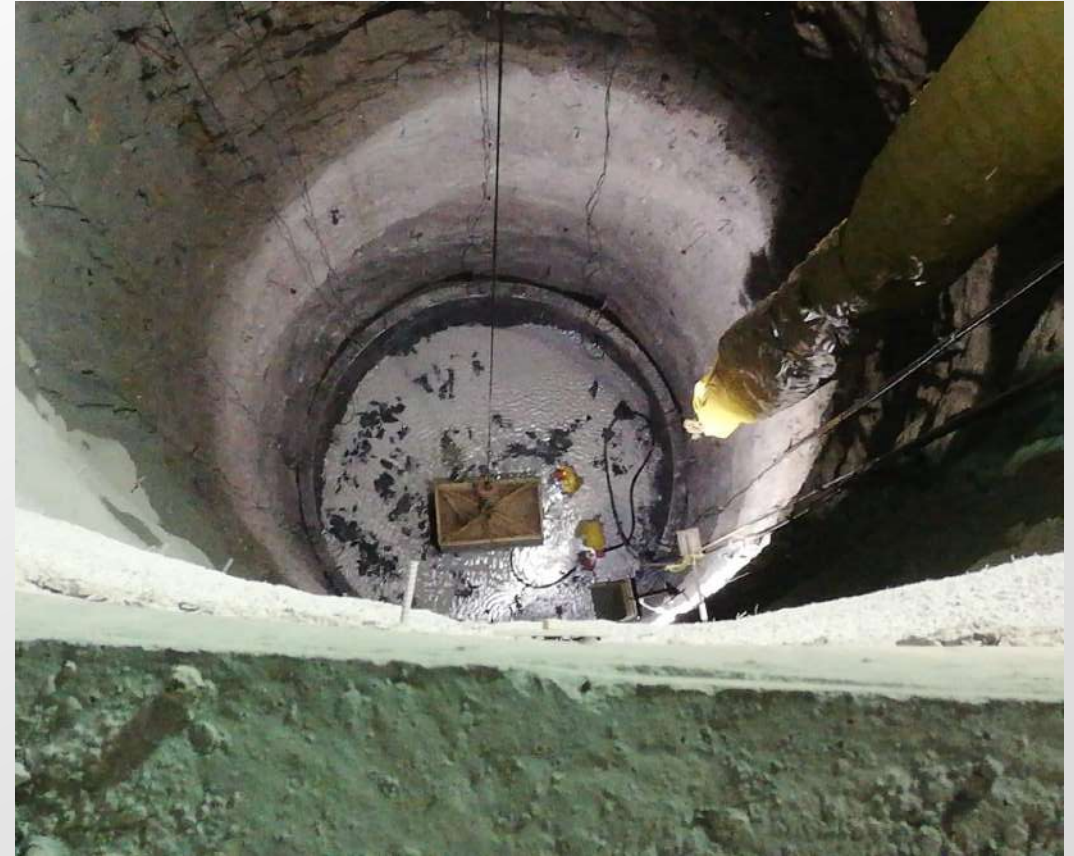
Figura 14: Trabajos de extracción de agua en la lumbrera PCT-2.
