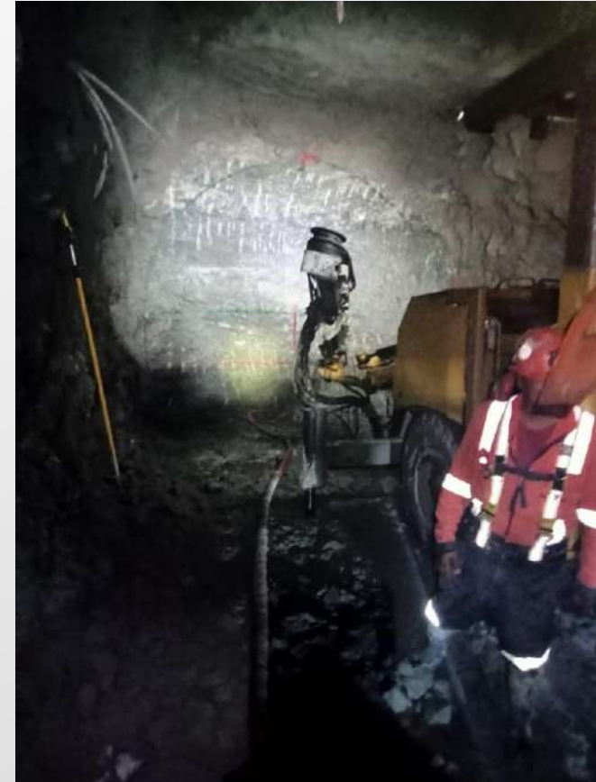
Figura 2: Barrenación de plantilla para voladura en el túnel de acceso.
