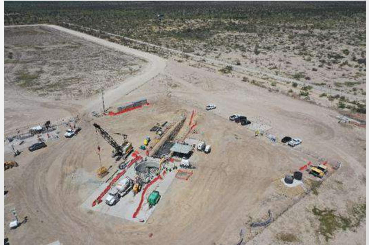
Figura 10: Vista aérea de la lumbrera PCT-2.
