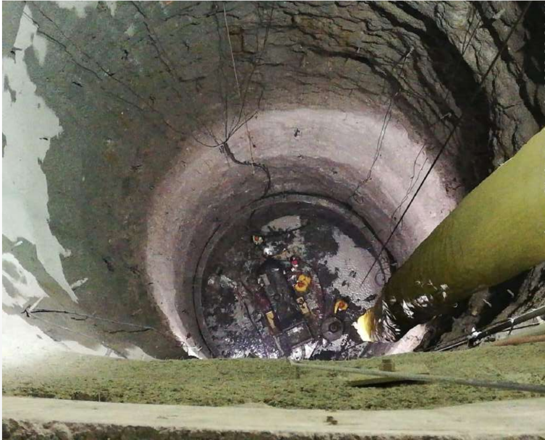
Figura 13: Trabajos de concreto lanzado en la lumbrera PCT-2.
