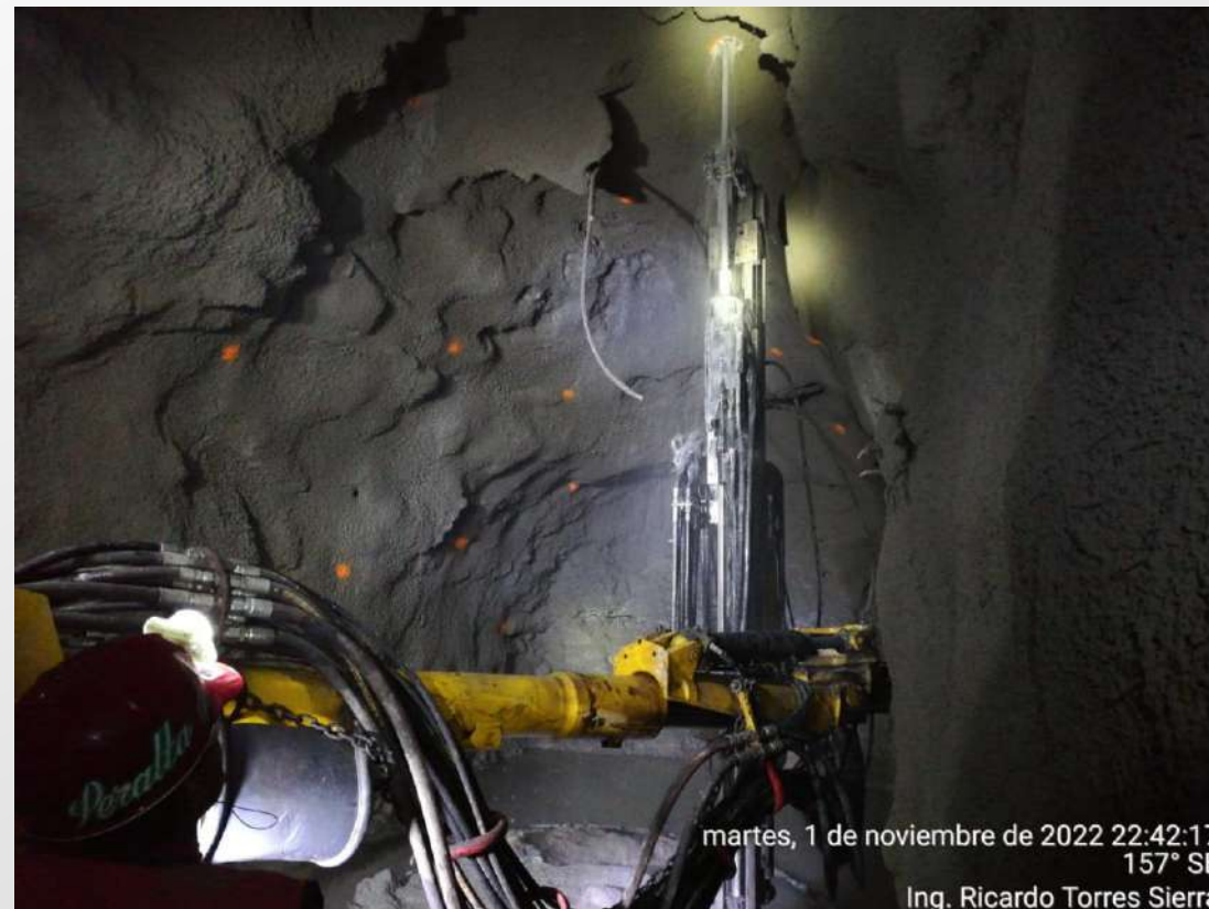
Figura 10: Barrenación para línea de anclaje en el túnel de ventilación.
