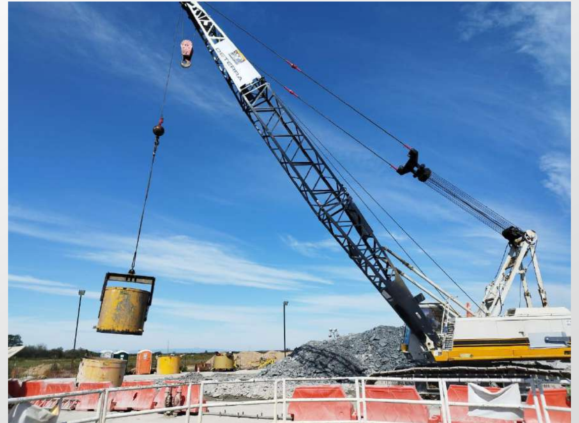
Figura 12: Rezaga de material producto de la voladura en la lumbrera PCT-2.
