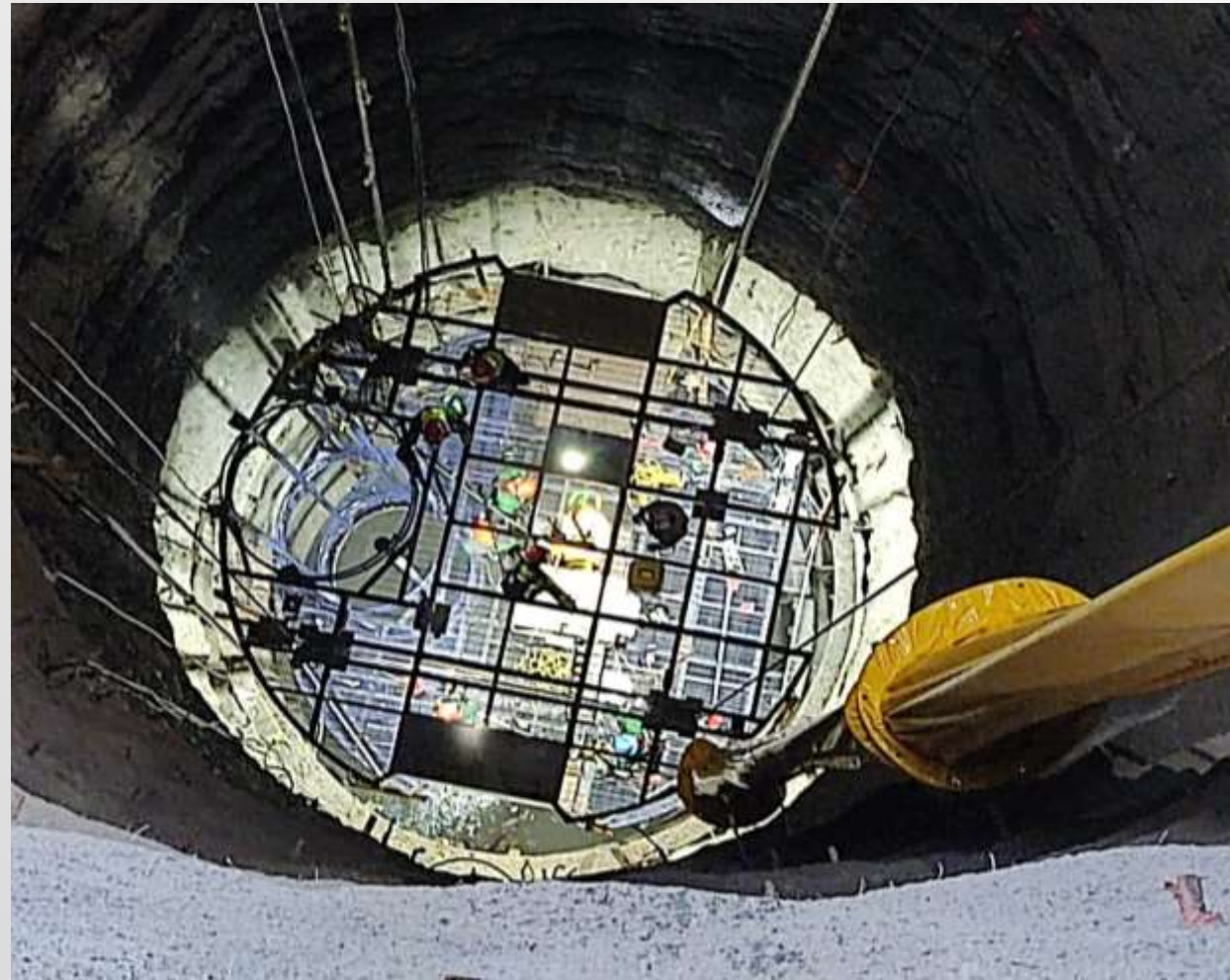
Imagen 4. Levantamiento Topográfico al Interior de Lumbrera PCT-1.
