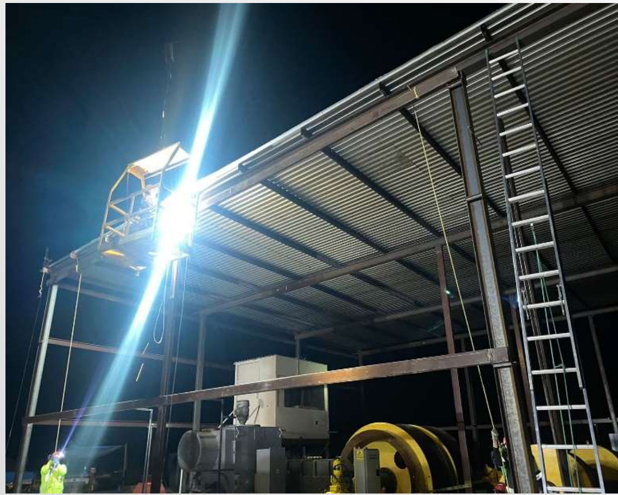
Imagen 6. Actividades para el armado de la sala de malacates y winches.
