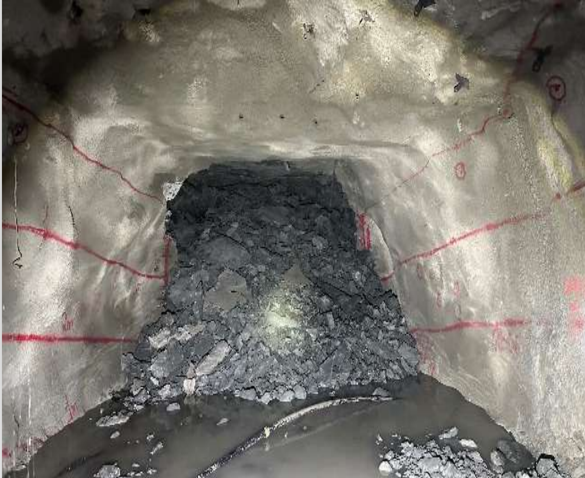
Imagen 8. Material producto de voladura en Túnel de Acceso.
