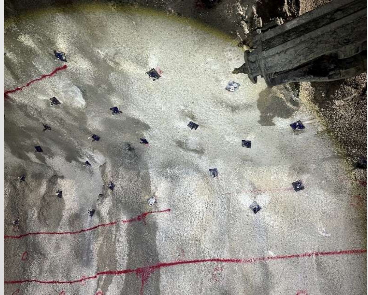
Imagen 9. Actividades de anclaje en Túnel de Acceso.
