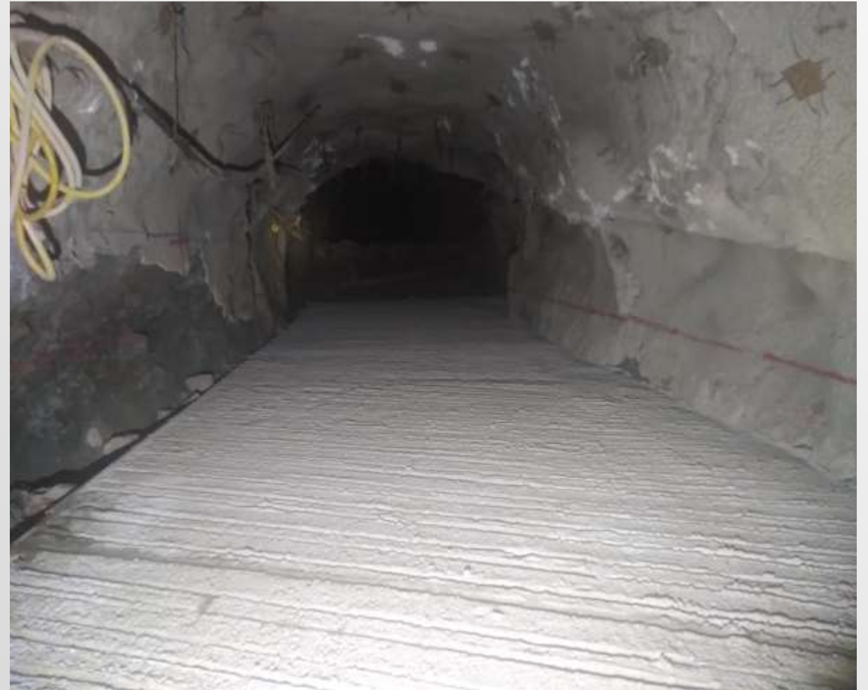
Imagen 11. Colado de concreto en Túnel de Ventilación.
