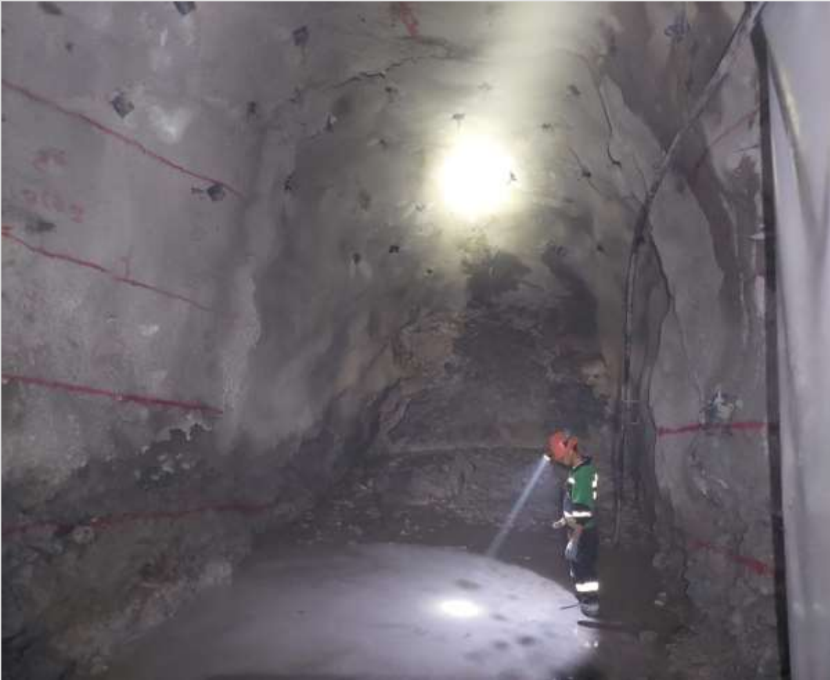
Imagen 10. Revisión de condiciones del piso en Túnel de Ventilación.
