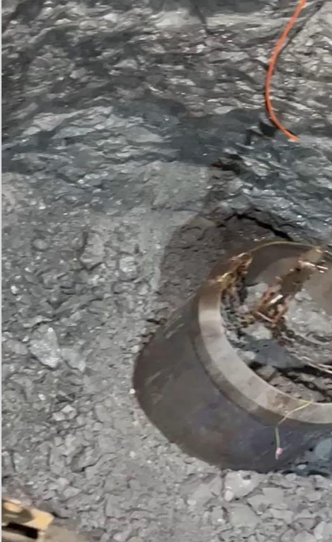
Video 1. Extracción de material producto de la voladura en Lumbrera PCT-1.
