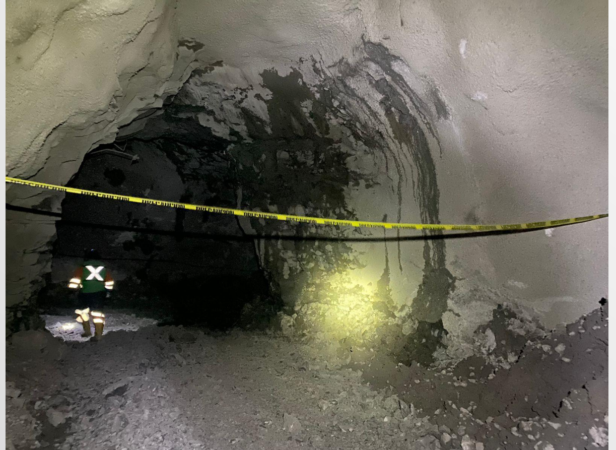
Foto 9. Excavación del segundo crucero por Túnel de Ventilación.
