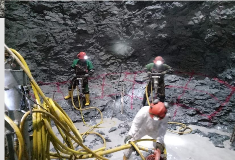
Foto 2. Barrenación para plantilla de voladura en Lumbrera PCT-1.
