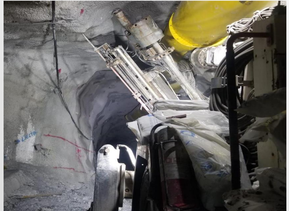
Foto 7. Colocación de anclas en Túnel de Acceso.
