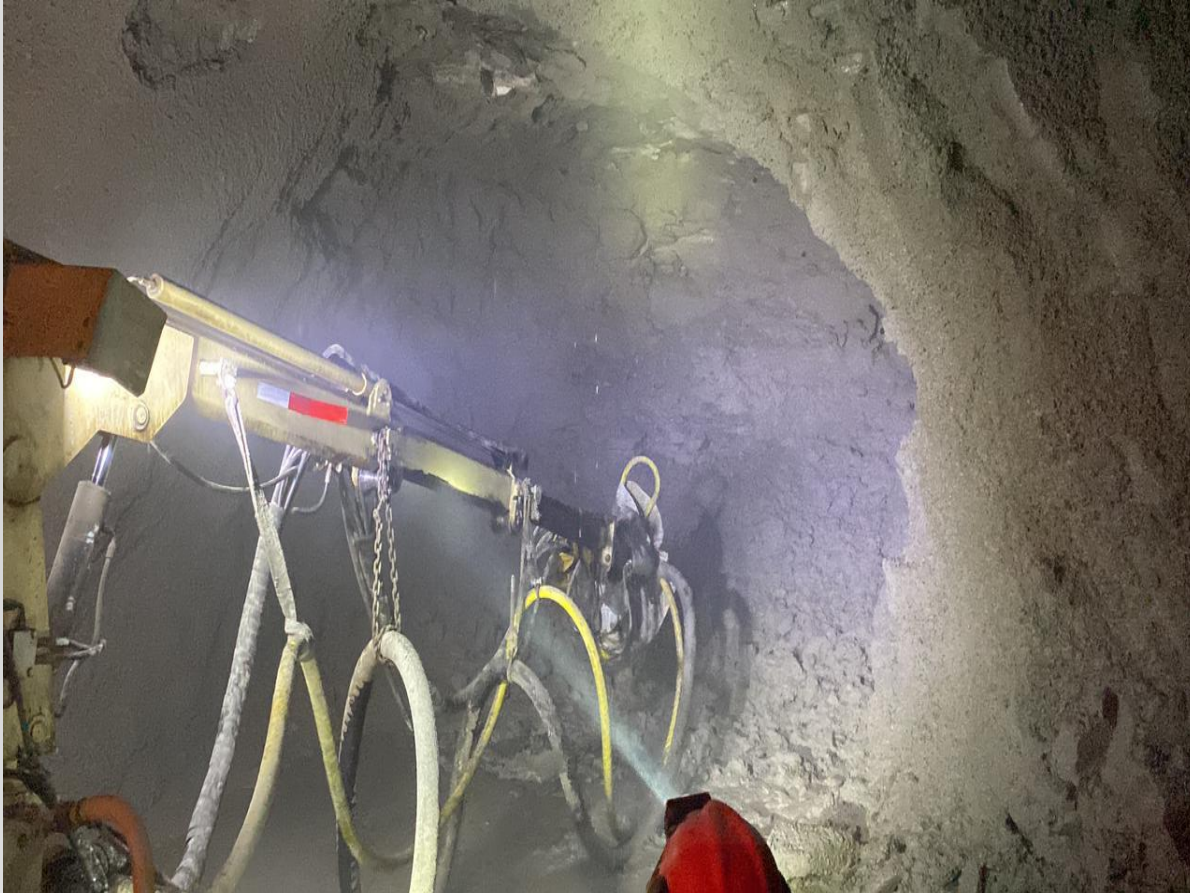
Foto 8. Trabajos de lanzamiento de concreto en Túnel de Ventilación.
