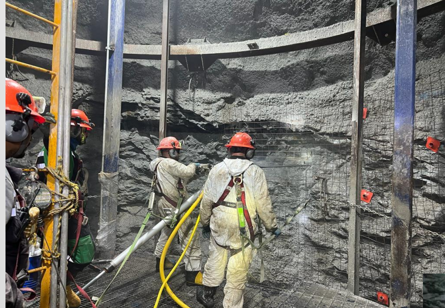
Foto 1. Colocación de malla en Lumbrera PCT-1.
