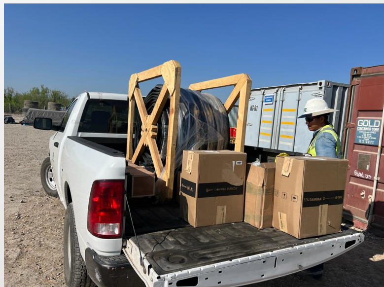
Imagen 12. Llegada de equipo de bombeo para extracción de agua de las lumberas
