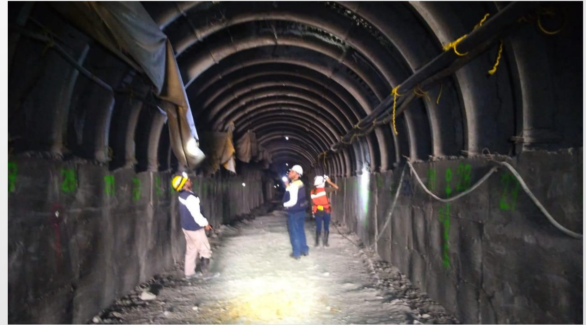
Imagen 6 y 7. Monitoreo de la estabilidad e integridad de los túneles por parte del área de Topografía, Geología e instrumentación.
