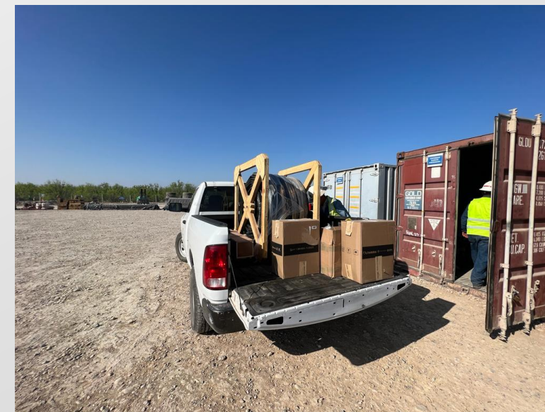
Imagen 13. Llegada de equipo de bombeo para extracción de agua de las lumberas
