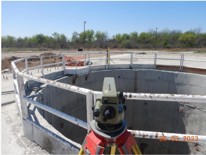
Imagen 1, 2 y 3. Monitoreo de la estabilidad e integridad de las lumbreras por parte del área de Topografía e Instrumentación.
