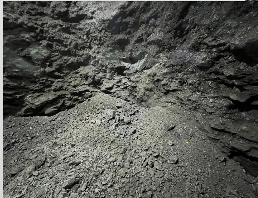
Foto 3. Material producto de la voladura.
