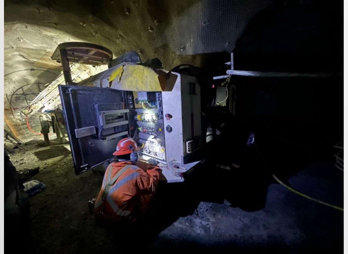
Foto 6. Colocación de anclas.
