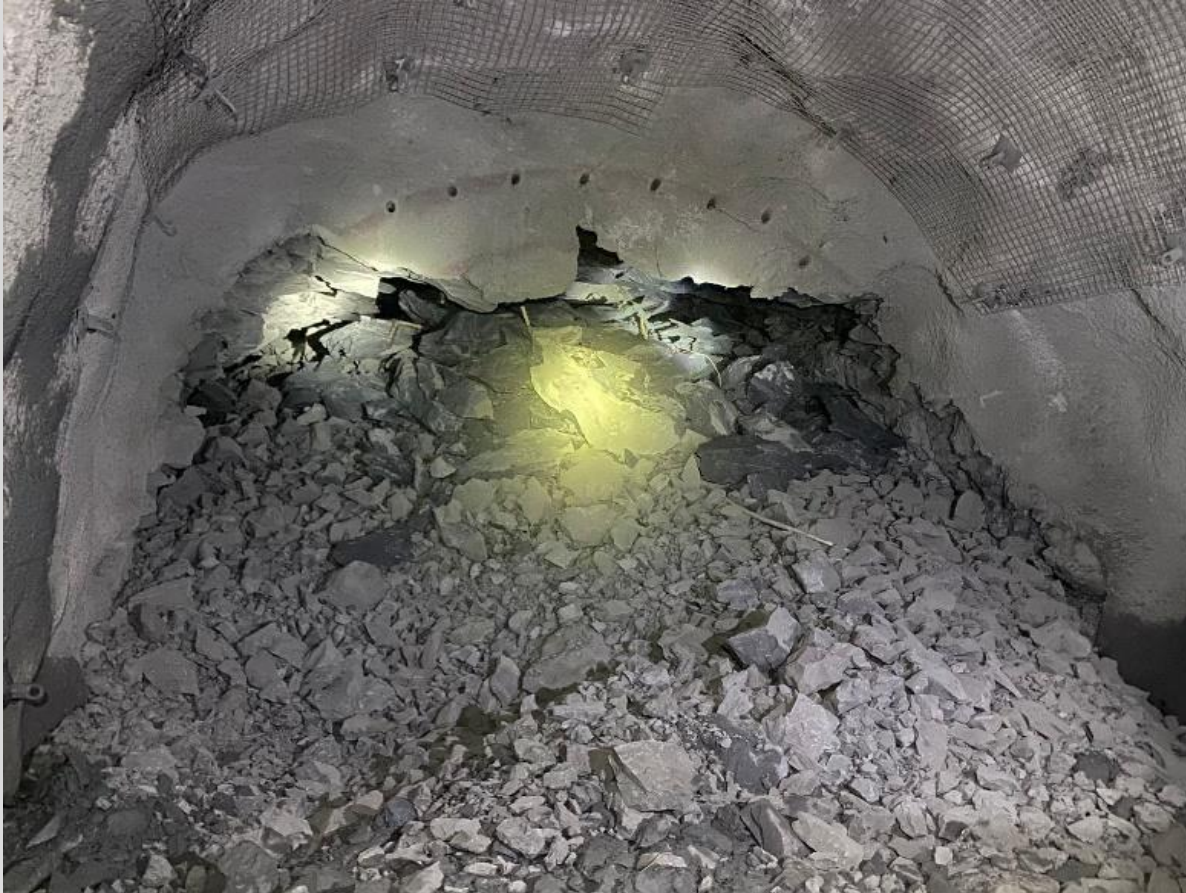
Foto 5. Material producto de la voladura.
