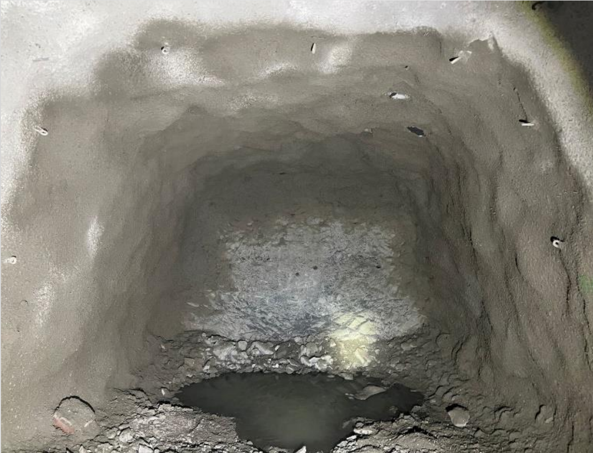
Foto 7. Colocación de concreto lanzado.
