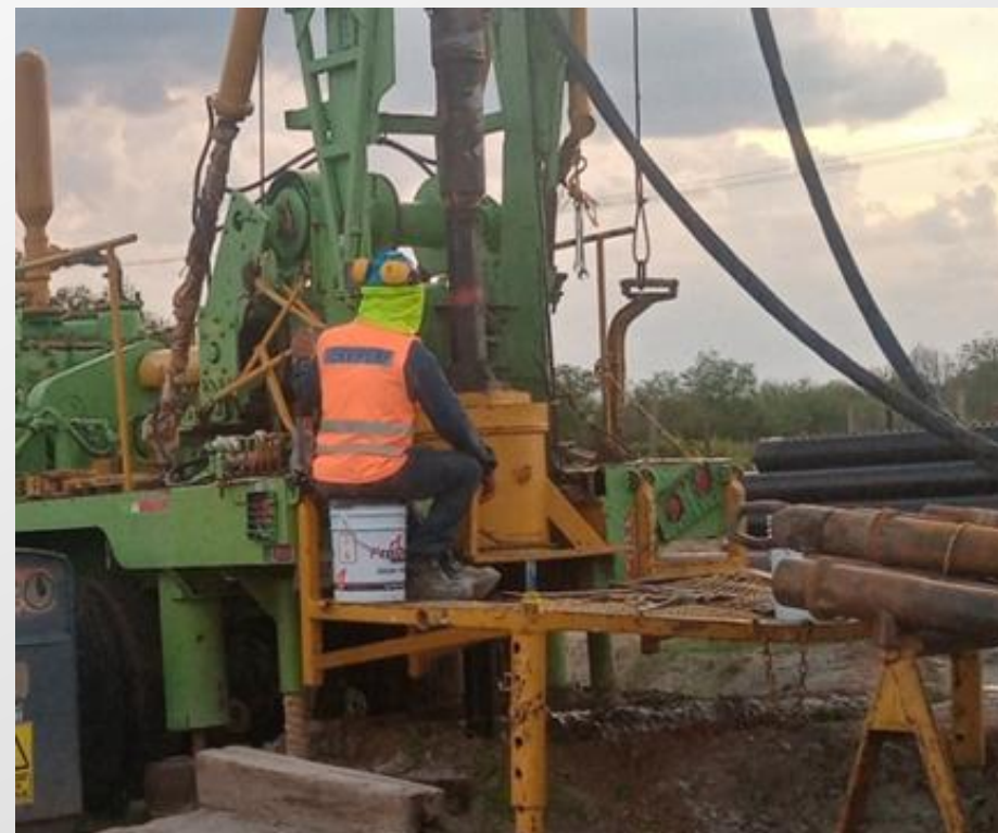
Figura 2: Trabajos de perforación del pozo PCV-3 A. Se tiene un avance de 48 m de perforación.
