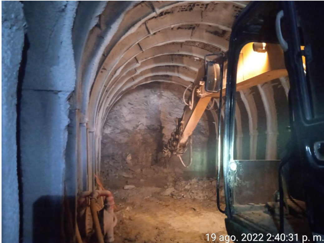
Figura 3: Excavación por medios mecánicos en túnel de acceso.
