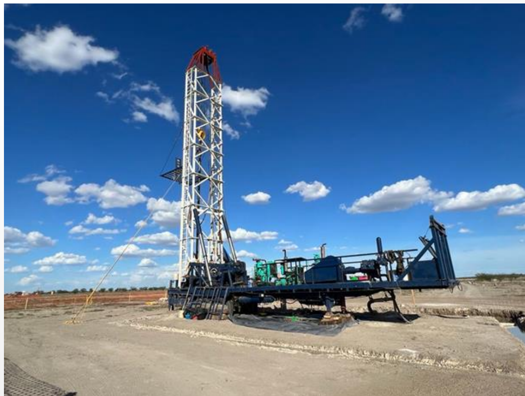
Figura 1: Trabajos de perforación del pozo PCE-04. Se tienen 65 m de perforación
