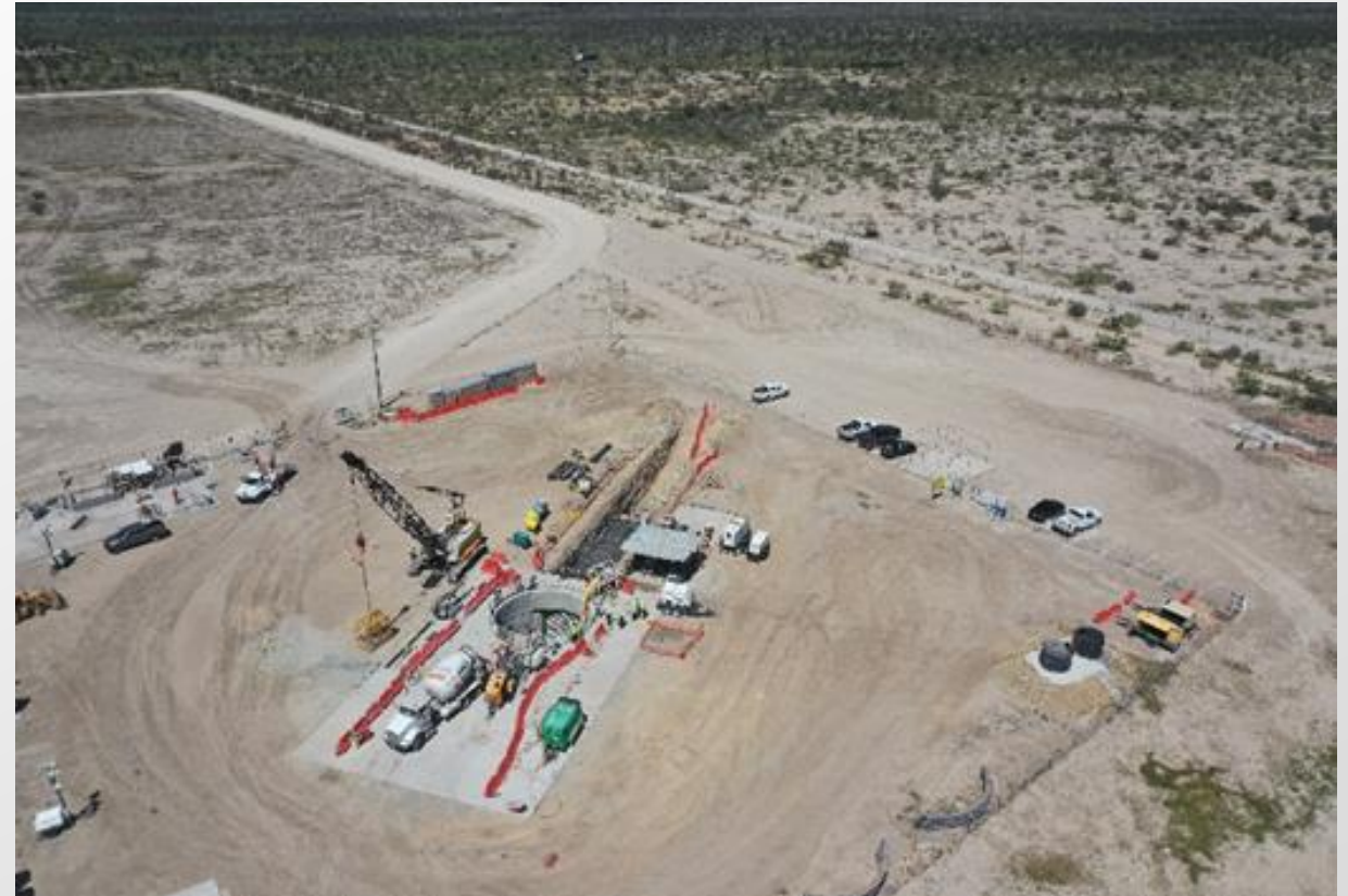
Figura 4: Vista aérea de la lumbrera PCT-2.
