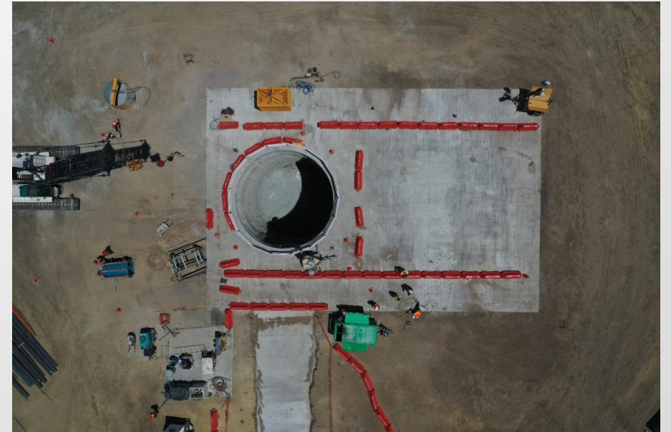
Figura 1: Vista aérea de la lumbrera PCT-1.
