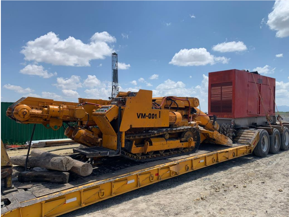
Figura 1: Llegada de Roadheader para la excavación en los túneles.
