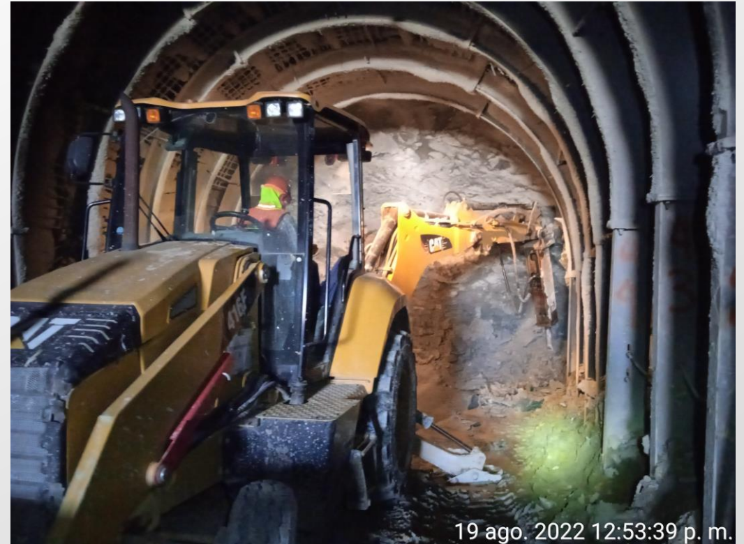
Figura 4: Excavación por medios mecánicos en túnel de acceso.
