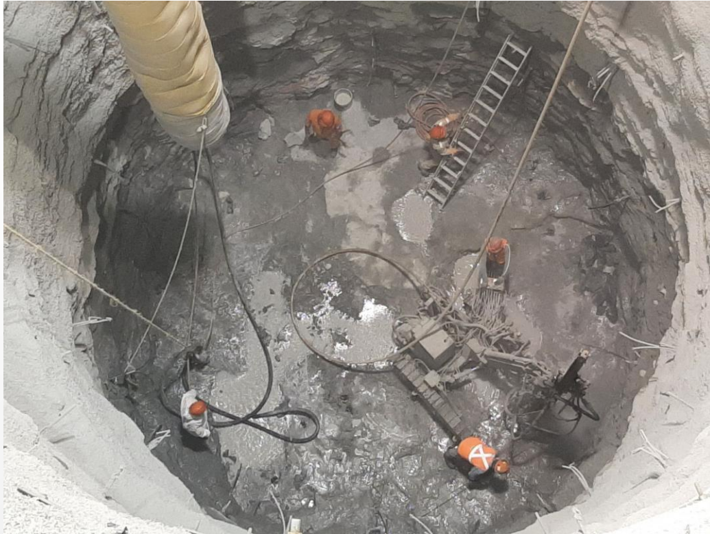
Figura 2: Trabajos perforación de barrenos para voladura
