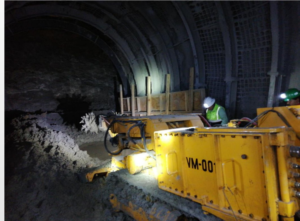
Figura 2: Roadheader posicionado en el túnel de ventilación
