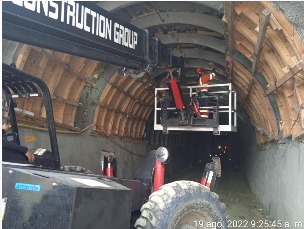
Figura 5: Habilitado de cimbra en túnel de ventilación.
