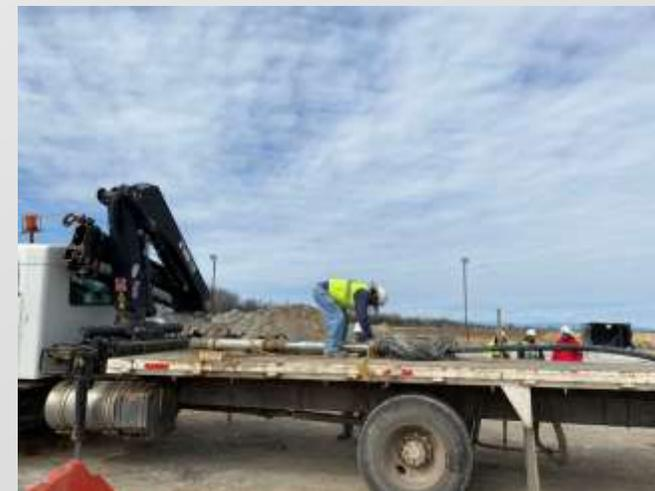
Fotografía 12. Retiro de bomba y transporte de bomba.
