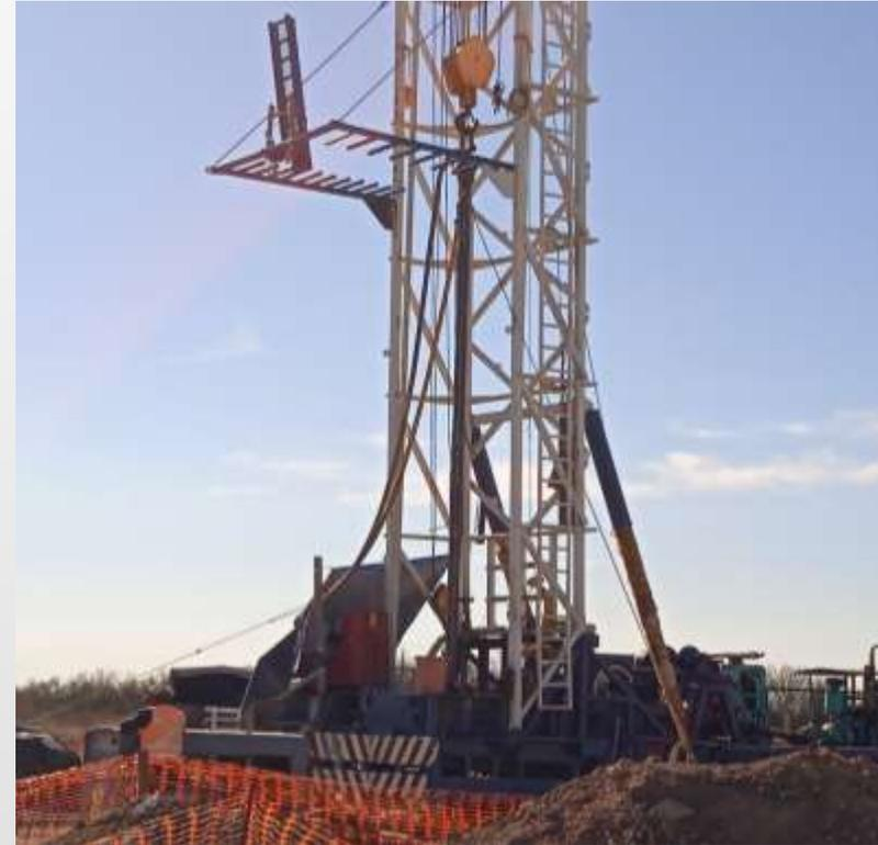
Imagen 12: Trabajos de perforación del pozo **PCE-04**. Se concluyó la perforación con un diámetro 12"  $\frac{1}{4}$  (158 m) y se llevan 138.00 m con diámetro de 19".
