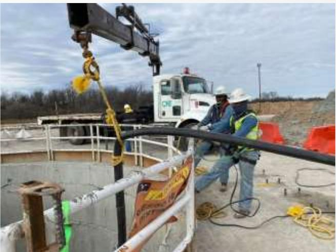
Fotografía 10. Retiro de línea de conducción y bomba.
