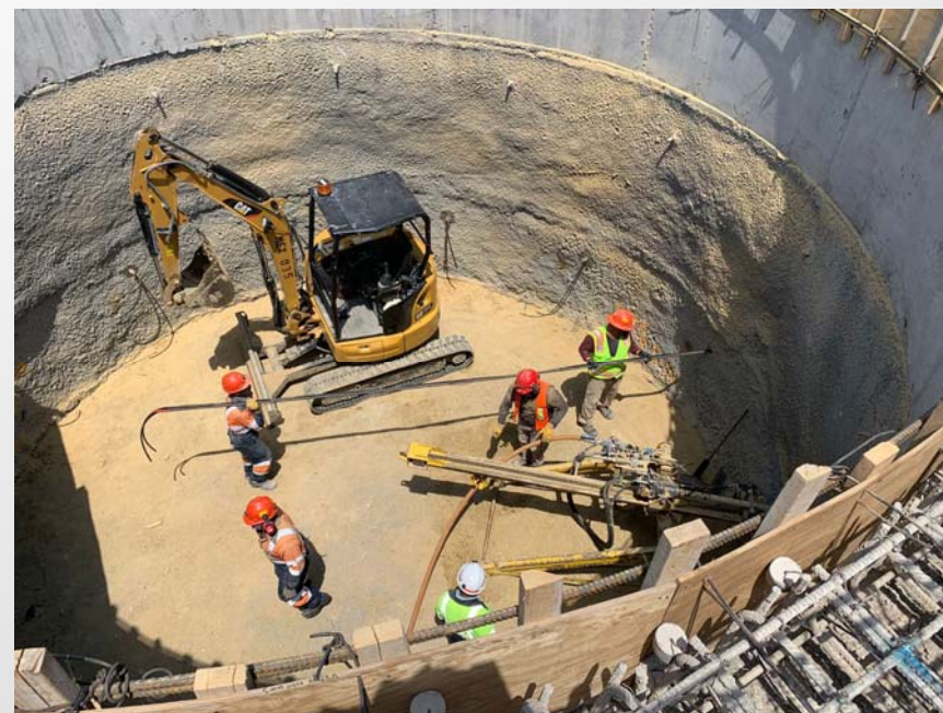
Figura 3: Colocación de anclas en el tiro vertical PCT-1.
