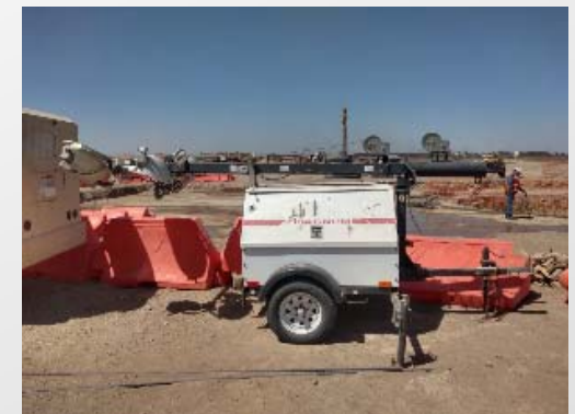
Figura 9: Reflector (trabajos nocturnos).
