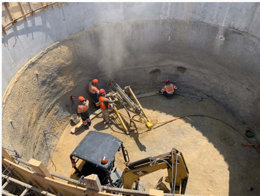
Figura 4: Perforación de la segunda línea de anclas en la lumbrera PCT-1
