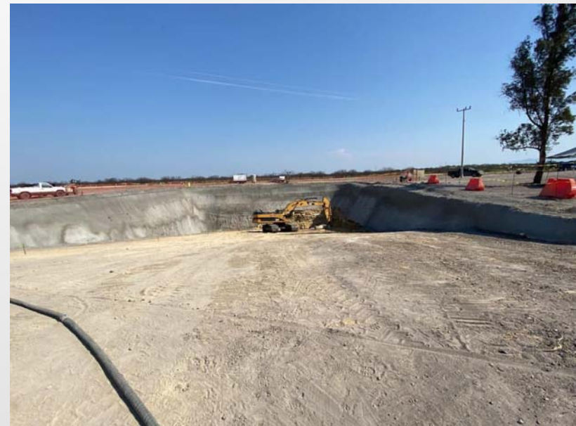
Figura 2: : En el portal de entrada se ha ejecutado el tercer y cuarto banqueo, con estas excavaciones, se ha llegado al nivel de piso de excavación del túnel de acceso y túnel de ventilación.
