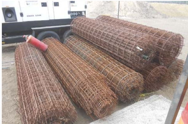
Figura 13: Malla electrosoldada (concreto lanzado)
