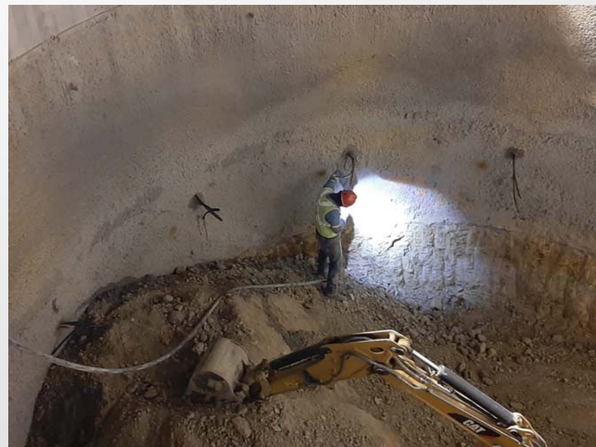
Figura 5: Inyección de la segunda línea de anclaje en la lumbrera PCT-1
