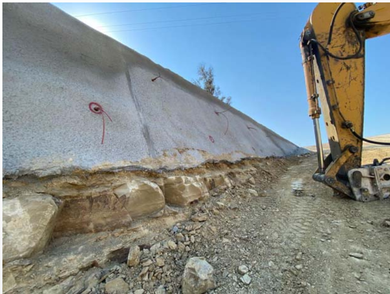
Figura 1: Perfilamiento y afine de los taludes correspondientes al tercer y cuarto banqueo del Portal de Entrada.
