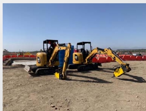
Figura 11: Mini excavadoras (Perforación).
