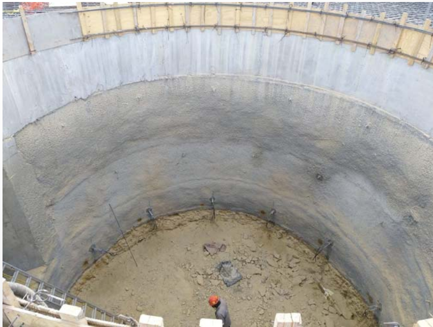
Figura 8: Perforación de la tercer línea de anclaje en la lumbrera PCT-1.
