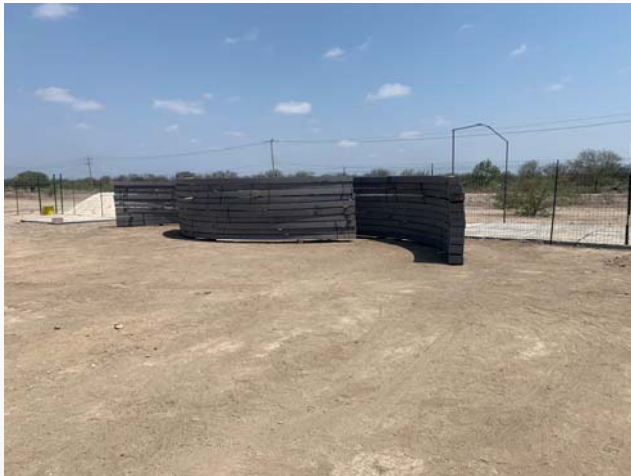
Figura 17: Anillos metálicos para la lumbrera PCT-1
