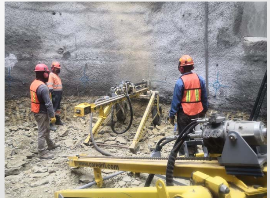
Figura 9: Perforación de la tercer línea de anclaje en la lumbrera PCT-1
