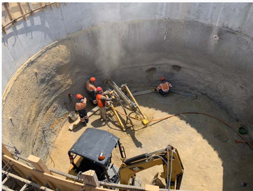
Figura 2: Perforación de la segunda línea de anclas en la lumbreira PCT-1.
