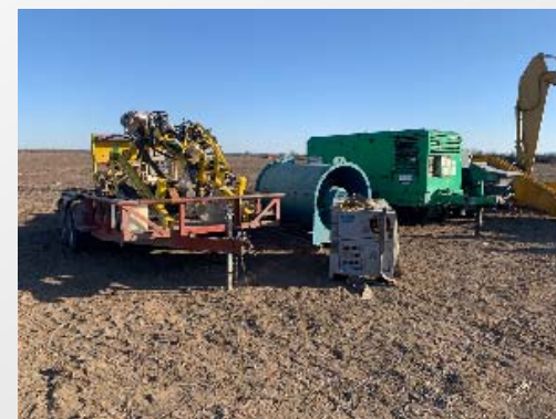
Figura 3: Equipo de perforación Corel Drill
