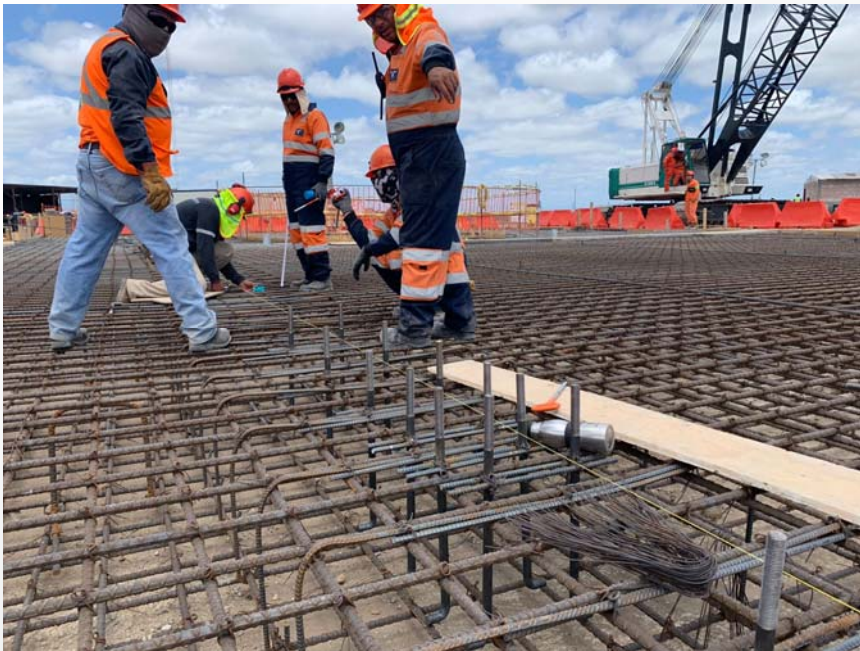
Figura 10: Colocación de las bastones que forman parte de los rieles de la grúa pórtico en la lumbrera PCT-1.
