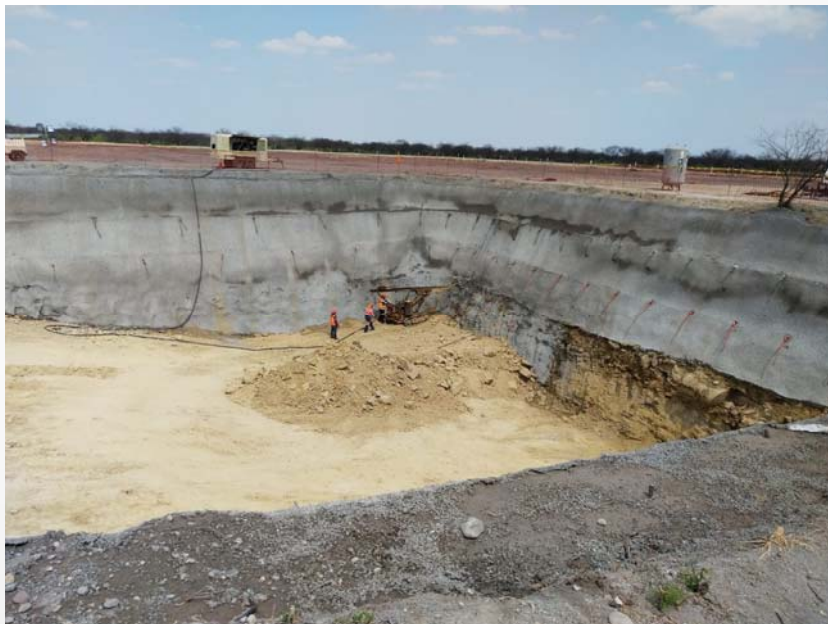
Figura 3: Proceso de perforación de la tercer línea de anclaje del Portal de Entrada.
