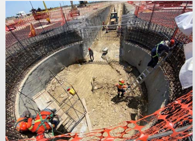
Figura 13: Lumbreira PCT-2 donde se realizaron pruebas del agente expansivo.
