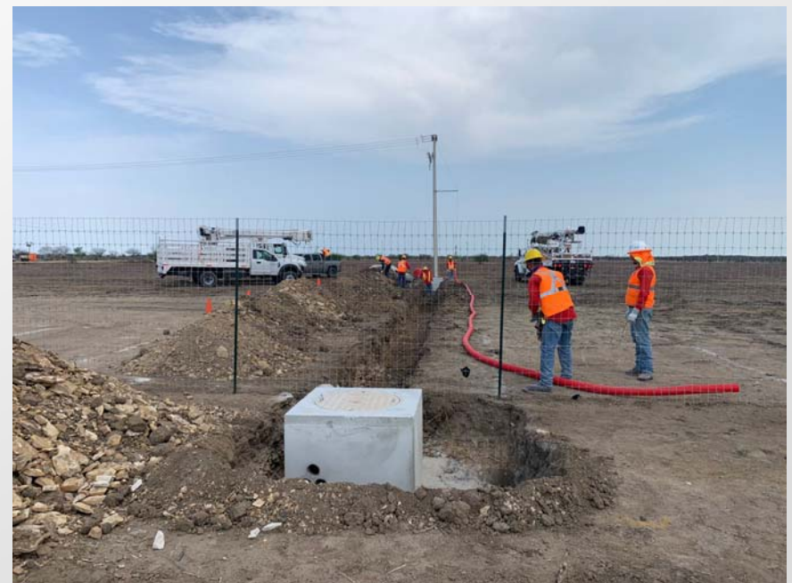
Figura 7: Construcción de la línea de media tensión en la lumbrera PCT-1.
