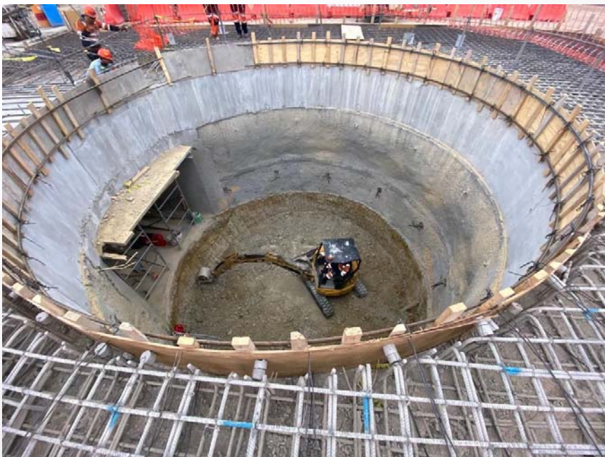
Figura 6: Perfilado y afinado de las paredes en la lumbrera PCT-1.
