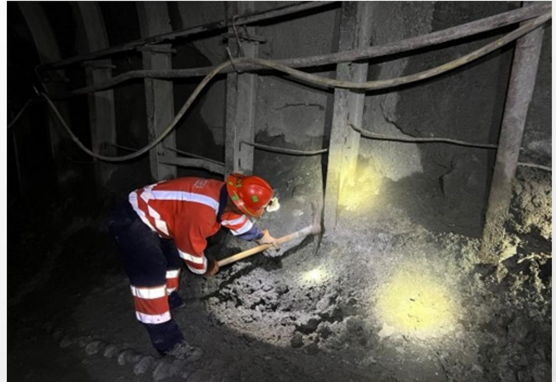
Figura 2: Trabajos de limpieza para colocación de cimbra en el túnel de acceso.
