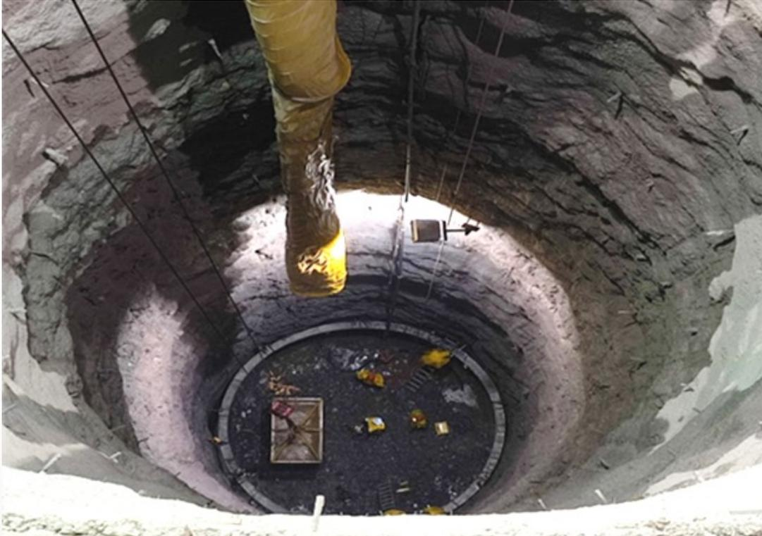
Figura 12: Trabajos de colocación y alineación de anillo en la lumbrera PCT-2.
