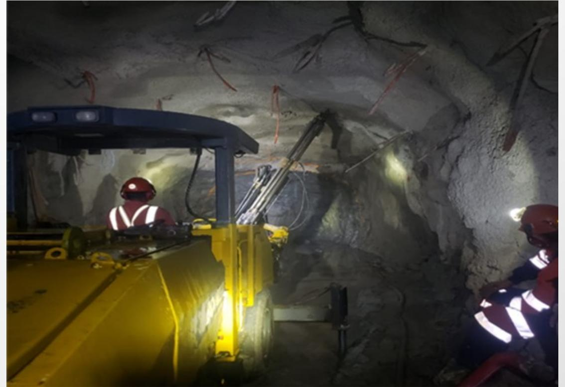
Figura 8: Trabajos de barrenación para anclaje en el túnel de ventilación.
