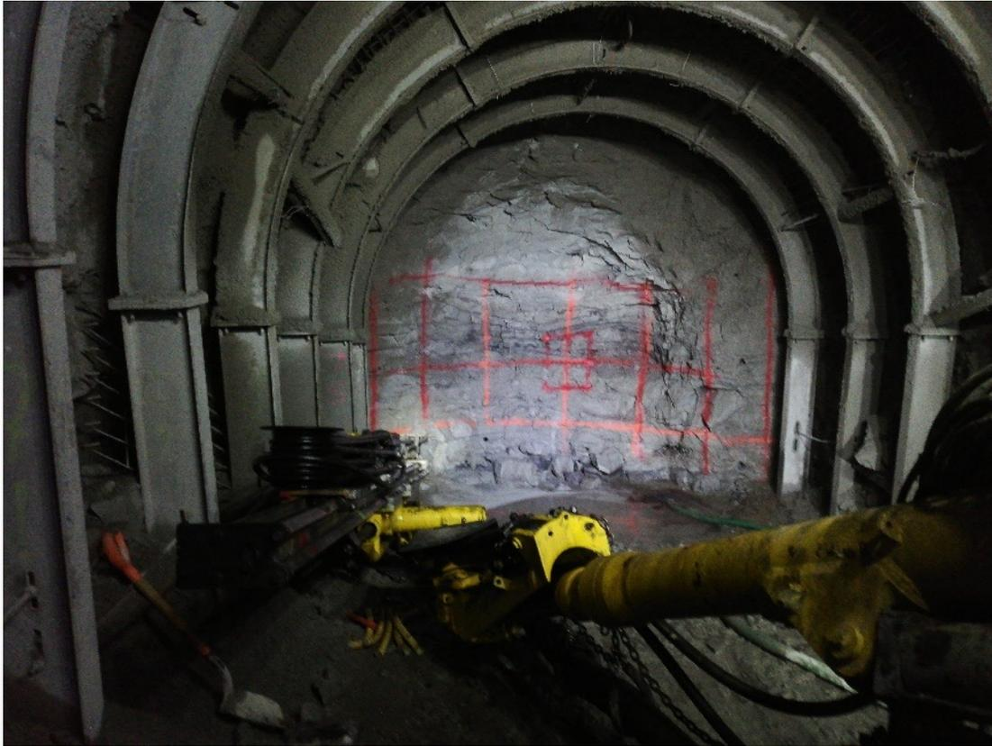
Figura 3: Marcado de plantilla para barrenos de voladura en túnel de acceso.
