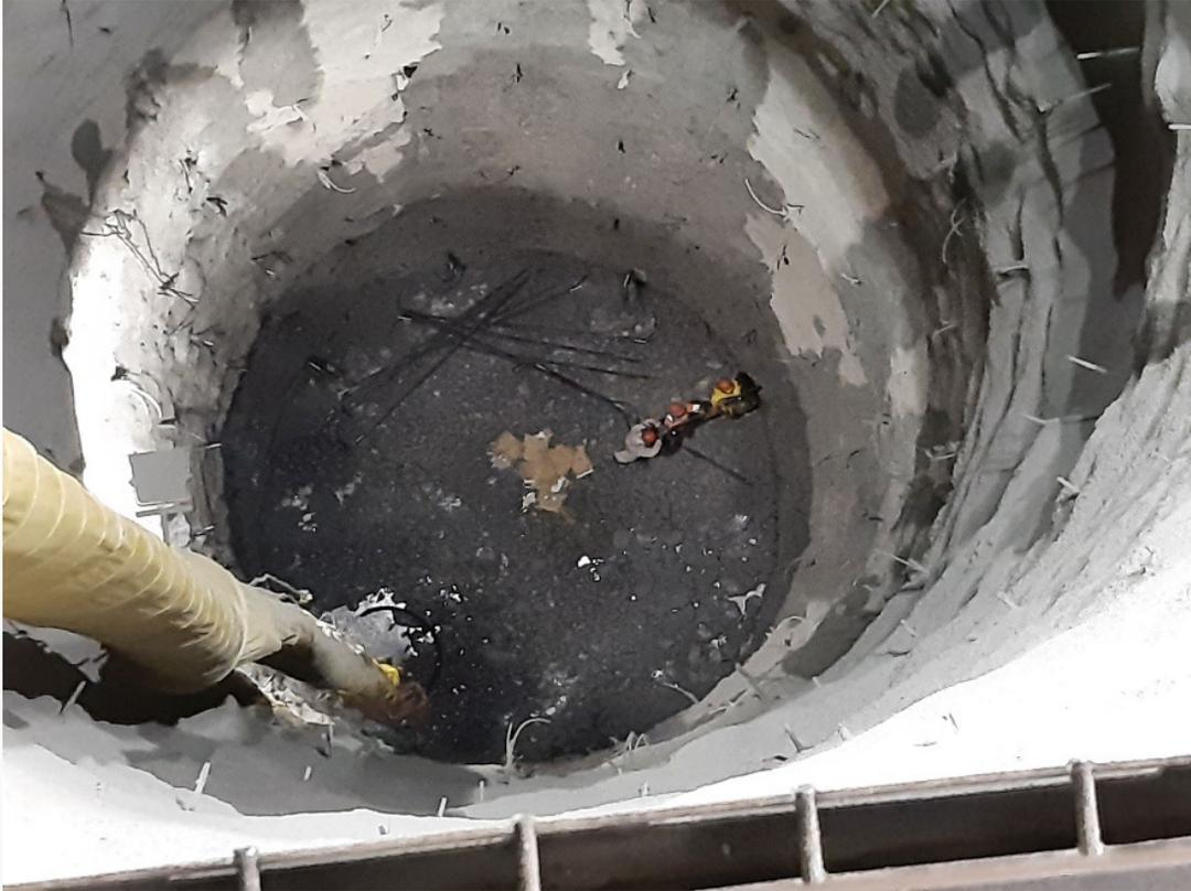
Figura 4: Barrenación de anclas para la colocación de anillo en la lumbrera PCT-1.
