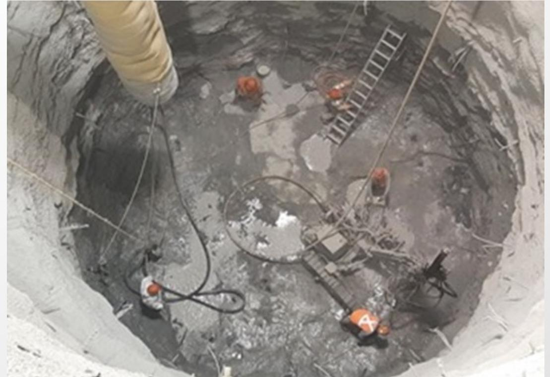
Figura 13: Barrenación de plantilla para voladura en la lumbrera PCT-2.
