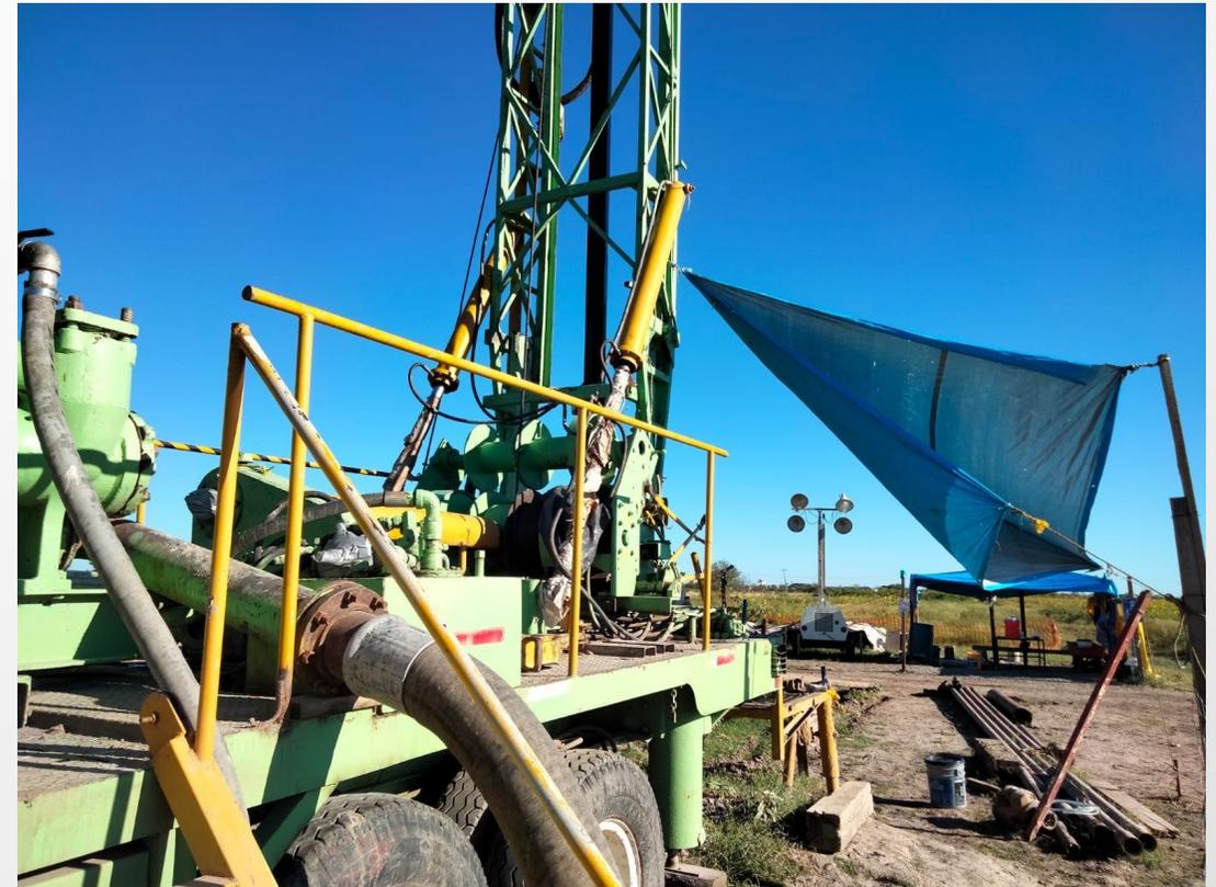
Figura 2: Trabajos de perforación del pozo **PCV-3 A**. Se reanuda los trabajos de ampliación del pozo de extracción, avanzando esta semana a **19"** de la profundidad de **148.00 a 160.00 metros**
