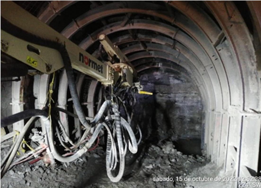
Figura 7: Trabajos de concreto lanzado en el túnel de ventilación.
