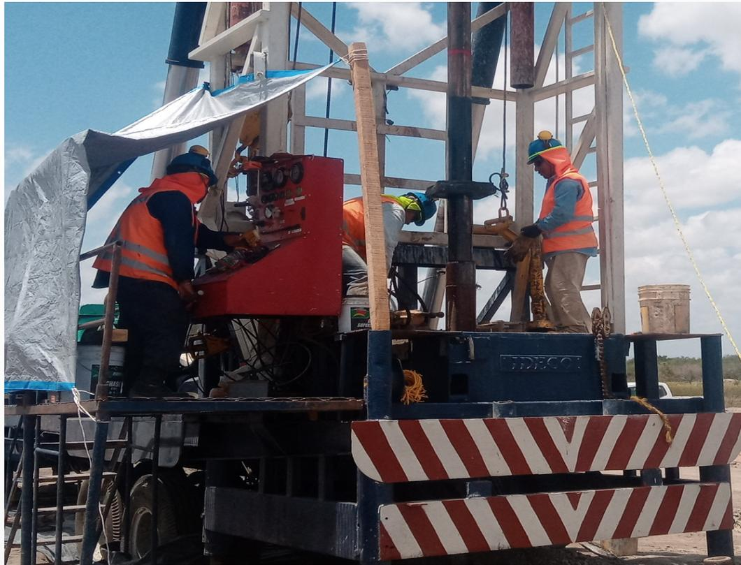
Figura 1: Trabajos de perforación del pozo **PCE-04**. Se tienen **138 m** de perforación con diámetro **12 ¼"** y se comienza la ampliación con diámetro de **19"** llegando a la profundidad de **43.00 m**.
