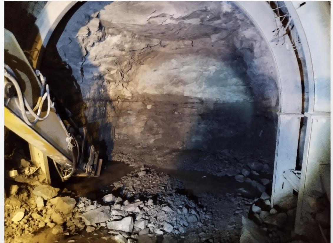
Figura 6: Perfilado de las paredes en el túnel de ventilación.
