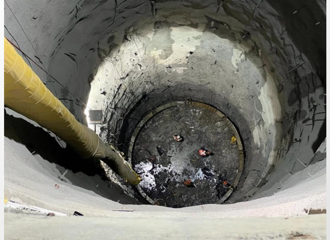
Figura 5: Colocación de anillo en la lumbrera PCT-1.
