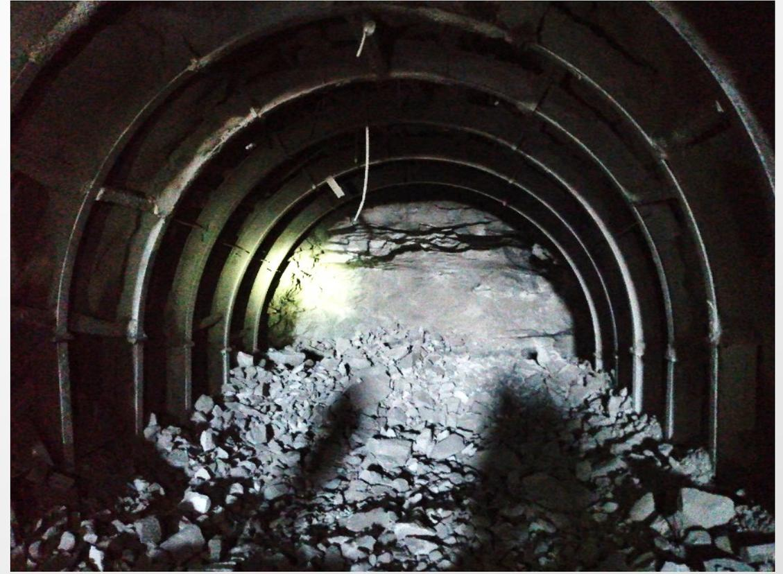
Figura 4: Material producto de la voladura en el túnel de acceso.
