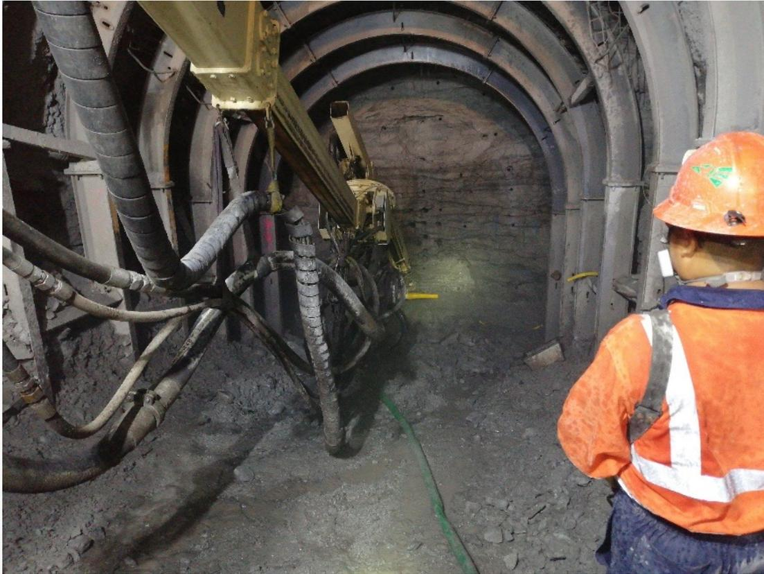
Figura 5: Perforación de barrenos para voladura en el túnel de ventilación.
