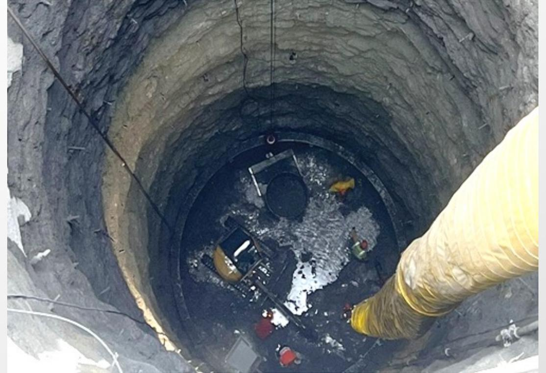
Figura 3: Rezagado del material con mini excavadora en la lumbrera PCT-1.
