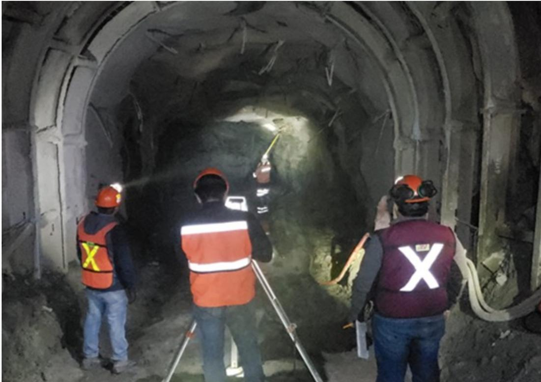
Figura 1: Levantamiento topográfico en túnel de acceso.
