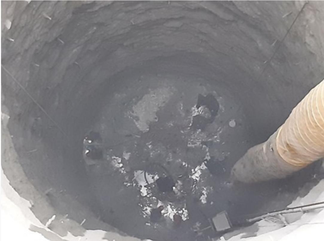
Figura 10: Barrenación de plantilla para voladura en la lumbrera PCT-2.
