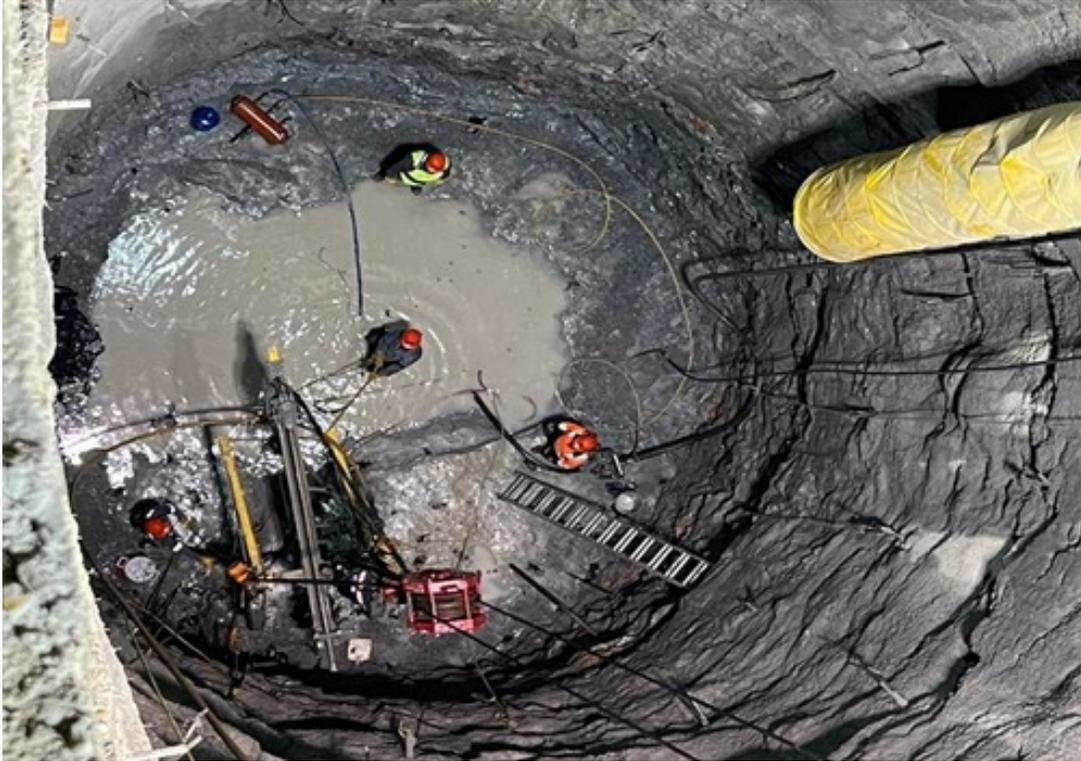
Figura 2: Barrenación para sistema de anclaje en la lumbrera PCT-1
