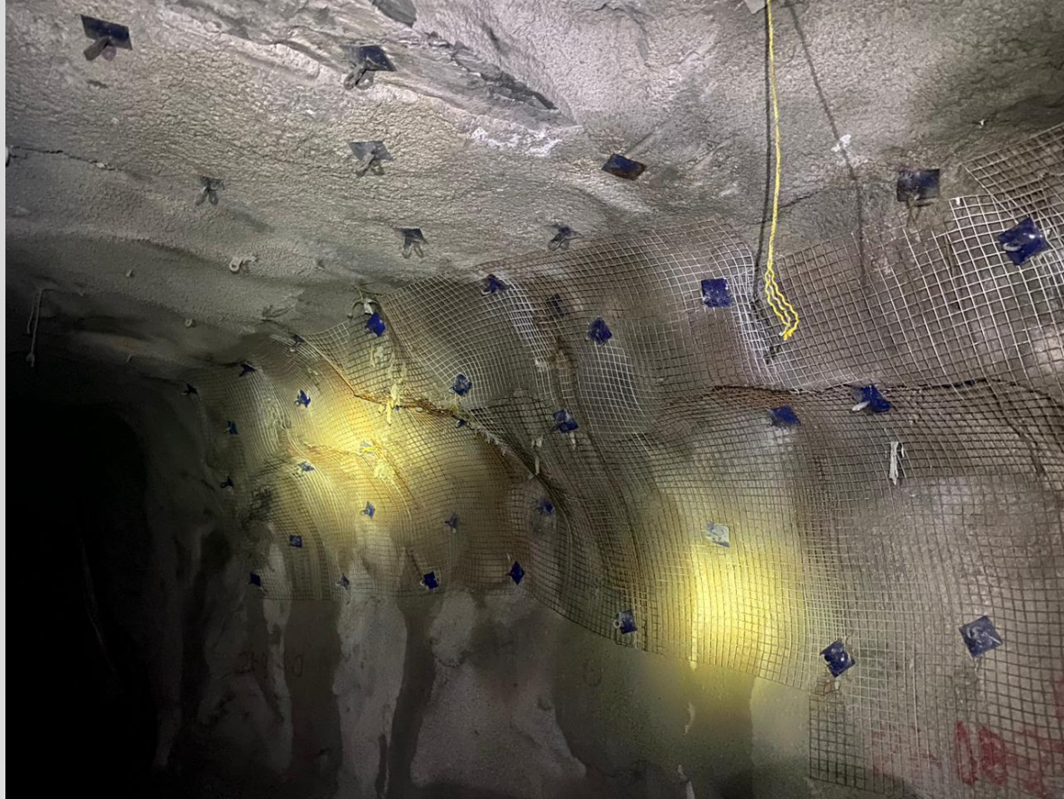
Foto 7. Colocación de malla en Túnel de Acceso
