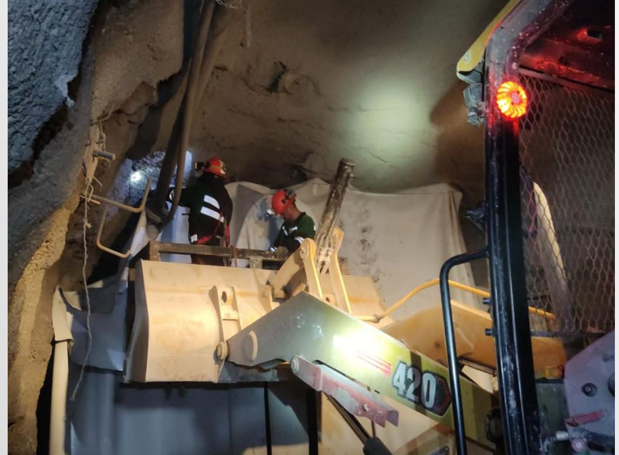
Foto 10. Trabajos para mejorar el Sistema de Ventilación.
