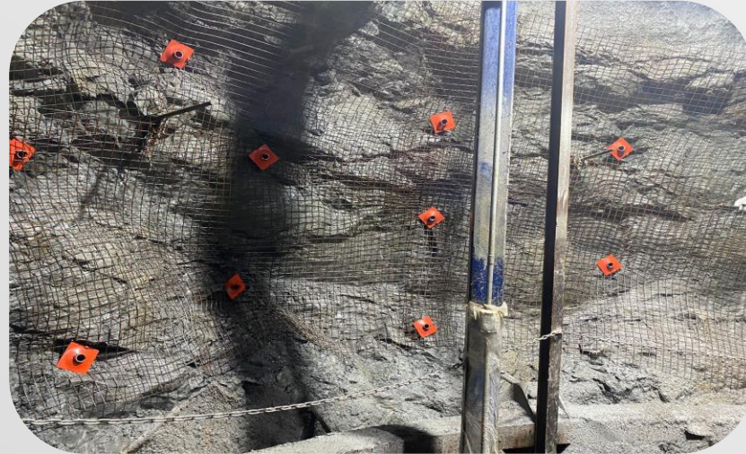
Foto 1. Colocación de malla y anclas.
