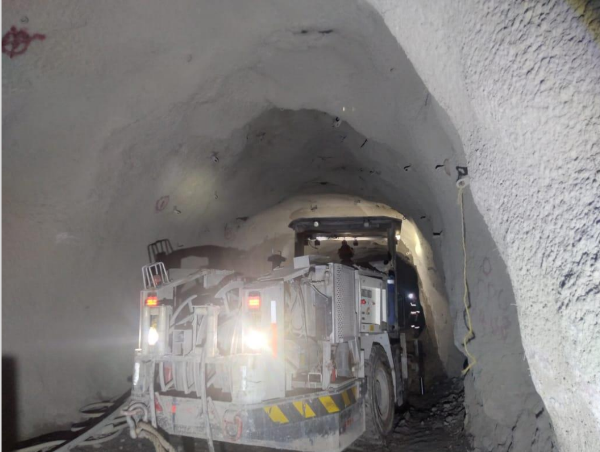
Foto 9. Actividades de barrenación en Túnel de Ventilación.
