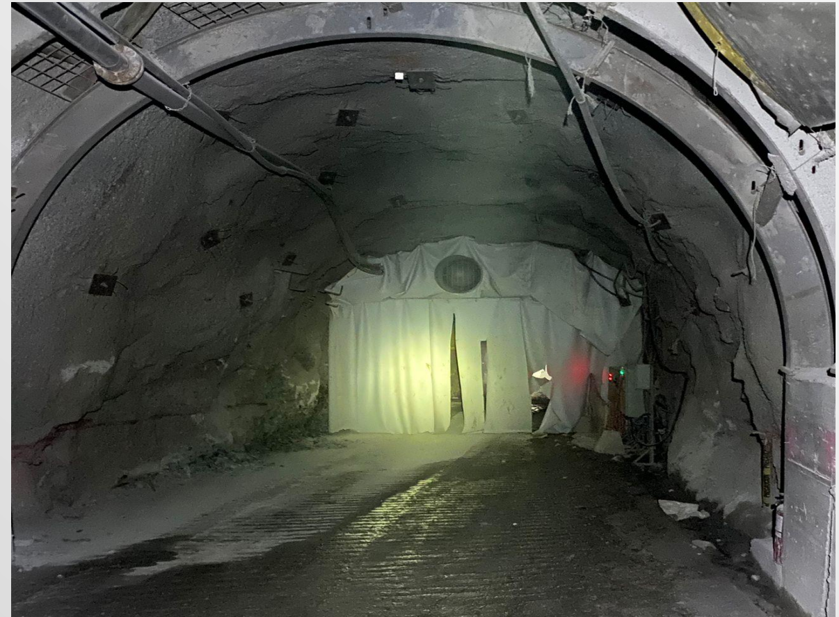
Foto 8. Colocación de cortina en cruce para mejorar Sistema de Ventilación.
