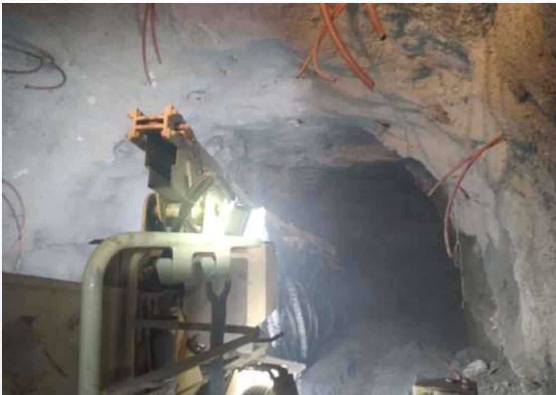
Figura 7: Colocación de concreto lanzado en Túnel de Ventilación
