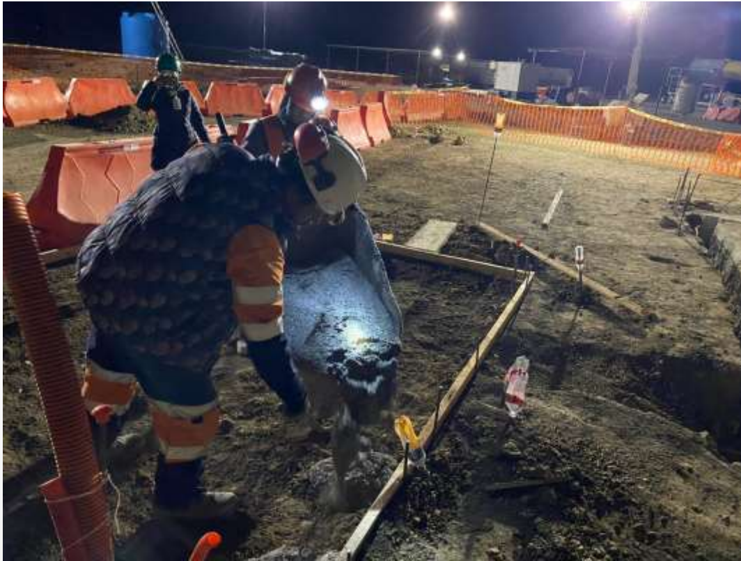
Figura 6: Se realiza la cimentación para la subestación en la lumbrera PCT-1
