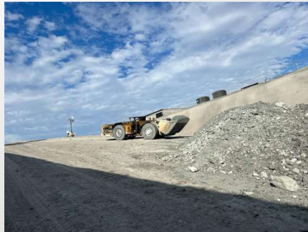
Figura 8: Rezagado del material producto de voladura en el túnel de ventilación.
