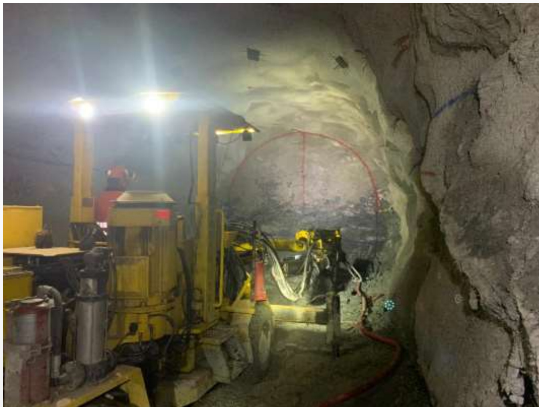
Figura 5: Barrenación de plantilla para voladura en túnel de ventilación.
