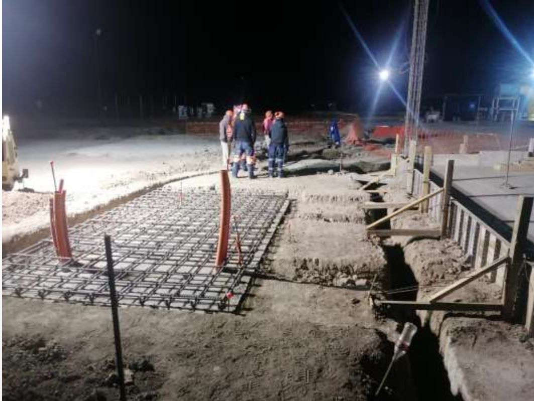
Figura 9: Actividades es excavación en subestación de PCT-2.
