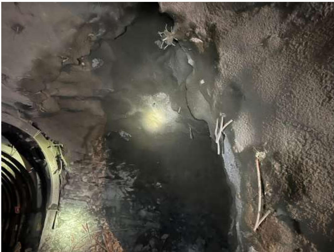
Figura 1: Lanzado de concreto en cargadero de túnel de acceso.
