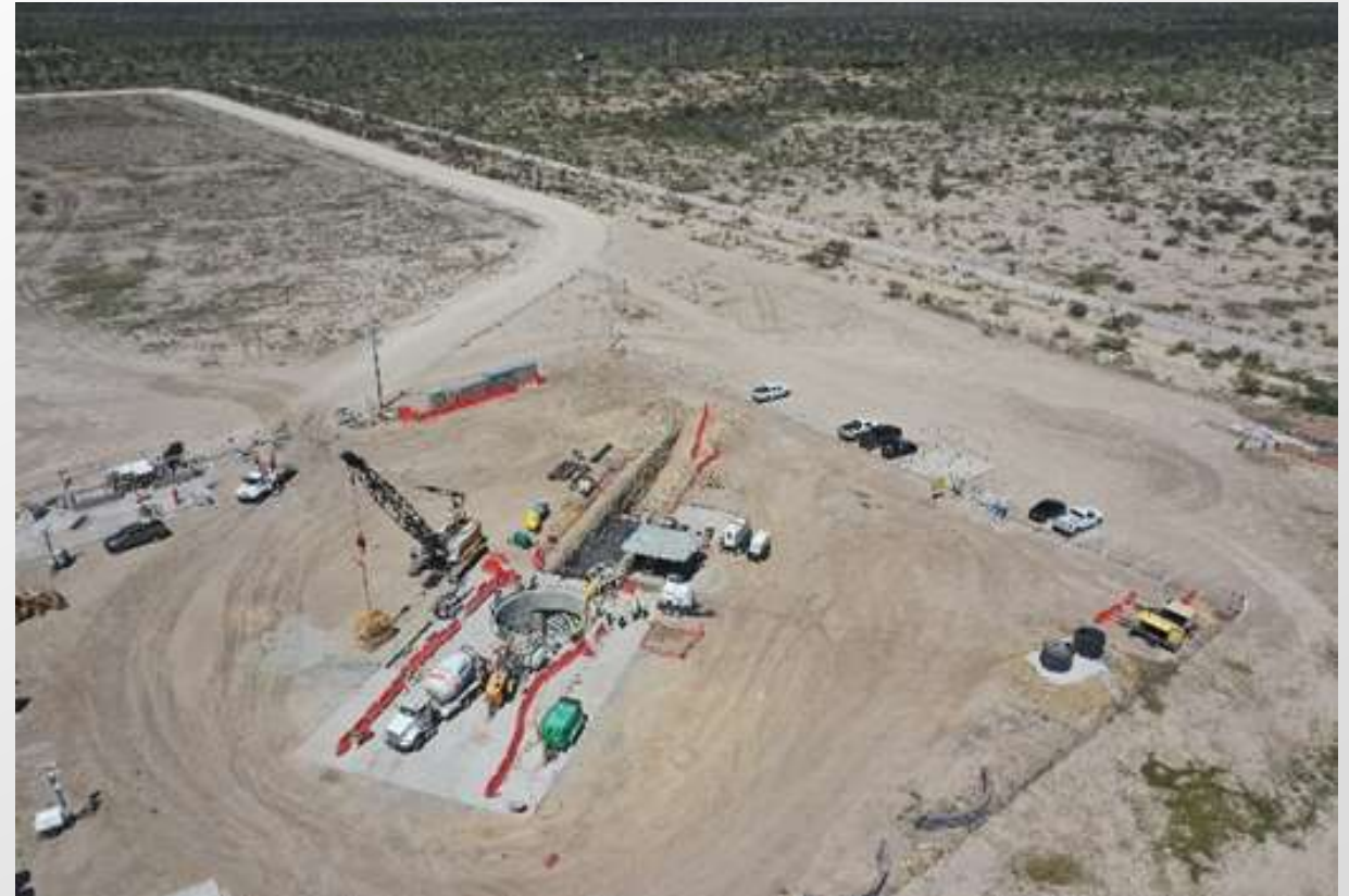
Figura 8: Vista aérea de la lumbrera PCT-2.
