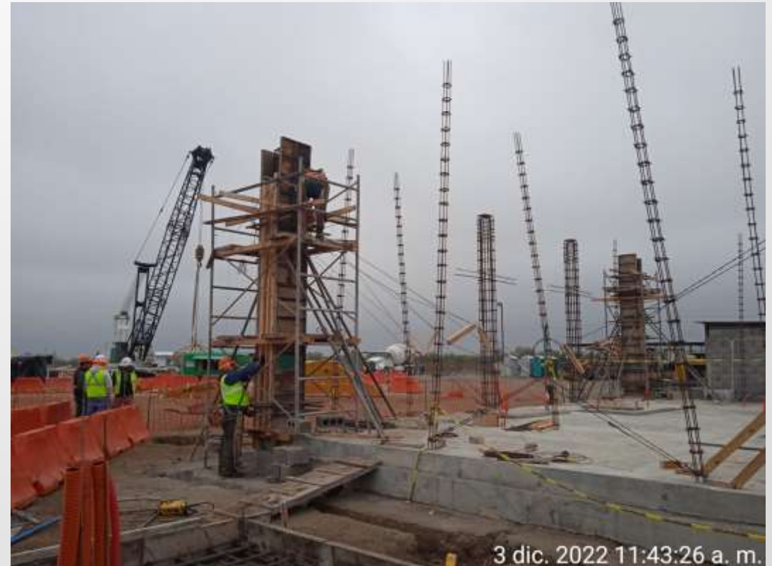
Figura 5: Cimbrado de columnas en subestación PCT-1.
