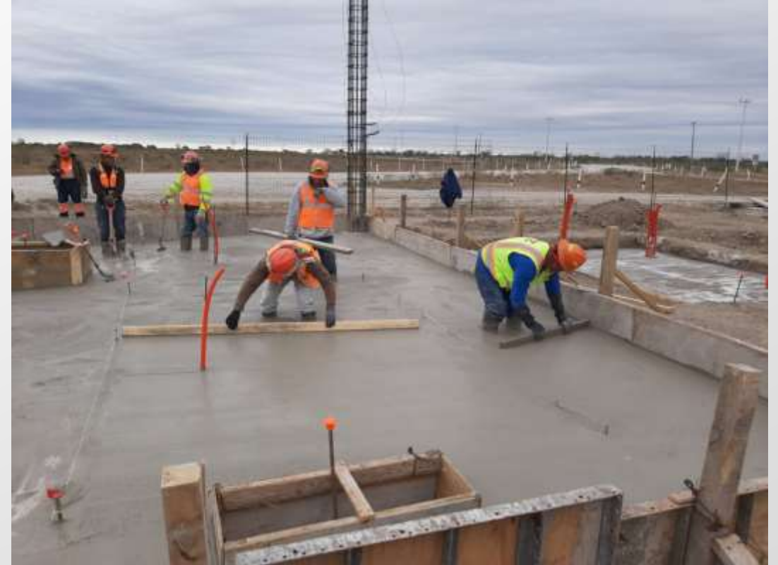
Figura 12: Colado de losa en subestación de PCT-2.
