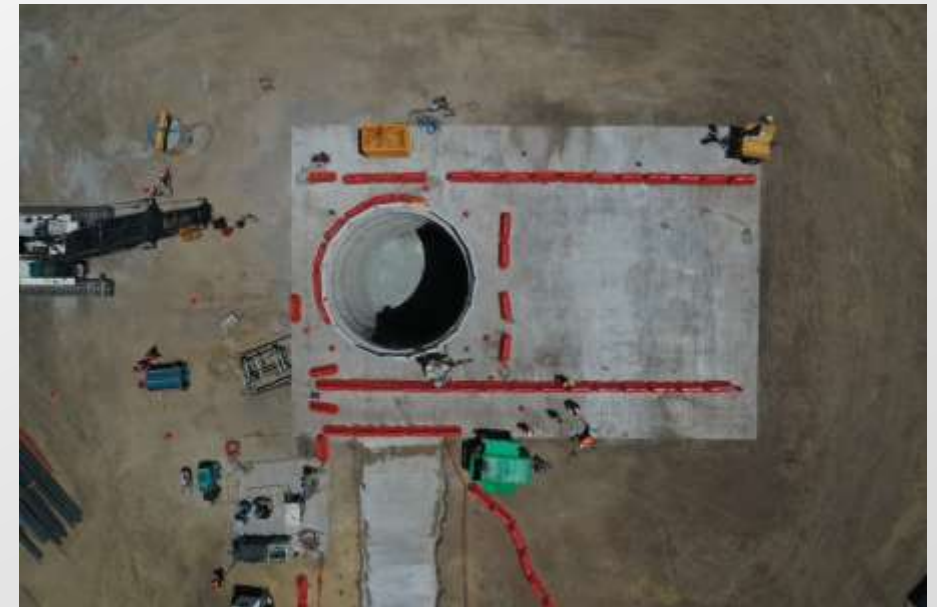
Figura 1: Vista aérea de la lumbrera PCT-1.
