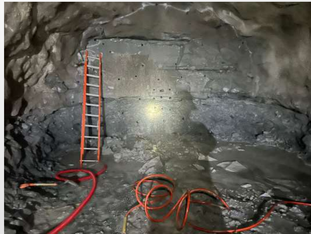
Figura 2: Barrenación de plantilla para voladura en túnel de acceso.
