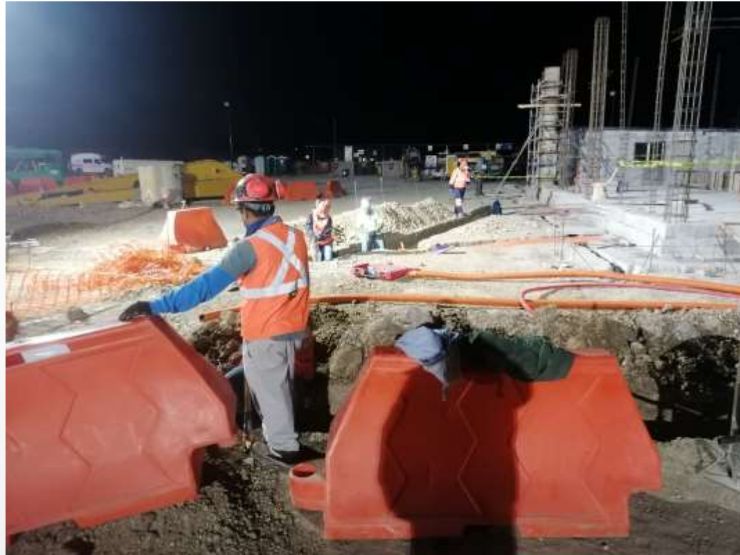
Figura 4: Excavación para tubería de cables eléctricos en subestación PCT-1.
