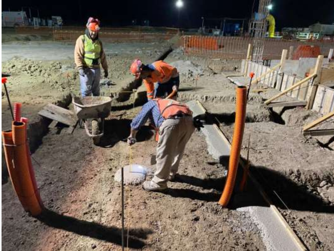
Figura 11: Colado de plantilla en trinchera por medio manuales en PCT-2.
