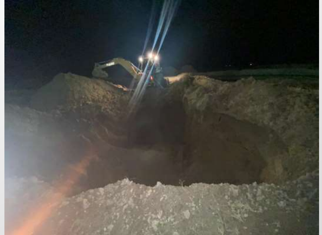
Figura 10: Trabajos en cárcamo por medios manuales en PCT-2.
