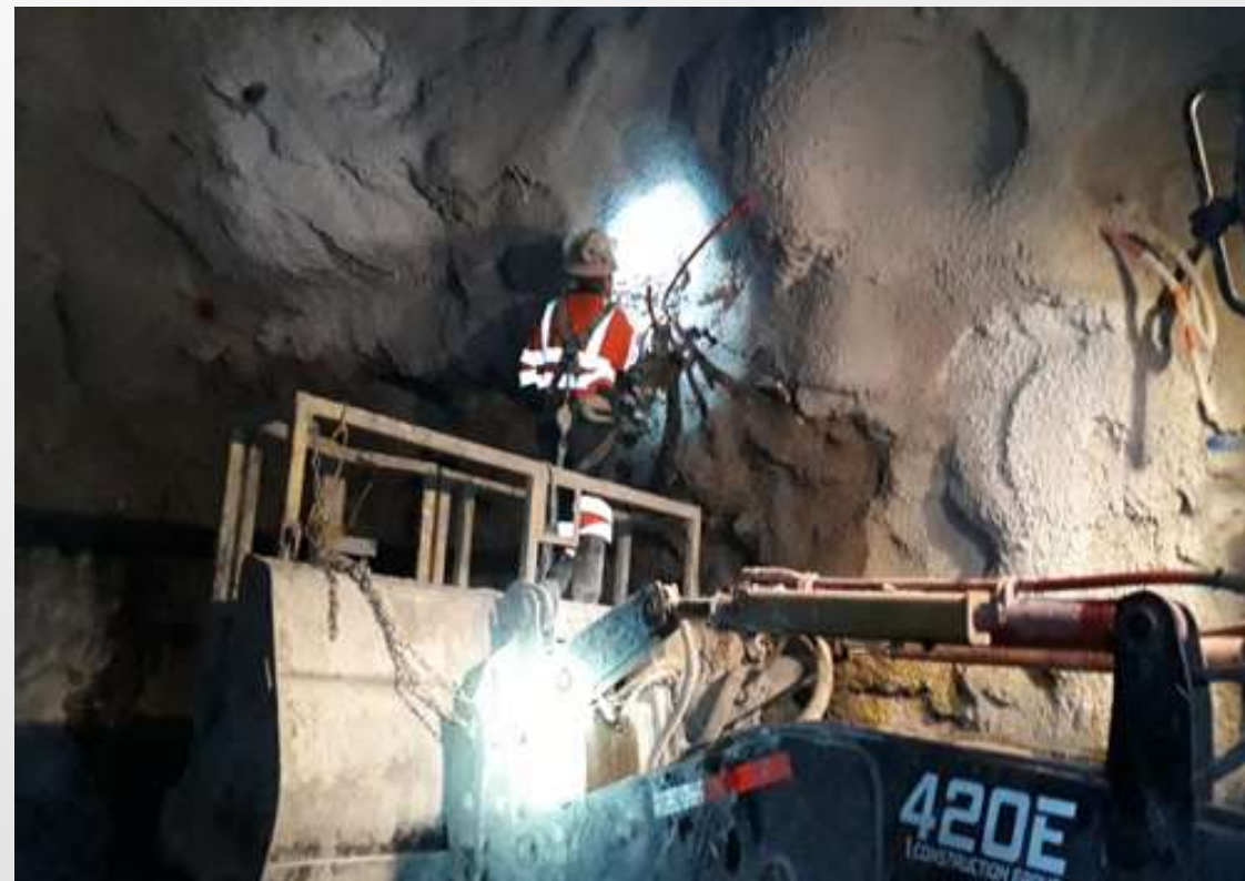
Figura 6: Calafateo de anclas para tratamiento en el Túnel de Ventilación..
