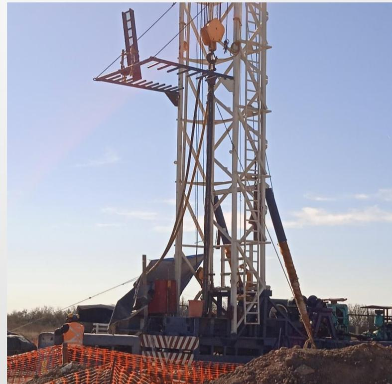
Imagen 11: Trabajos de perforación del pozo **PCE-04**. Continúa a la profundidad de 138.00 m con 19". Continúa exploración con broca de 12"  $\frac{1}{4}$  a la profundidad de 153.80 m. La galería se encontró a la profundidad de 149.70 mts.
