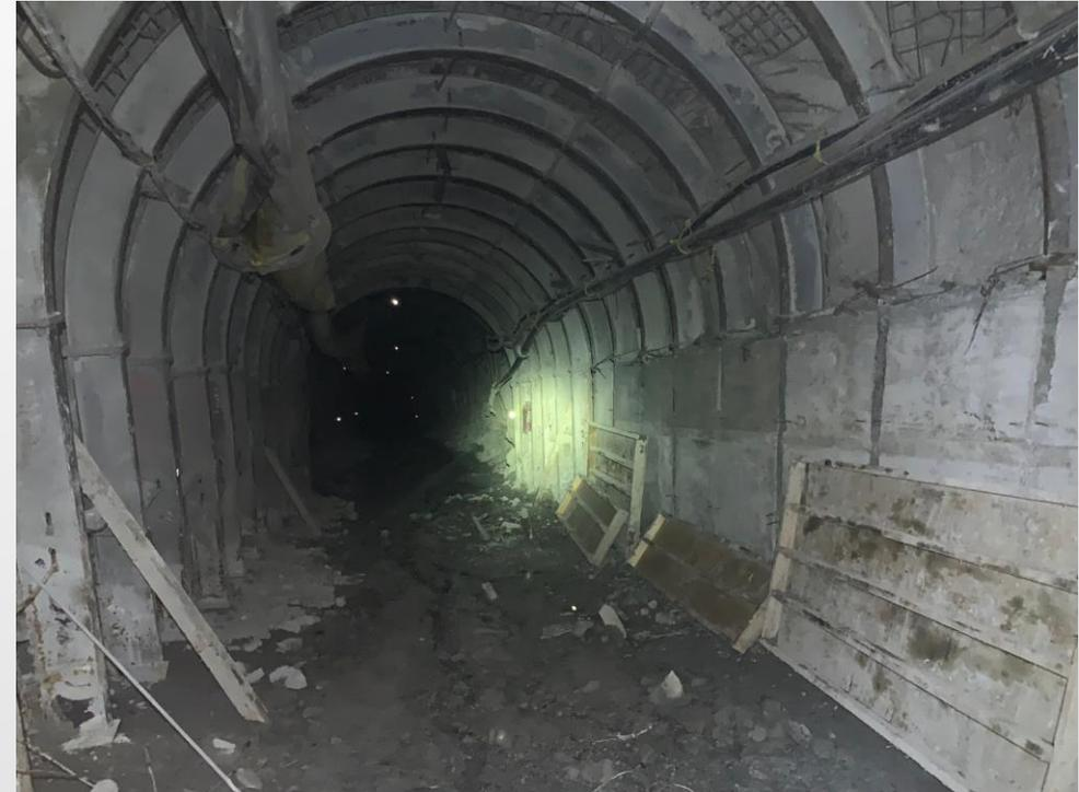
Imagen 2. Avance de colado en hastiales túnel de ventilación.
