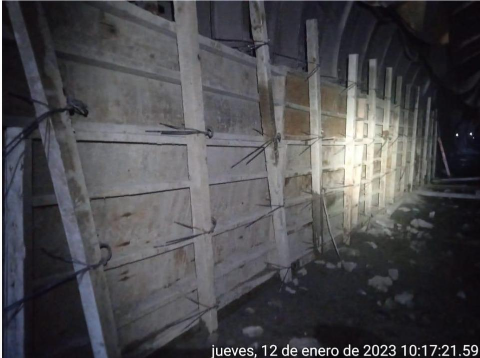
Imagen 1. Se encuentra colocada cimbra en tabla izquierda, del marco 75 al 88, en espera de recibir concreto en el túnel de ventilación.
