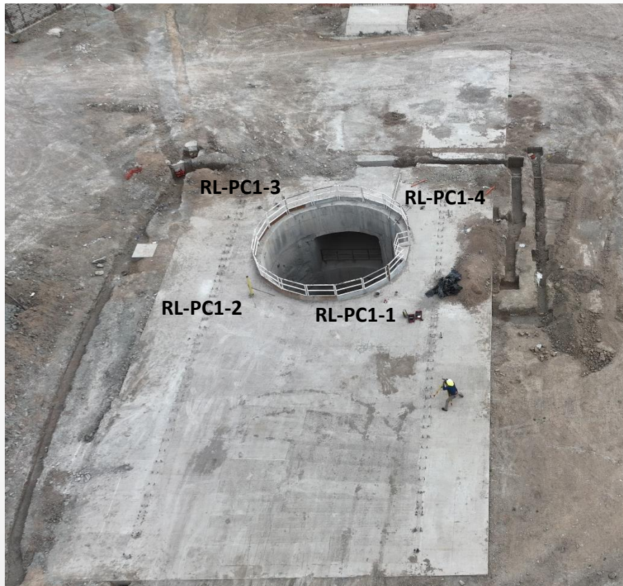
Imagen 14 – Ubicación de referencias topográficas en la lumbrera PCT-2
