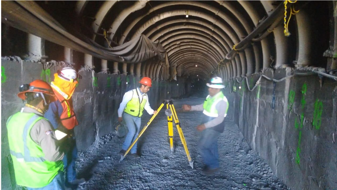
Imagen 1 y 2. Monitoreo de la estabilidad e integridad de los túneles por parte del área de Topografía y Supervisión.
