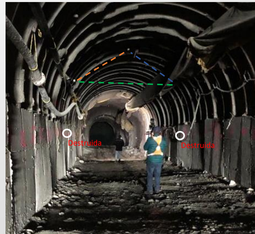
Imagen 27 – Sección de dianas reflejantes del cadenamiento 0+166.75
