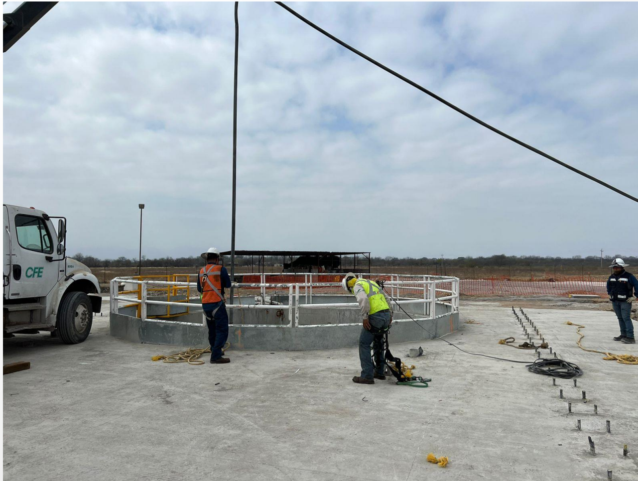
Fotografía 6. Maniobras para conexión de bomba.
