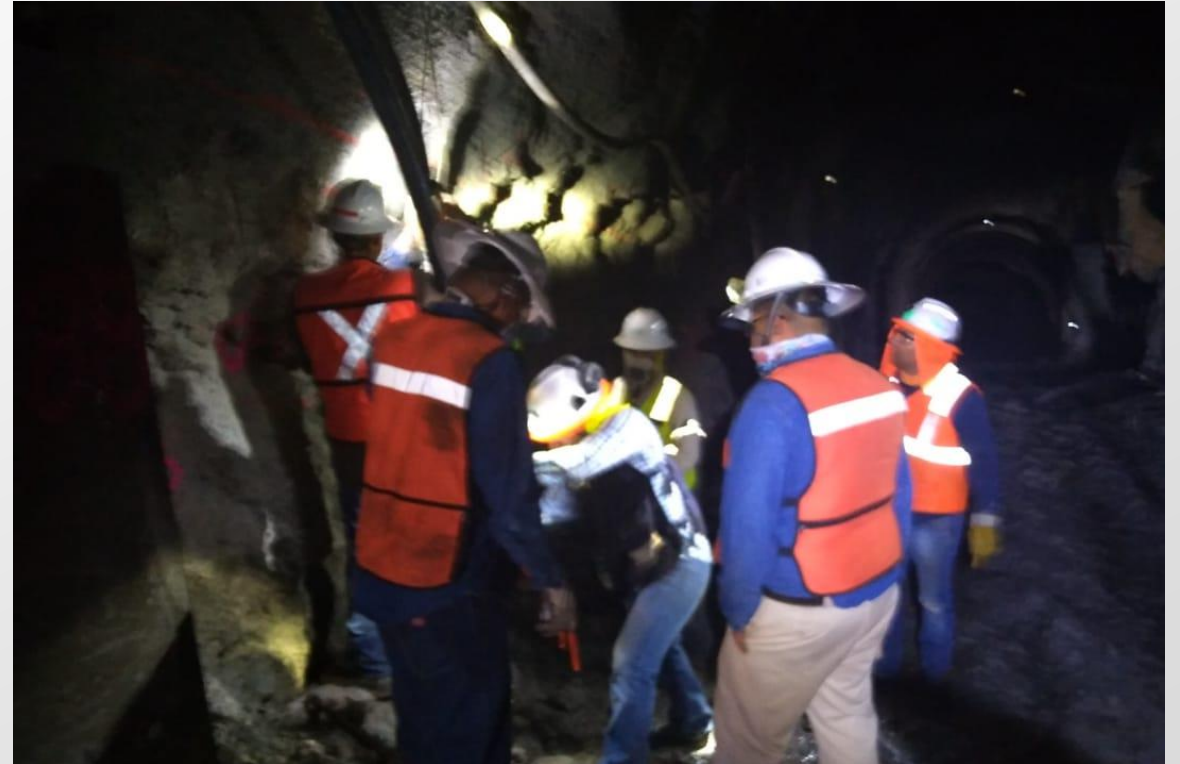
Fotografía 9. Actividades de conexión de tubería.
