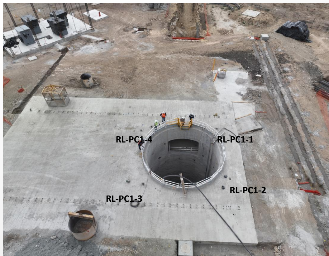
Imagen 13 – Ubicación de referencias topográficas en la lumbrera PCT-1
