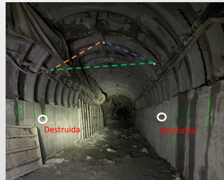
Imagen 24 – Sección de dianas reflejantes del cadenamiento 0+166.75
