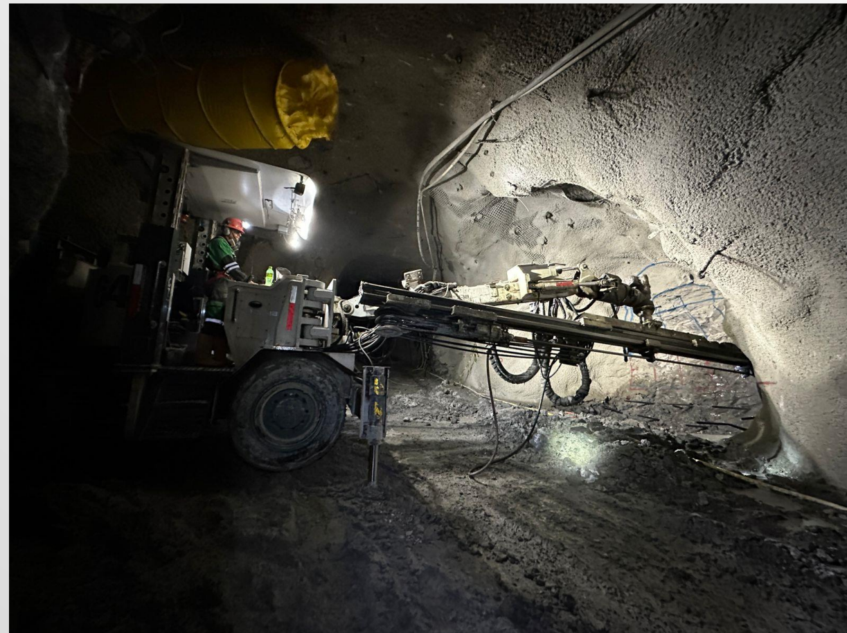
Foto 11. Barrenación de plantilla para voladura (cargadero).
