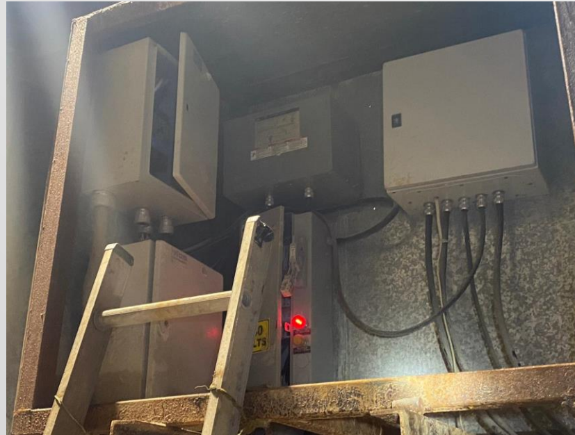
Foto 2. Inspección de nicho eléctrico.
