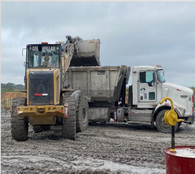
Foto 4. Limpieza de patio.
