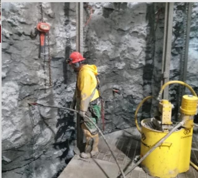
Foto 5. Colocación de anclas.
