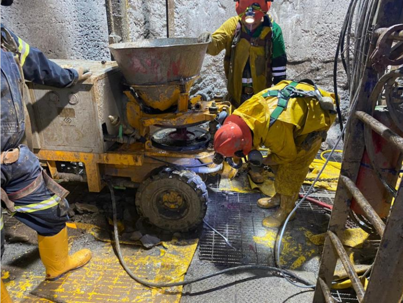
Figura 1. Actividades de lanzamiento de concreto.
