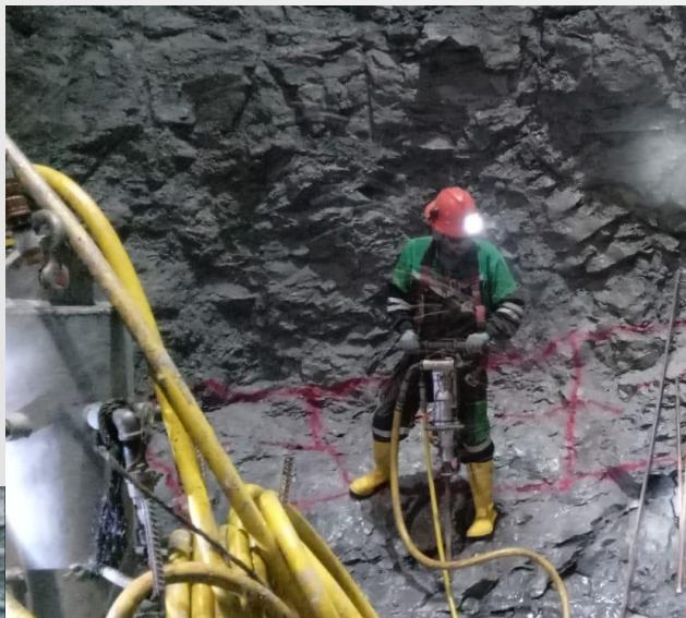
Foto 6. Colocación de explosivo.
