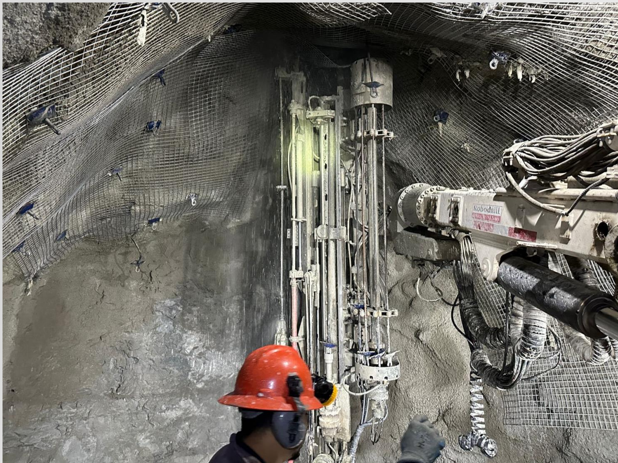
Foto 10. Colocación de anclas.
