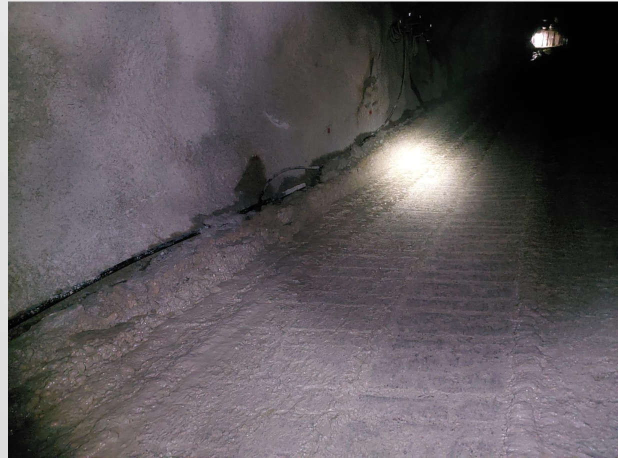
Foto 9. Limpieza y rezaga del material acumulado en la rampa.
