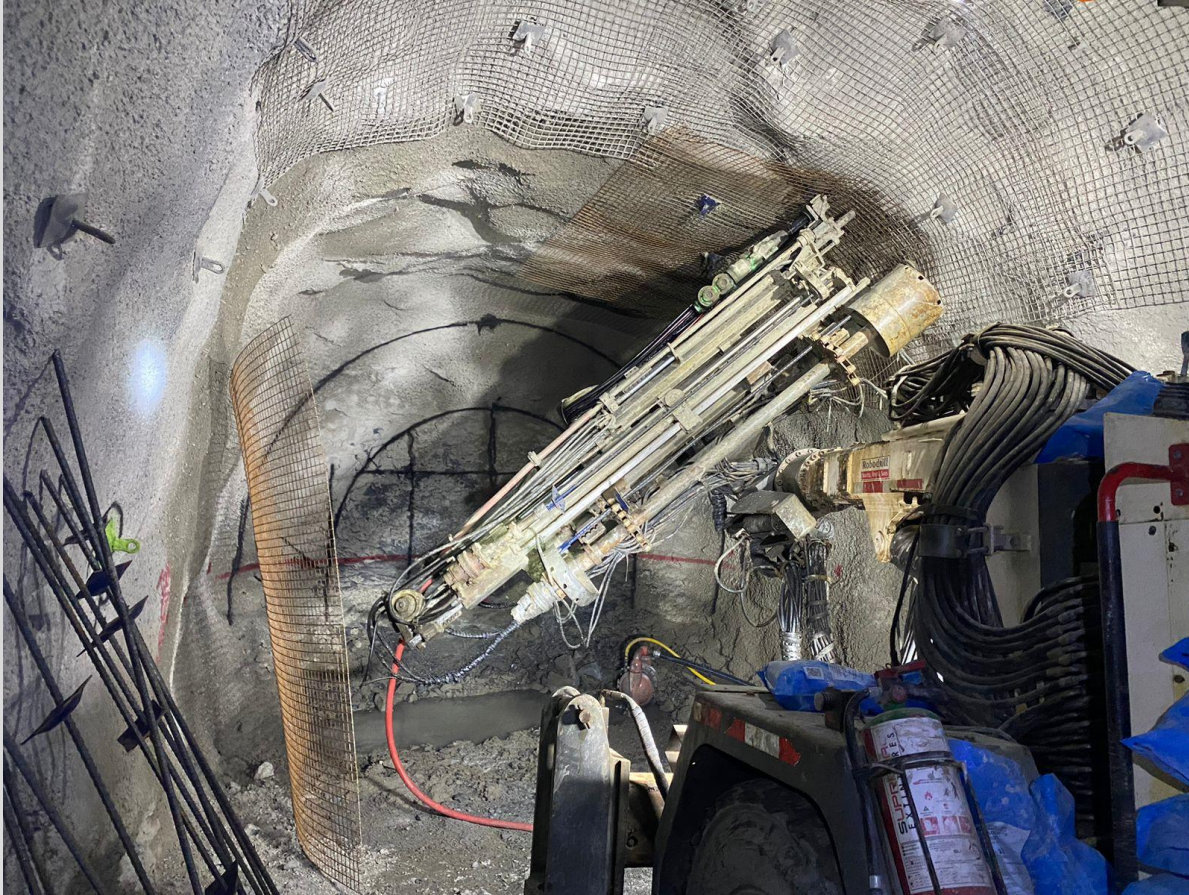
Foto 8. Actividades de anclaje y enmallado en rampa de acceso.
