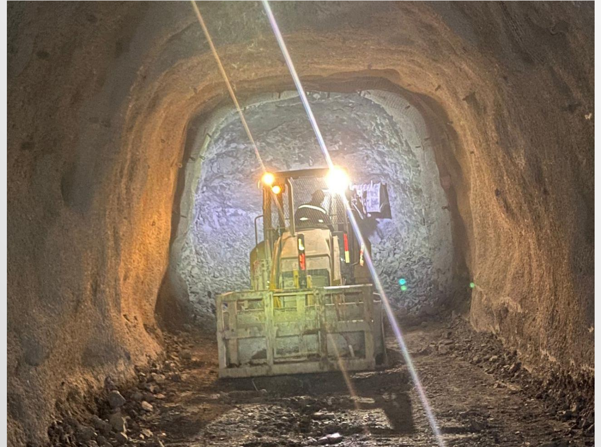
Foto 11. Trabajos de amacice en tope de rampa de ventilación.
