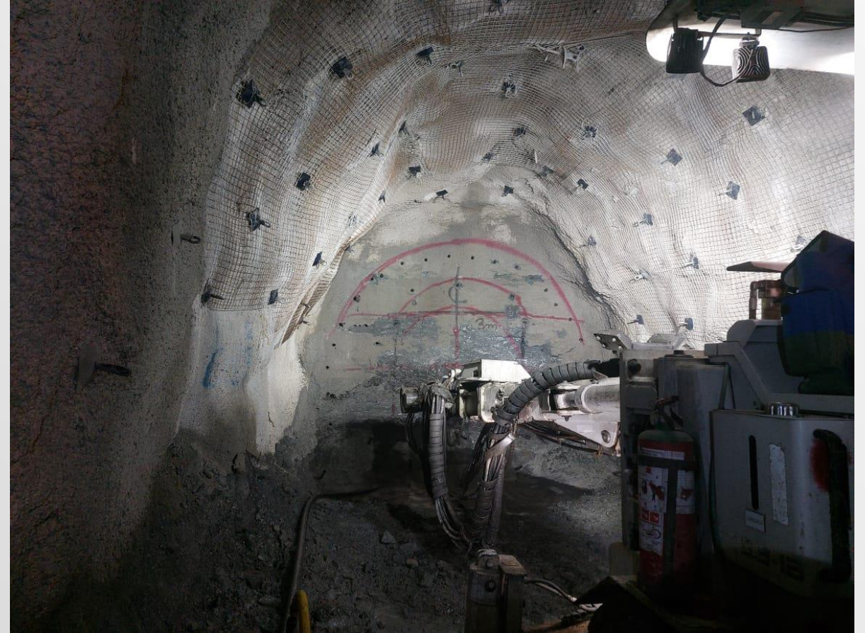
Foto 9. Trabajos de barrenación para plantilla de voladura en rampa de acceso.
