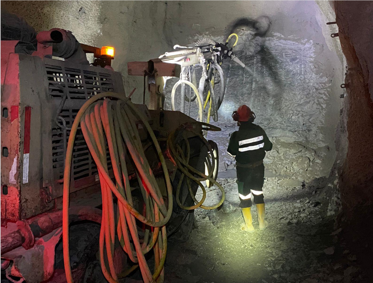
Foto 10. Colocación de concreto lanzado en rampa de ventilación.
