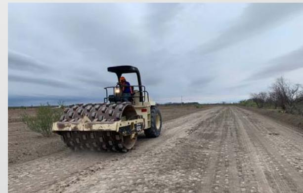
Figura 16: Compactadora pata de cabra
