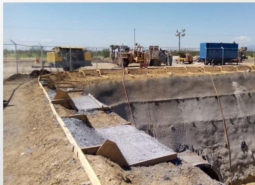
Figura 8: Colado del borde de protección del talud en el Portal de Entrada.
