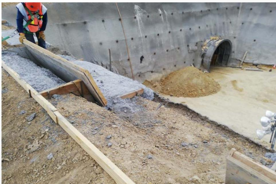
Figura 7: Colado del borde de protección del talud en el Portal de Entrada.
