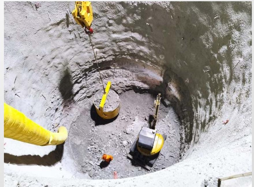
Figura 5: Retiro de material producto de la voladura.
