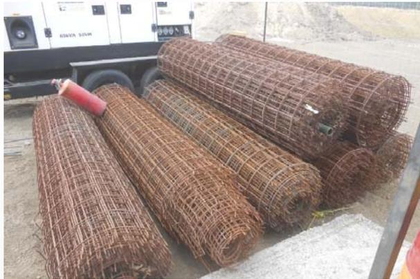
Figura 13: Malla electrosoldada (concreto lanzado)
