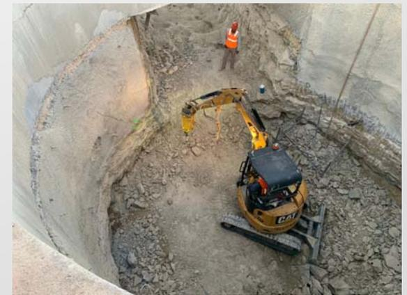
Figura 6: Perfilamiento y afine de taludes verticales
