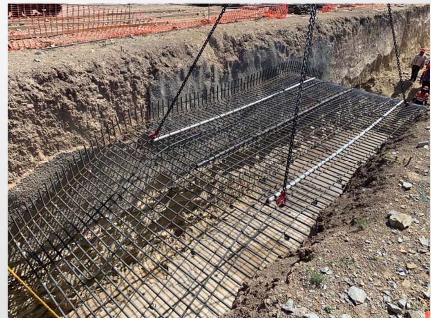
Figura 10: Colocación de acero de refuerzo de la losa de cimentación de la galería de ventilación.
