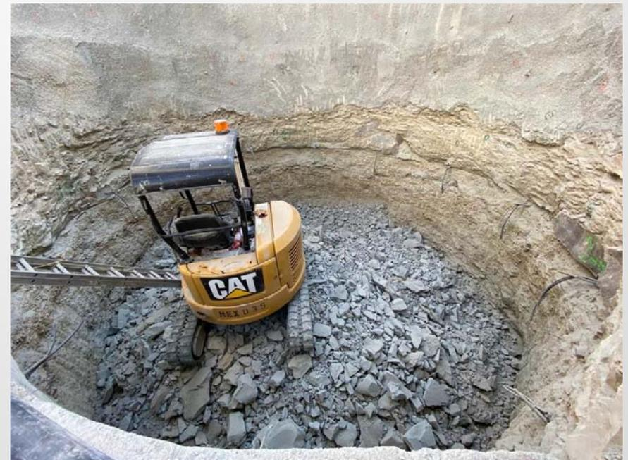
Figura 8: Perfilamiento de taludes verticales .
