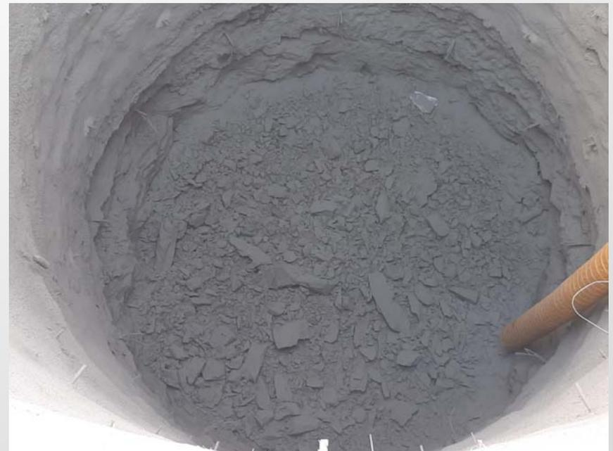
Figura 3: Vista del material producto de la voladura .
