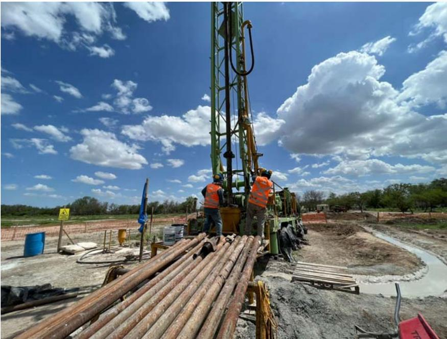
Figura 1: Perforación del pozo PCV 02
