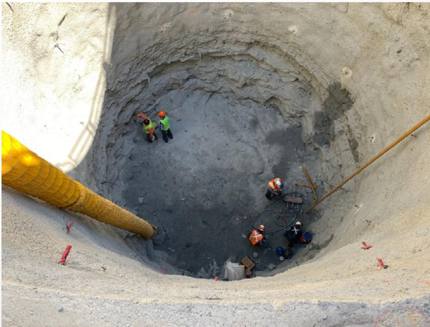
Figura 4: Perfilado de taludes
