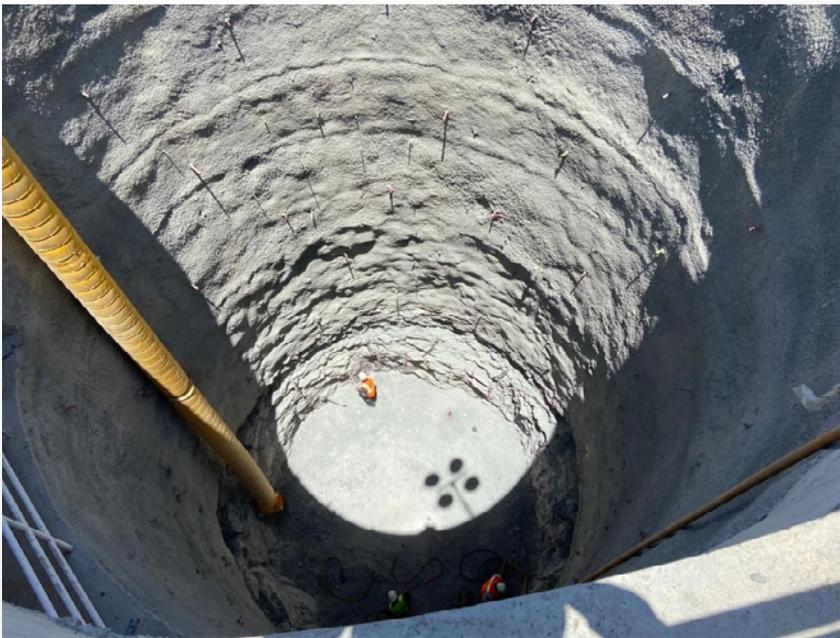
Figura 2: Perforación de barrenos para posterior colocación de alto explosivo.
