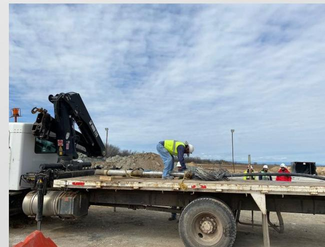
Fotografía 12. Retiro de bomba y transporte de bomba.
