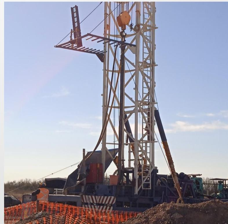
Imagen 12: Trabajos de perforación del pozo **PCE-04**. Se concluyó la perforación con un diámetro 12"  $\frac{1}{4}$  (158 m) y se llevan 138.00 m con diámetro de 19".
