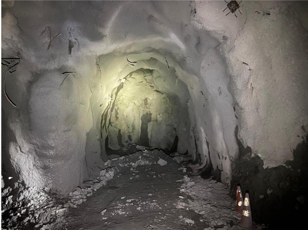
Imagen 5. Cargadero del Túnel de Acceso (avance de 13.75 m).
