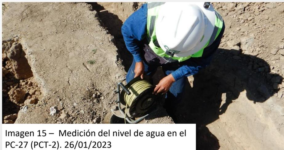
Imagen 15 – Medición del nivel de agua en el PC-27 (PCT-2). 26/01/2023
