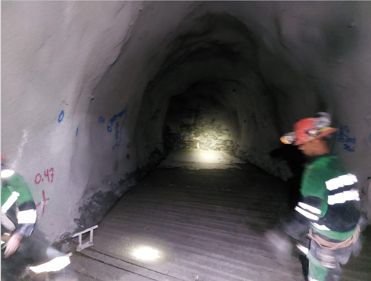
Foto 8. Trabajos de colado de losa.
