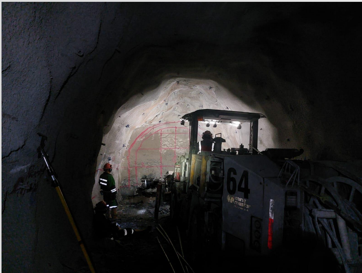
Foto 6. Trabajos de barrenación de plantilla para voladura.
