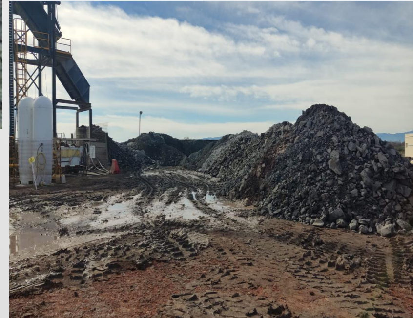
Foto 3. Material producto de la voladura.
