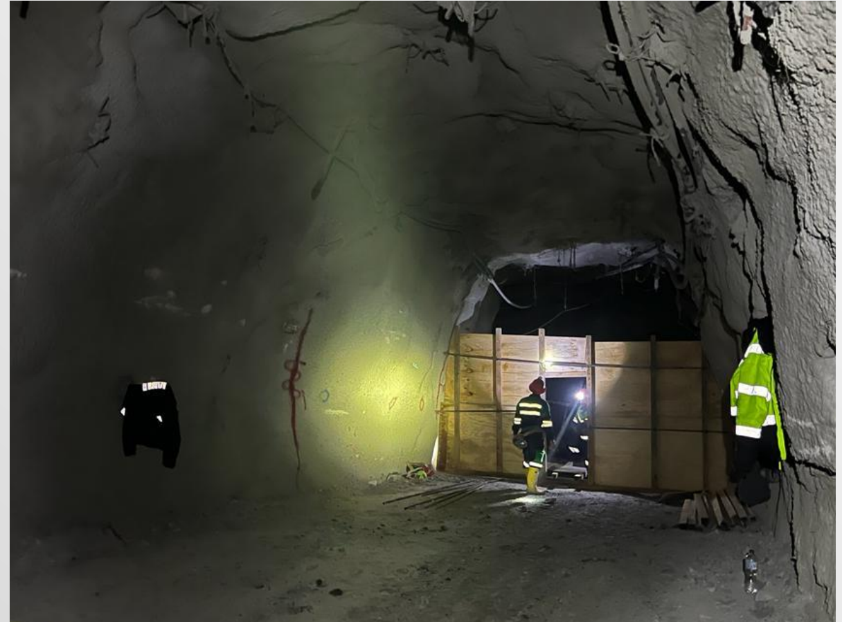
Foto 9. Construcción de tapón en Crucero 1.
