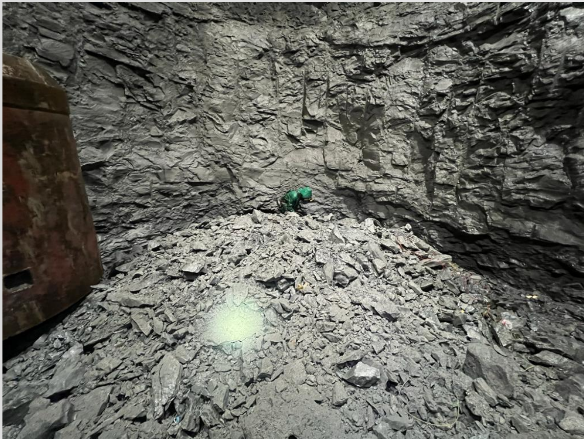
Foto 4. Material producto de la voladura.
