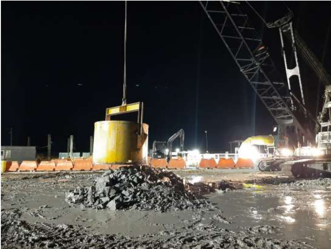
Figura 2: Rezagado del material producto de voladura en la lumbrera PCT-1
