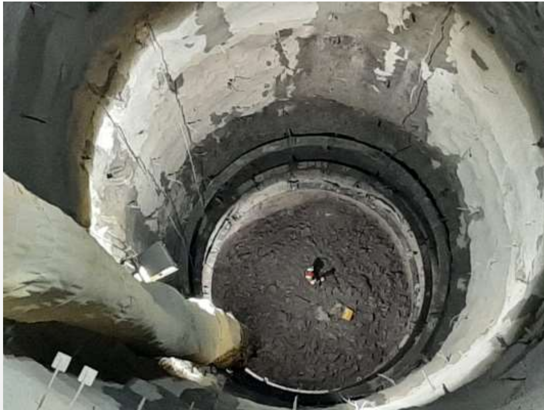
Figura 4: Levantamiento topográfico en la lumbreira PCT-1.
