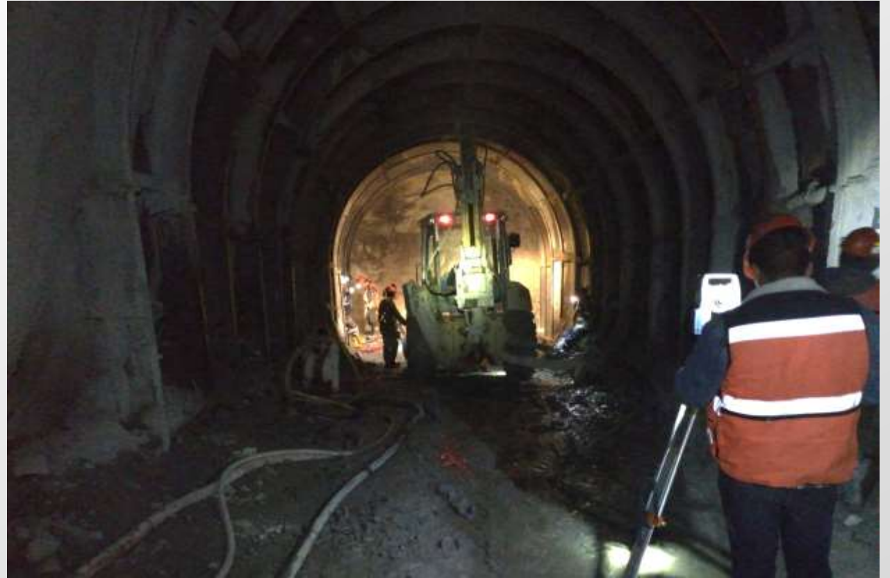
Figura 2: Nivelación de los marcos metálicos en el túnel de acceso con el apoyo del área de Topografía.
