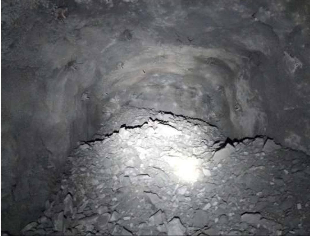
Figura 7: Material resultado de voladura en el túnel de ventilación.
