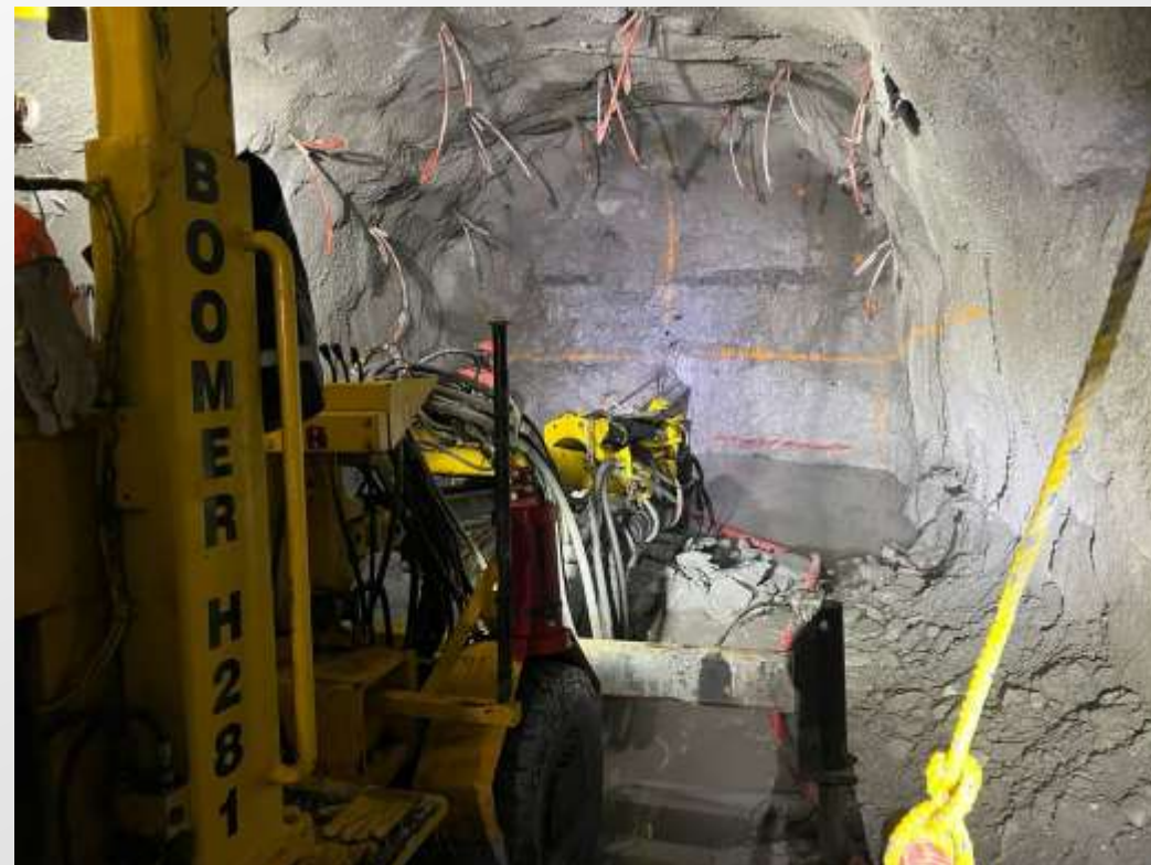
Figura 6: Barrenación de plantilla para voladura en túnel de ventilación.
