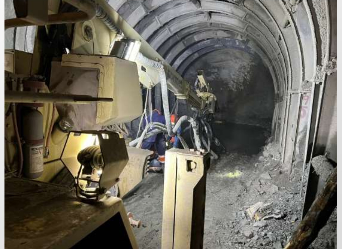
Figura 4: Trabajos de concreto lanzado en el túnel de acceso.
