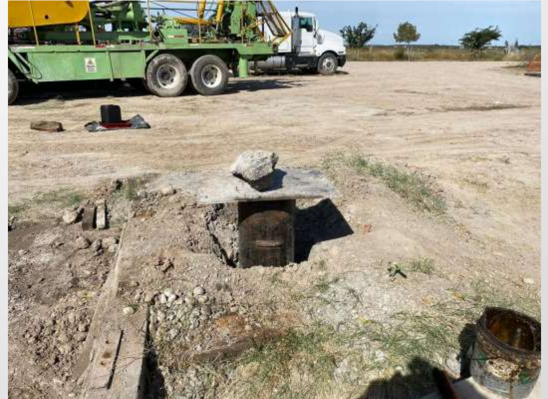
Figura 2: Se concluyó la perforación e instalación del pozo PCV-3 A a 166.00 metros . Quedando instalado a 165 m de profundidad.
