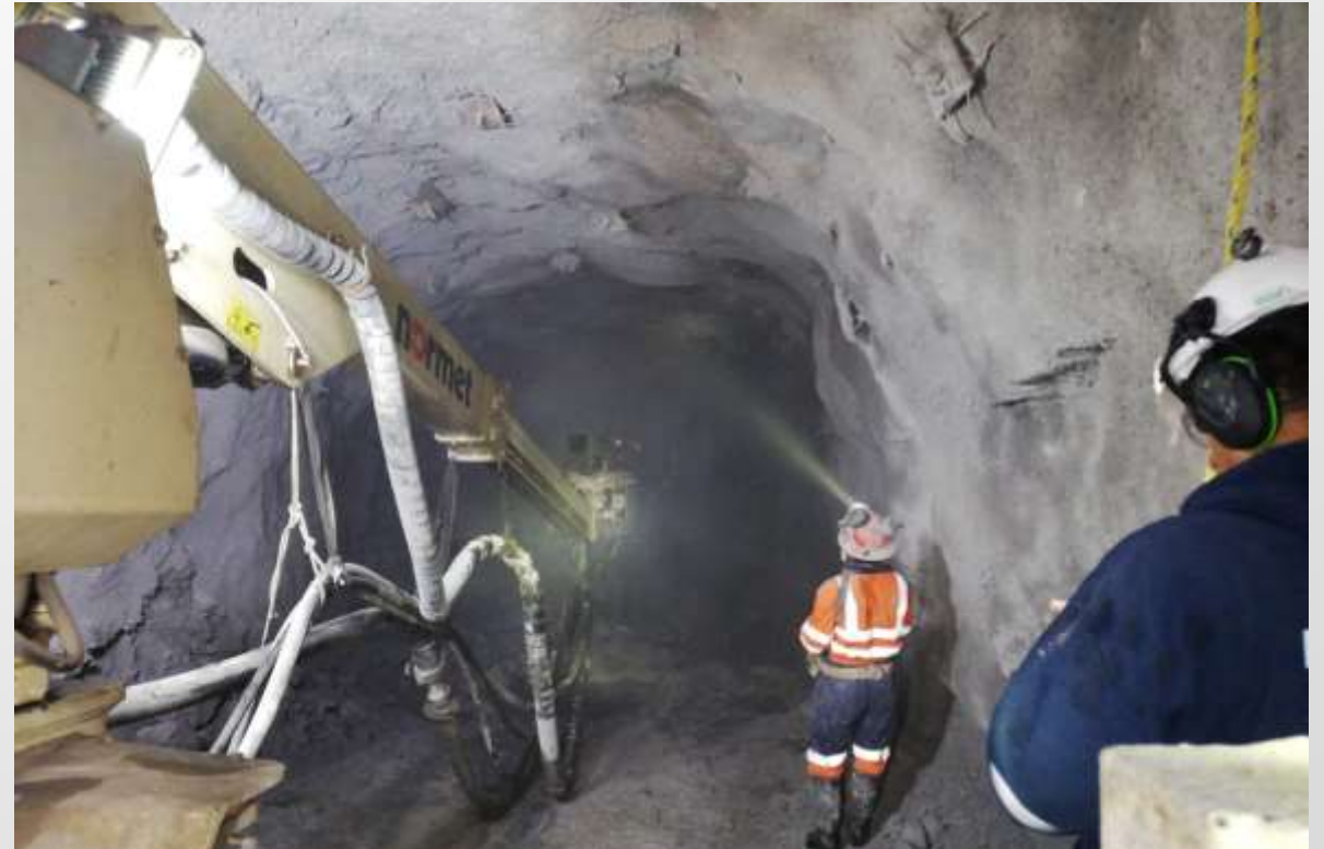
Figura 10: Trabajos de concreto lanzado en el túnel de ventilación.
