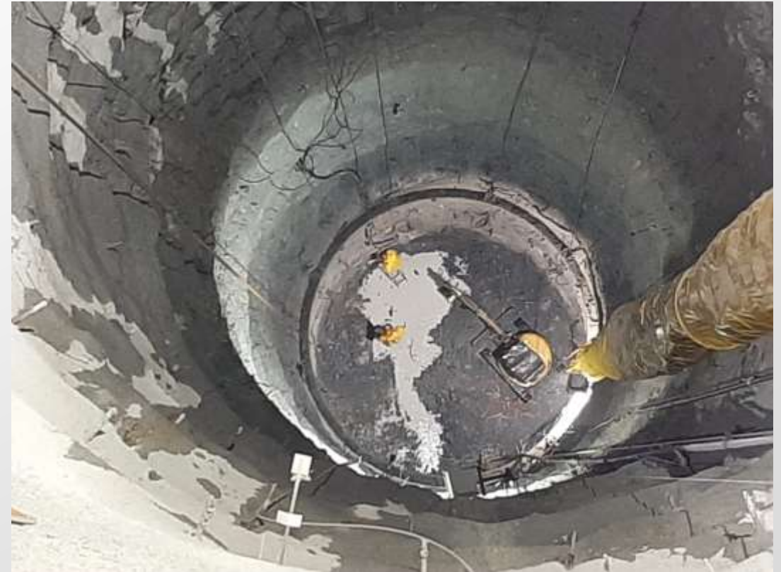
Figura 14: Inyección de anclas en la lumbrera PCT-2.
