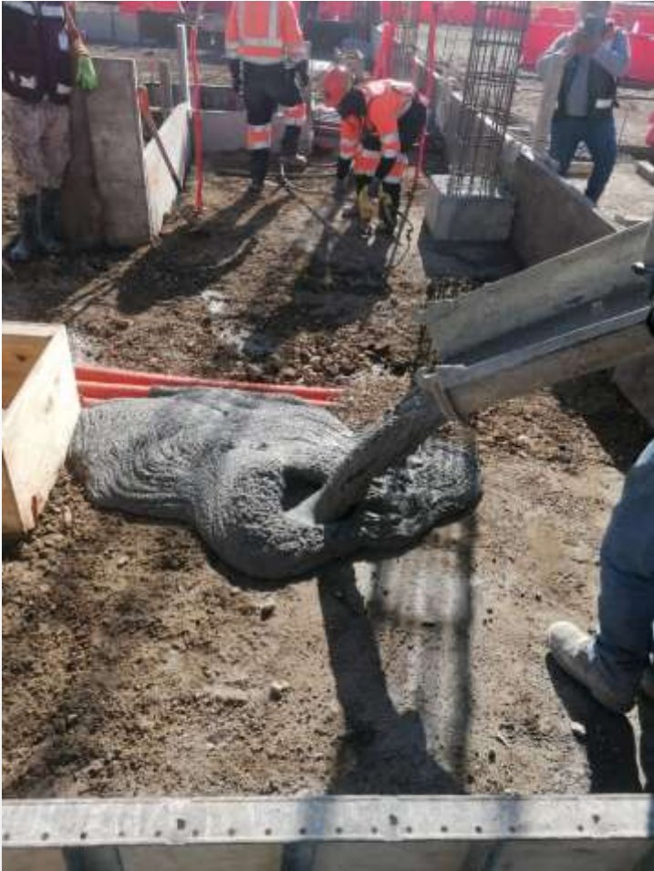
Figura 8 y 9: Se realiza la cimentación para la subestación en la lumbrera PCT-1
