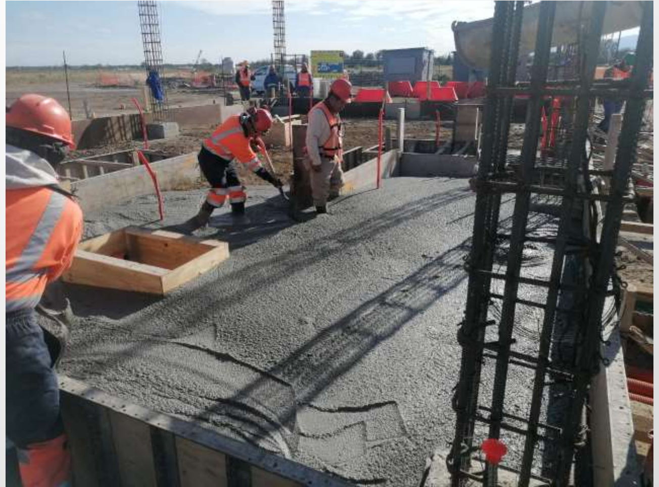
Figura 8 y 9: Se realiza la cimentación para la subestación en la lumbrera PCT-1
