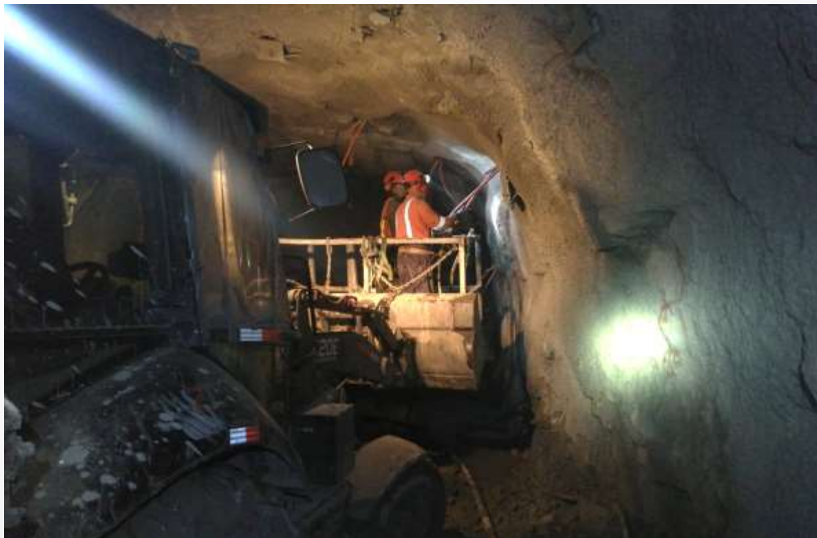
Figura 5: Inyección de anclas en el túnel de ventilación.
