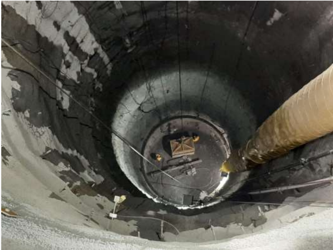
Figura 13: Barrenación de anclas en la lumbrera PCT-2.
