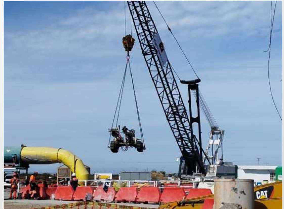
Figura 3: Ingreso de maquinaria para barrenación de anclas en la lumbrera PCT-1
