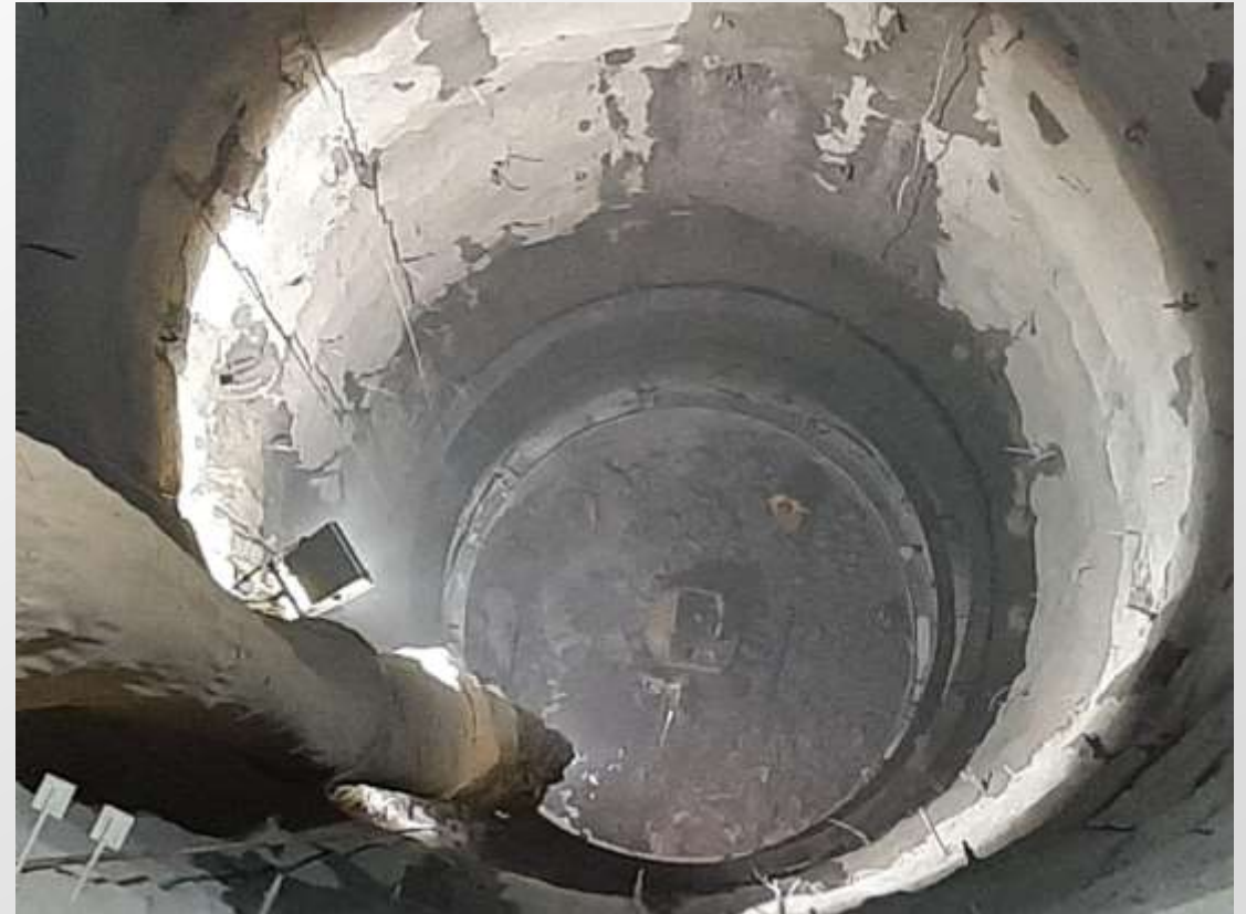
Figura 12: Perfilado de las paredes en la lumbrera PCT-2.
