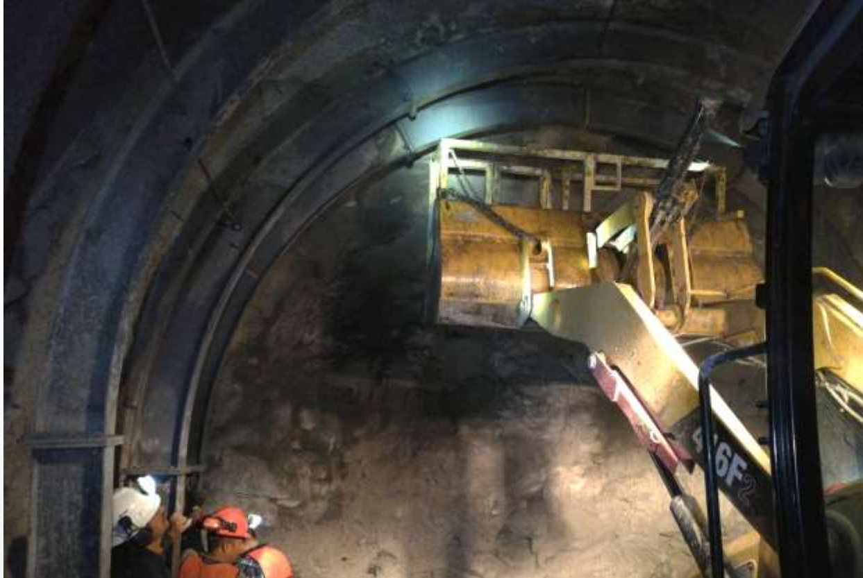
Figura 3: Colocación de marco metálico en el túnel de acceso.
