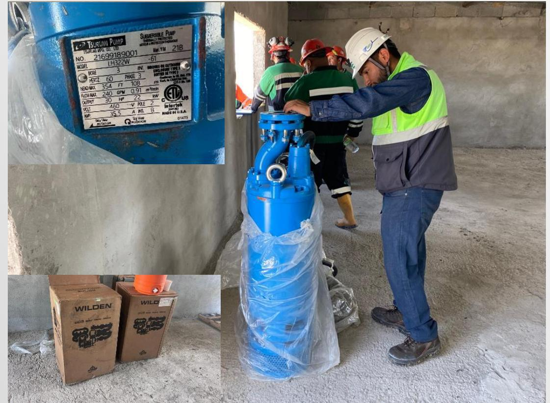
Imagen 12 – Revisión de bombas para la extracción del agua.
