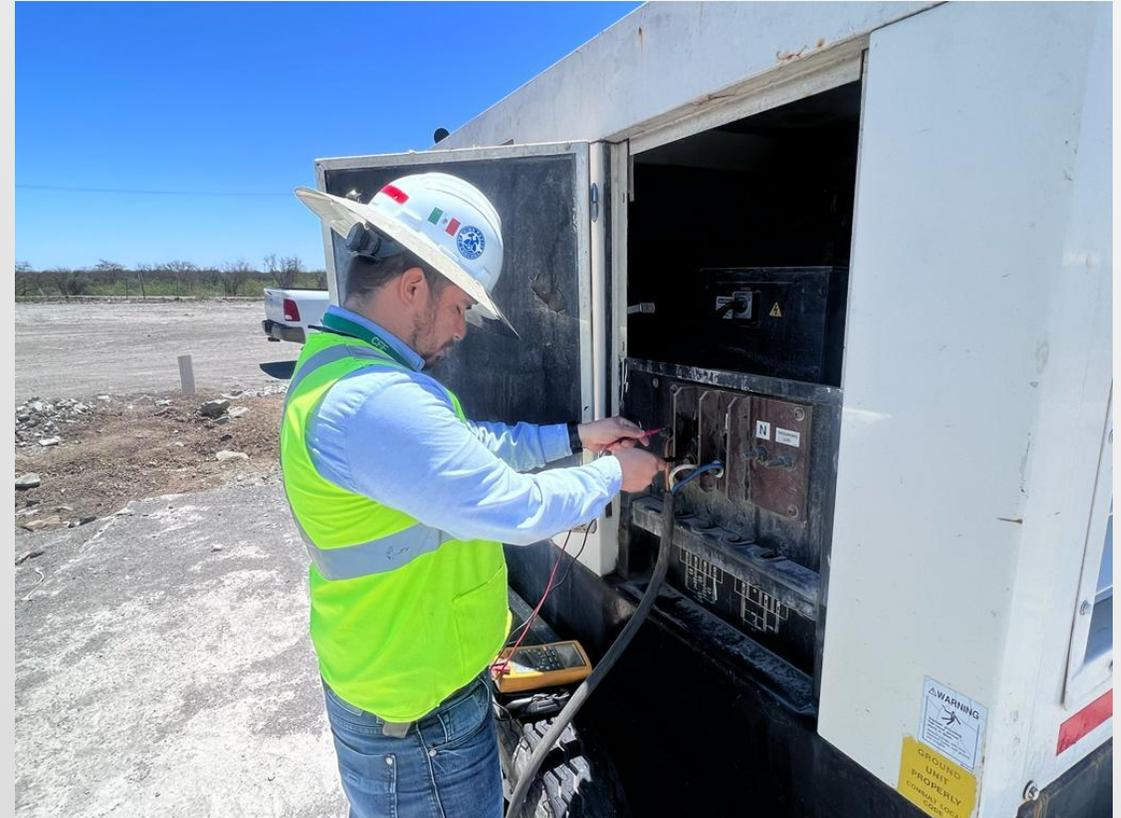
Imagen 14– Revisión de generador eléctrico
