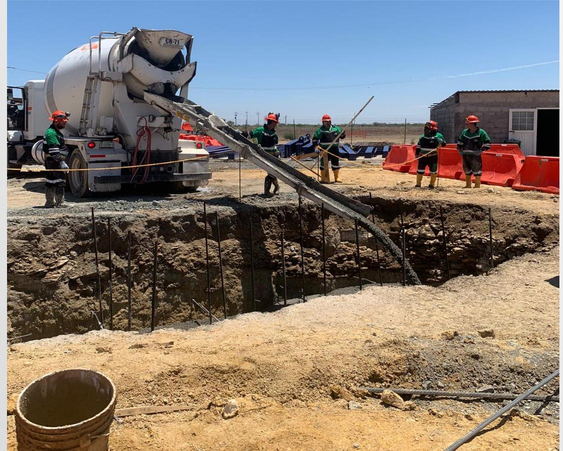
Imagen 7 y 8. Excavación y cimentación para la ubicación de winches y malacates.
