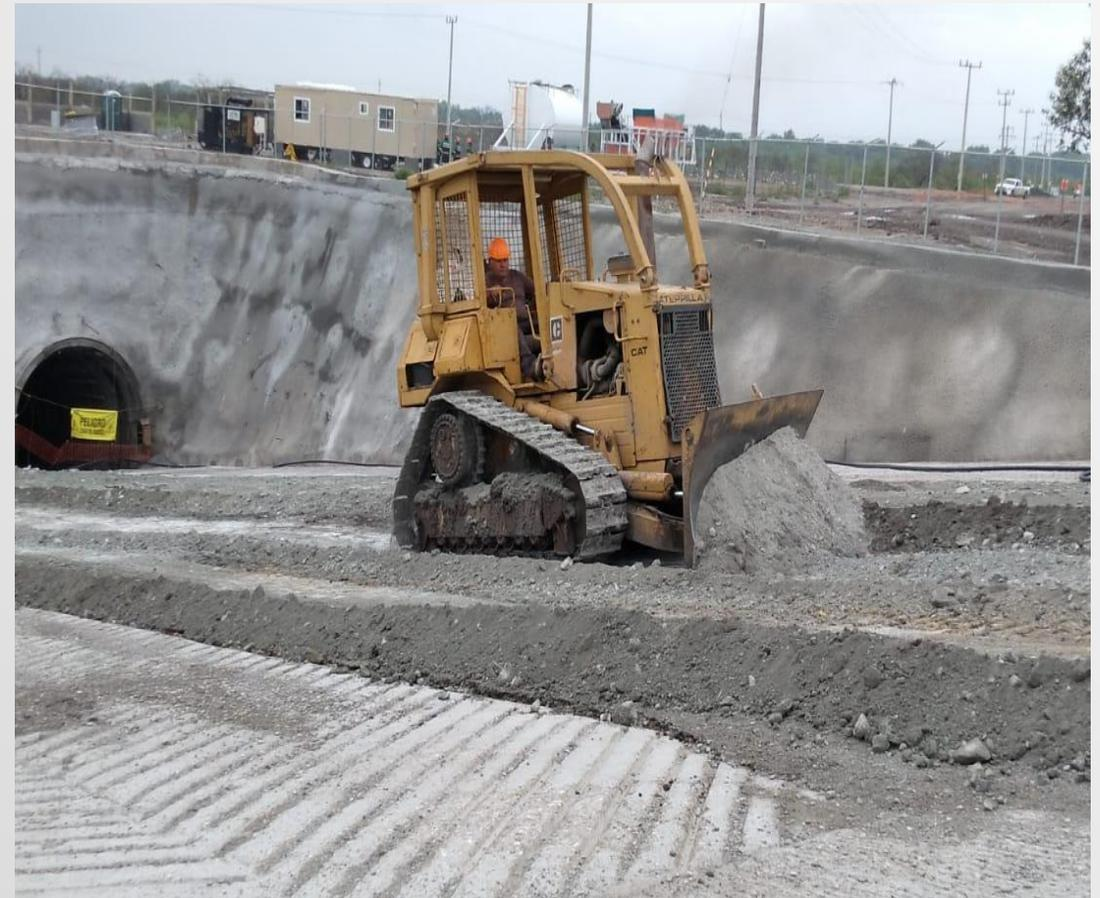
Imagen 10. Limpieza (retiro de material) de la losa en las rampas de acceso y ventilación.
