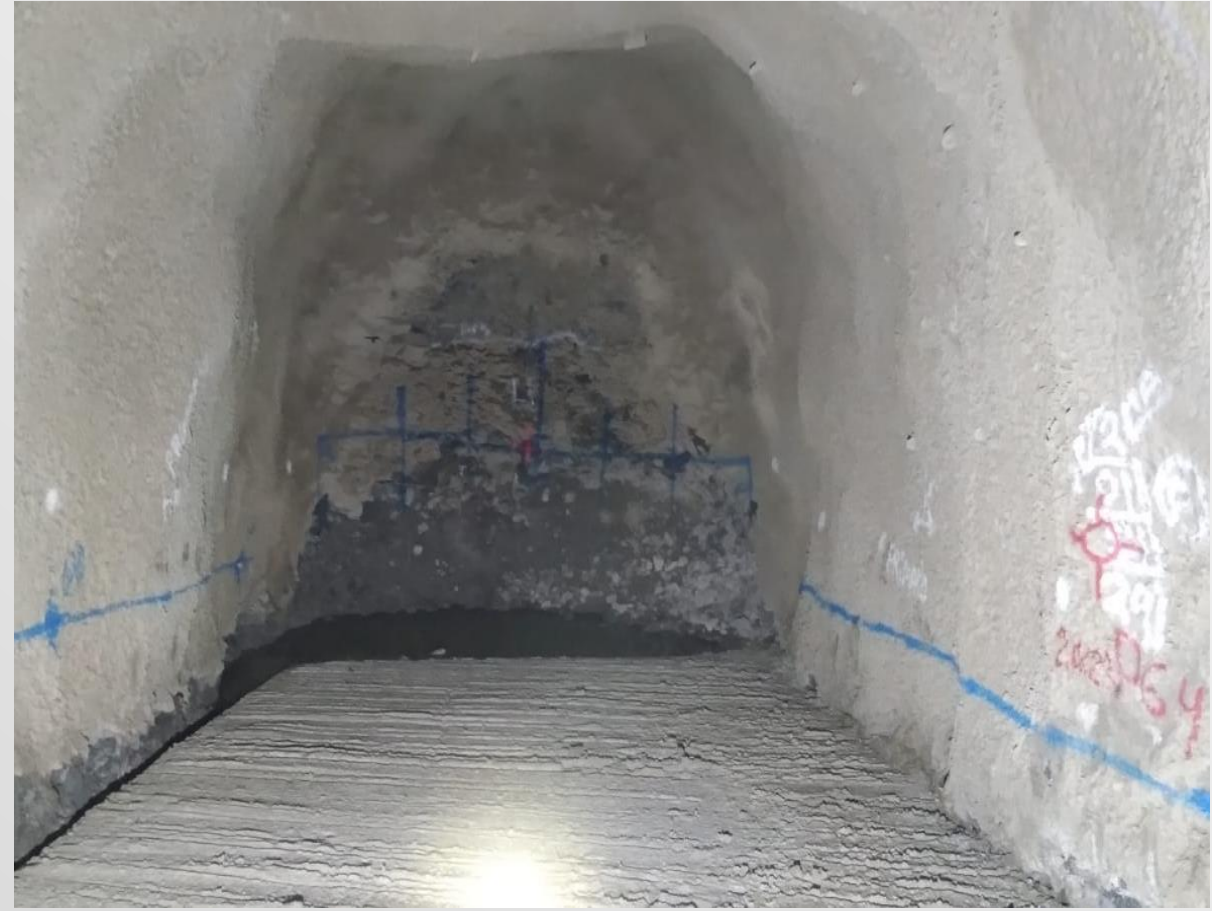
Foto 9. Colado de losa en tope de la rampa de ventilación.
