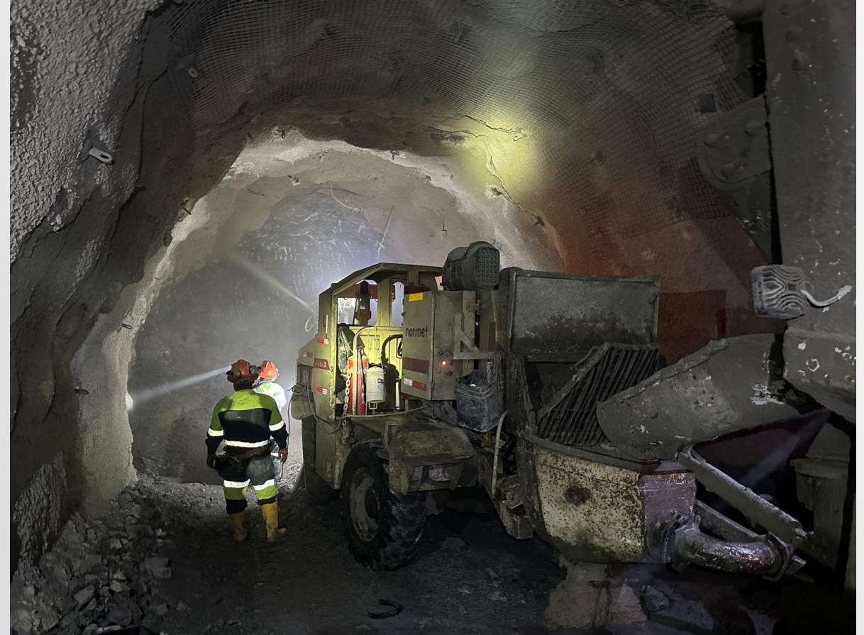
Foto 8. Trabajos de lanzamiento de concreto en rampa de acceso.
