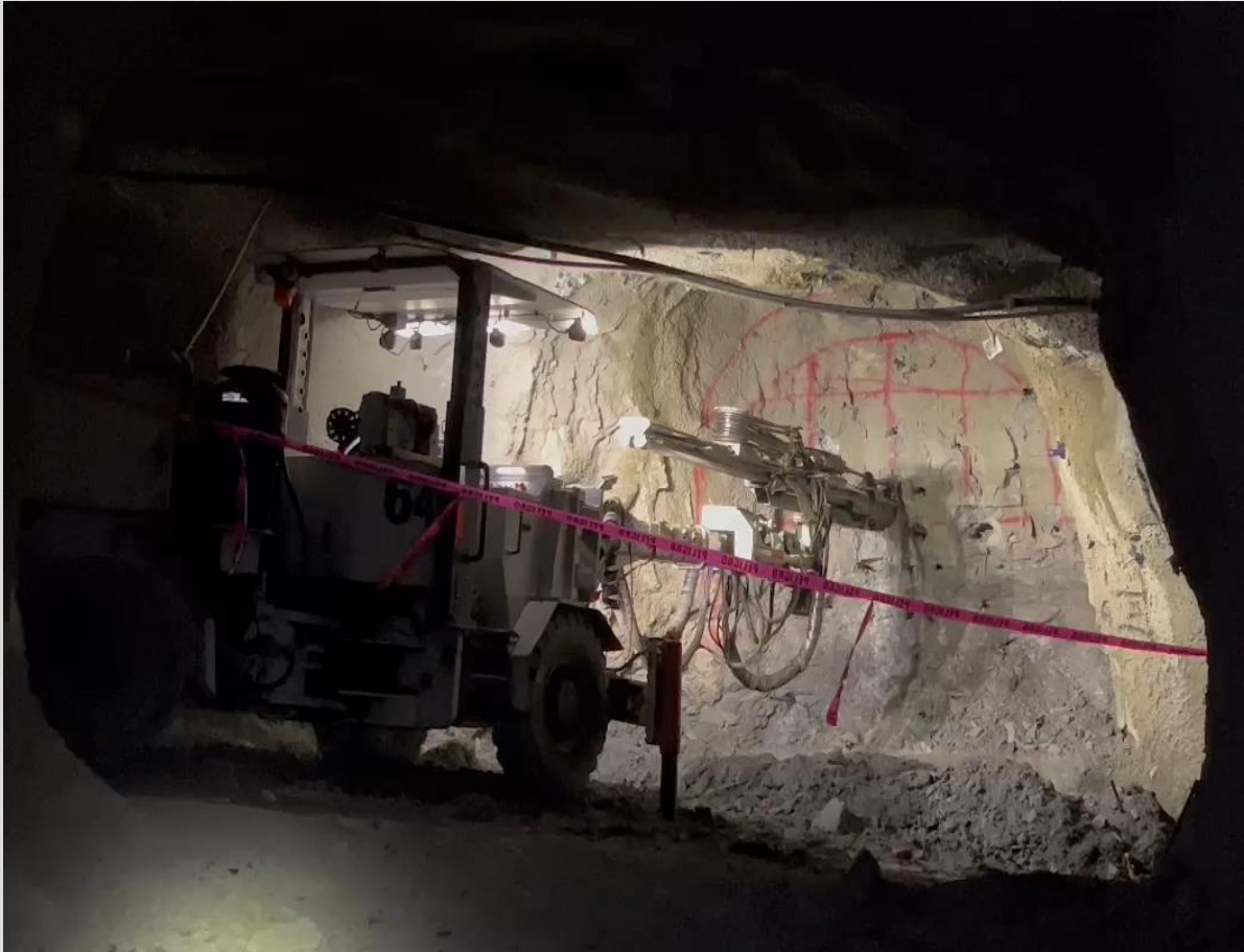
Video 1. Trabajos de barrenación de plantilla para voladura.
