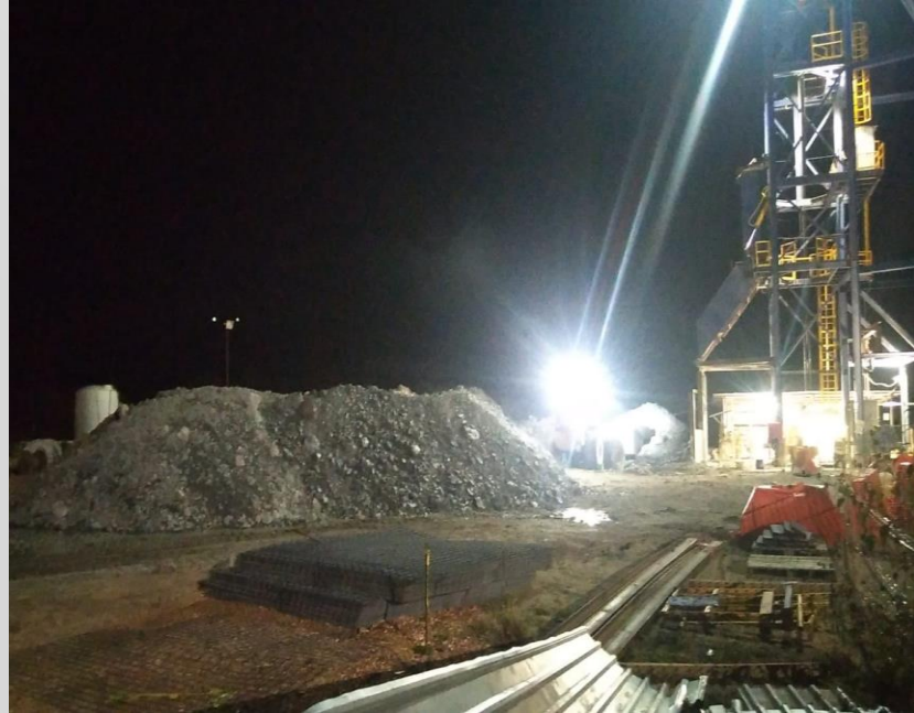
Foto 4. Material producto de la voladura.
