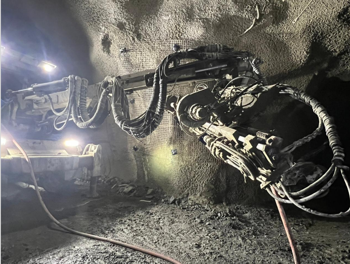
Foto 7. Actividades de anclaje y enmallado en el crucero 3 (rampa de acceso).
