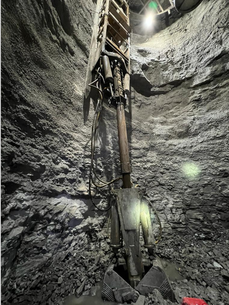
Foto 1. Materia producto de voladura y trabajos de rezagado.
