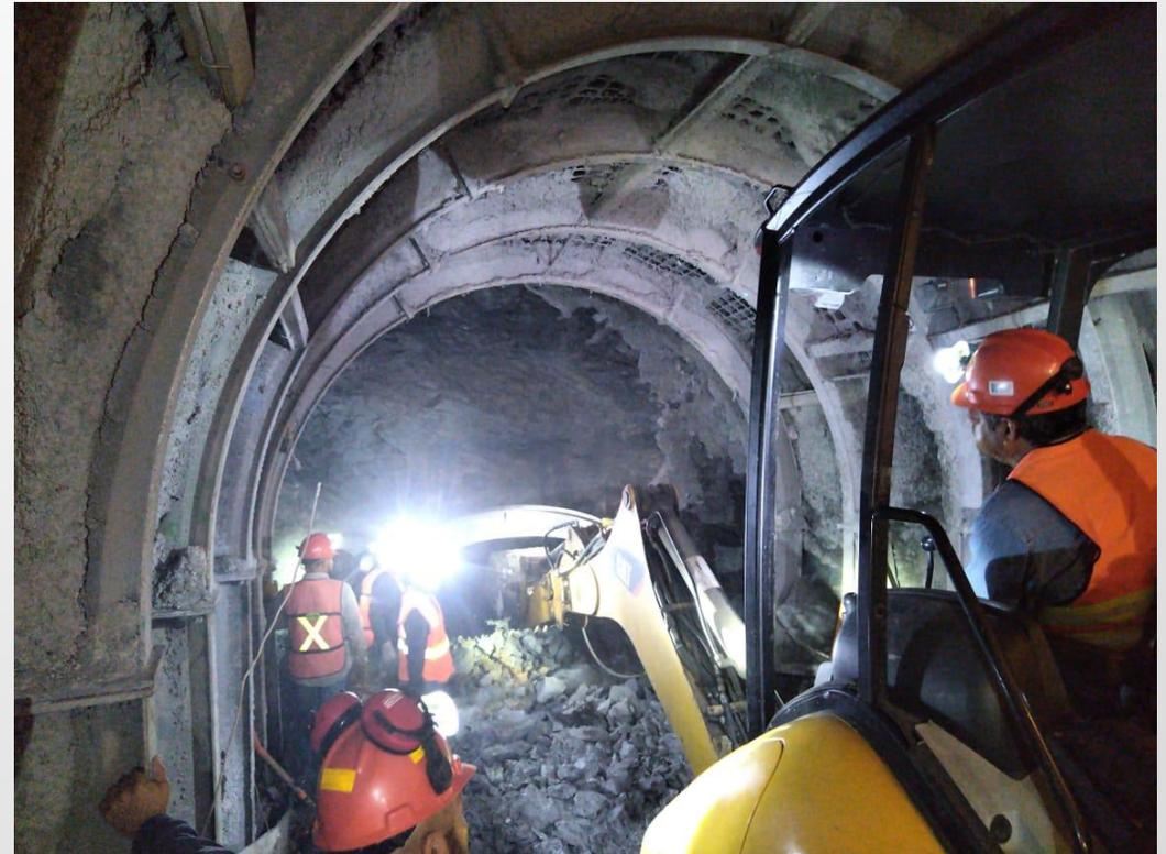
Figura 4: Excavación por medios mecánicos en el túnel de ventilación
