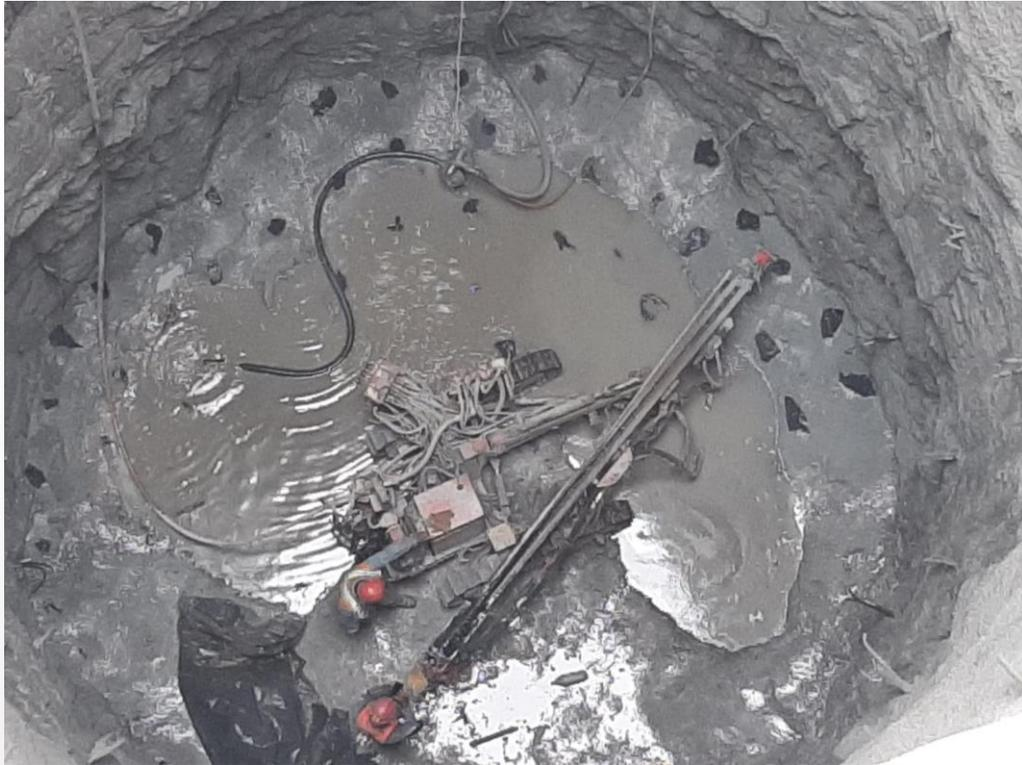
Figura 4: Trabajos perforación de barrenos para plantilla de voladura
