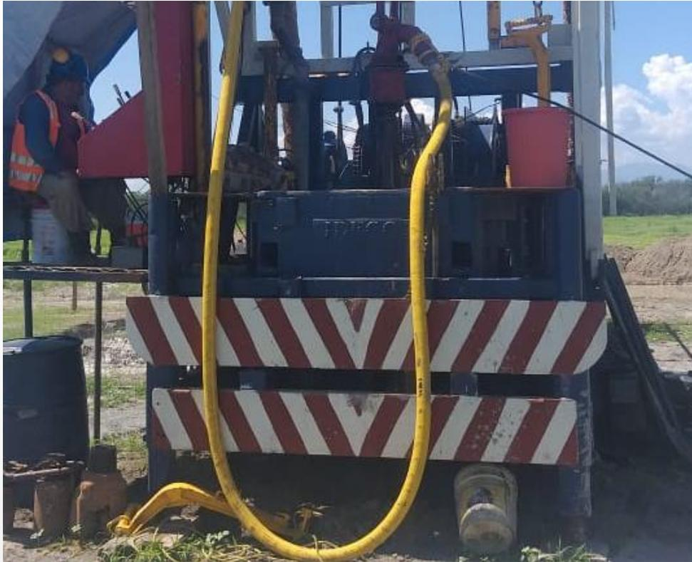
Figura 1: Trabajos de perforación del pozo PCE-04. Se tienen **92 m** de perforación con diámetro 12 ¼”.
