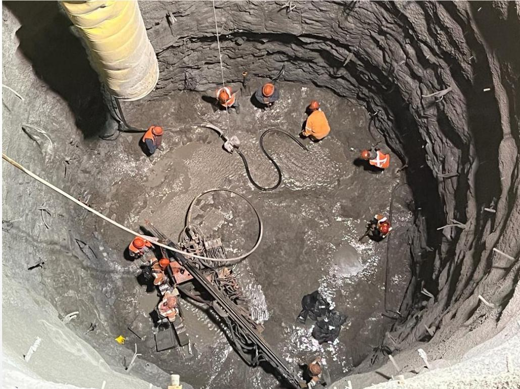
Figura 2: Trabajos perforación de barrenos para anclaje
