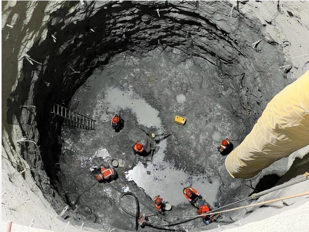
Figura 7: Perforación de barrenos plantilla para voladura en la lumbrera PCT-2.
