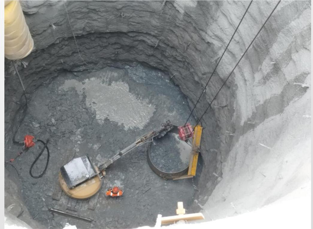
Figura 5: Rezaga de material producto de la voladura
