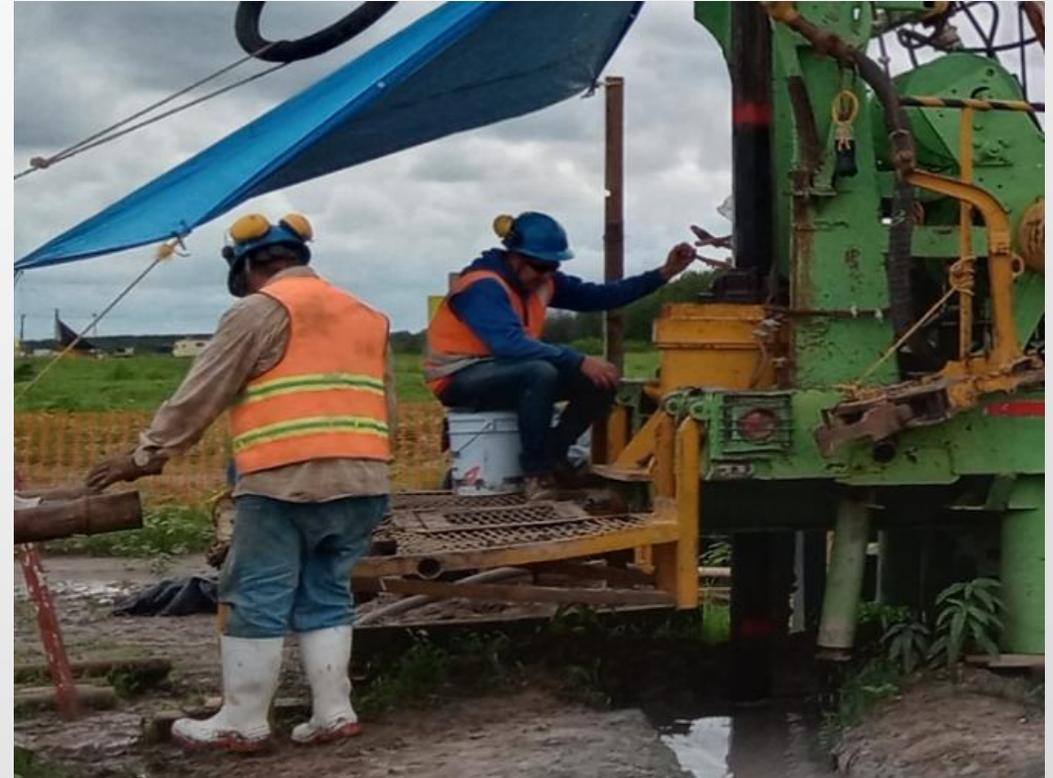
Figura 2: Trabajos de perforación del pozo PCV-3 A. Se tiene un avance de **100 m** de perforación con diámetro 12 ¼”.
