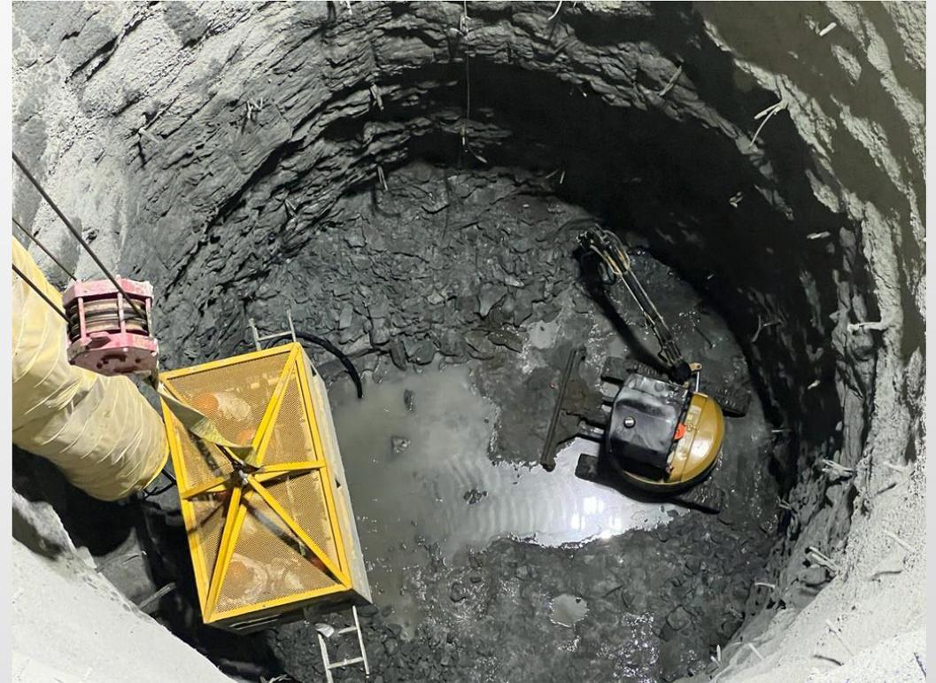
Figura 3: Perfilado por medios mecánicos de las paredes de la lumbrera PCT-1
