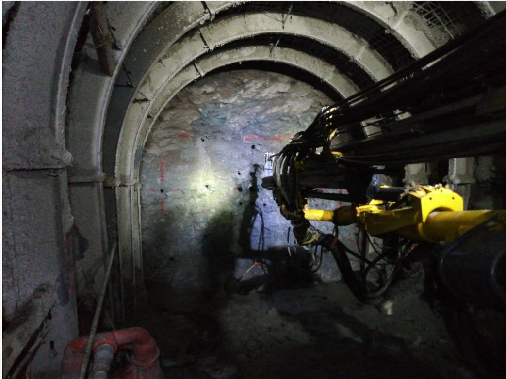
Figura 3: Barrenación de plantilla para voladura en túnel de ventilación.
