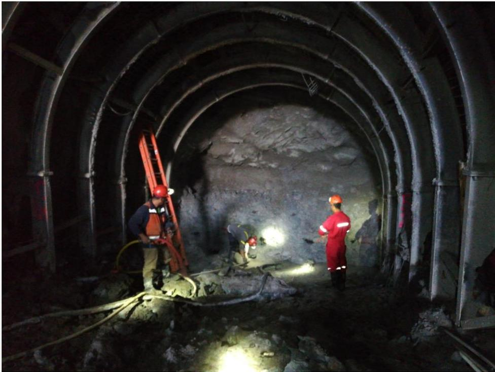
Figura 1: Barrenación de plantilla para voladura en túnel de acceso
