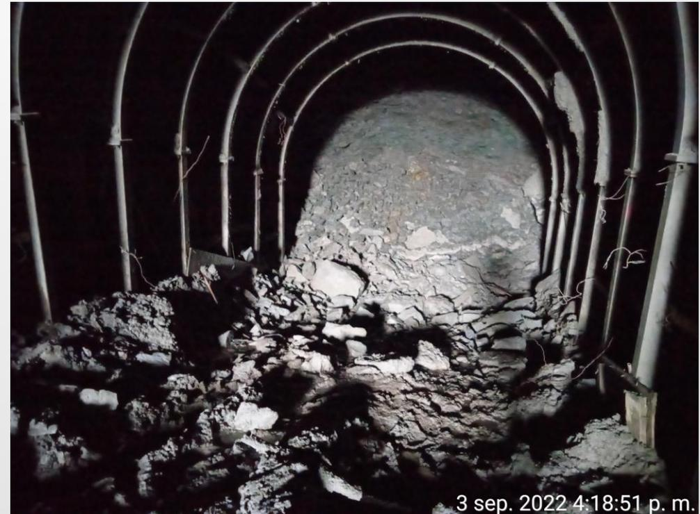
Figura 2: Producto de la excavación con explosivos en túnel de acceso.
