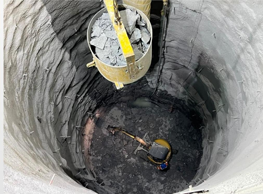
Figura 8: Retiro de material producto de la excavación mediante el sistema de rezagado en la lumbrera PCT-2
